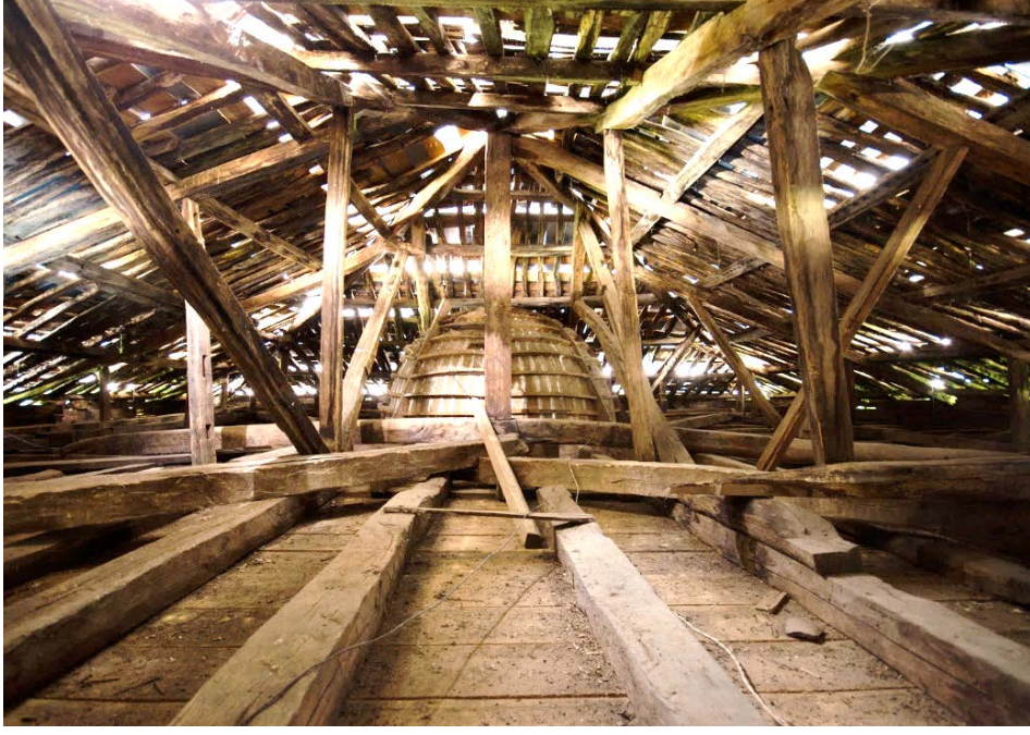
Şekil 5.14: Ghorcomi camii çatı taşıyıcı sistemi (url-10).
