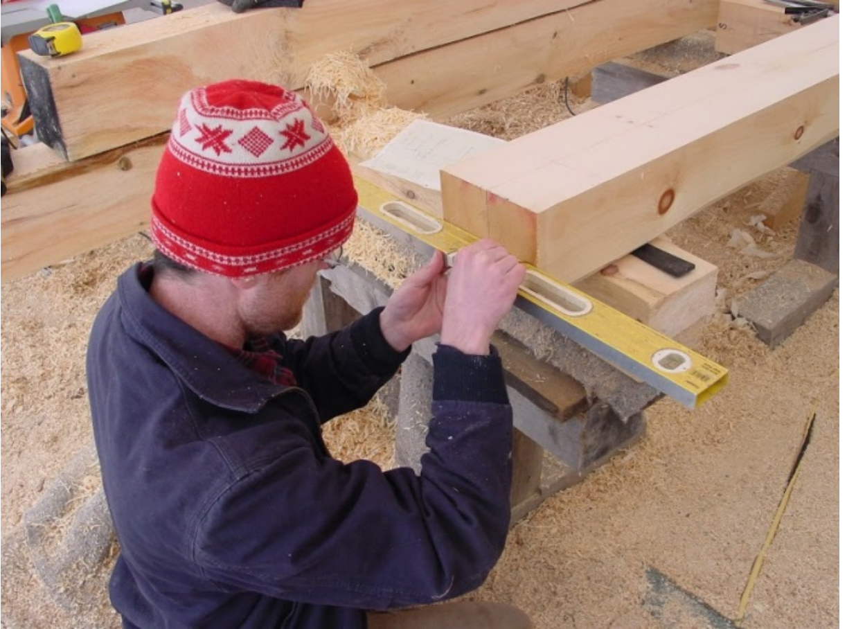
Şekil 4.4: Referans çizgilerinin çizilmesi (url-2).
