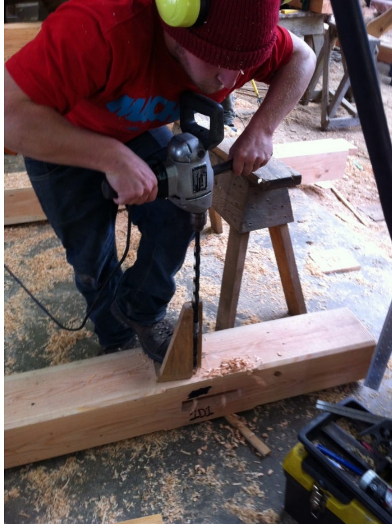
Şekil 4.15: Kavela deliklerinin açılması.
