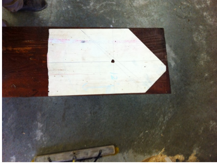
Şekil 4.19: Ahşap taşıyıcı imalatında kalıp kullanımı.
