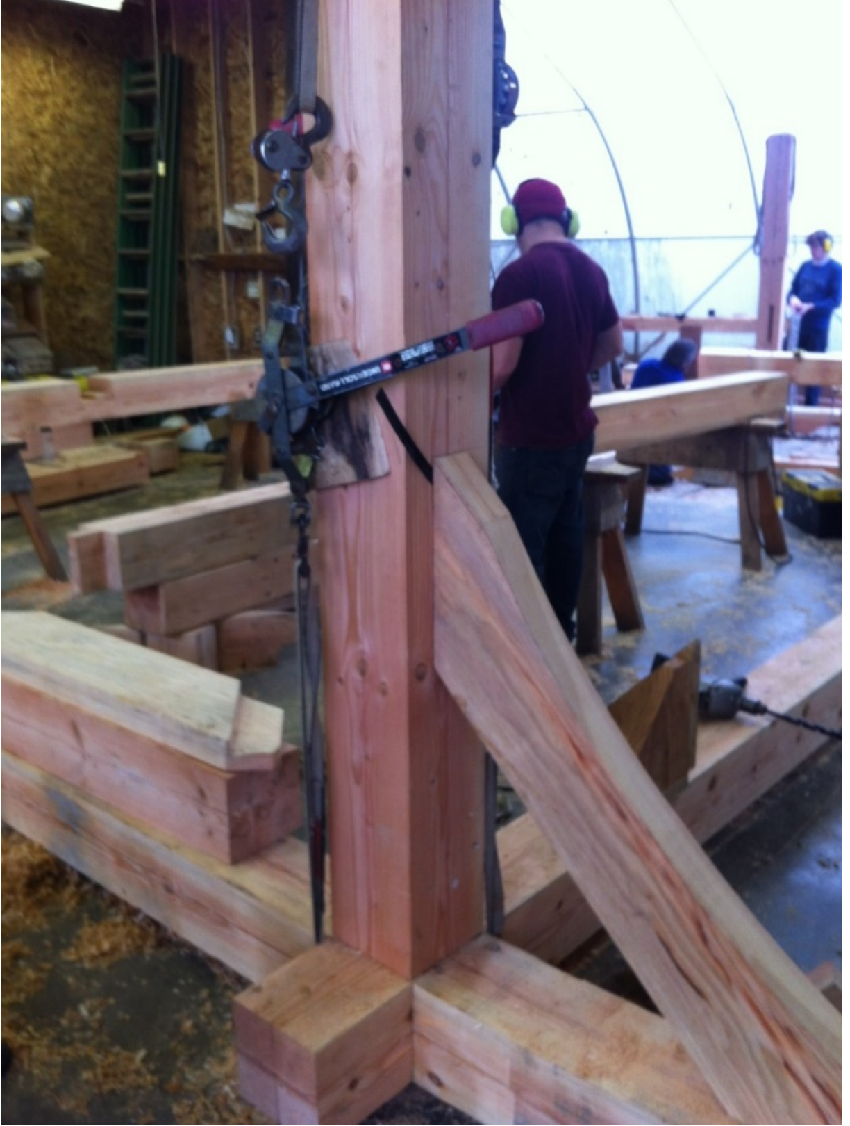
Şekil 4.12: Palanga ile ön birleşim yapılması.
