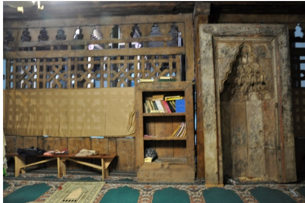
Şekil 5.5: Eşrefoğlu Camii'nde ahşap künde-kâri işçiliği (2014).
