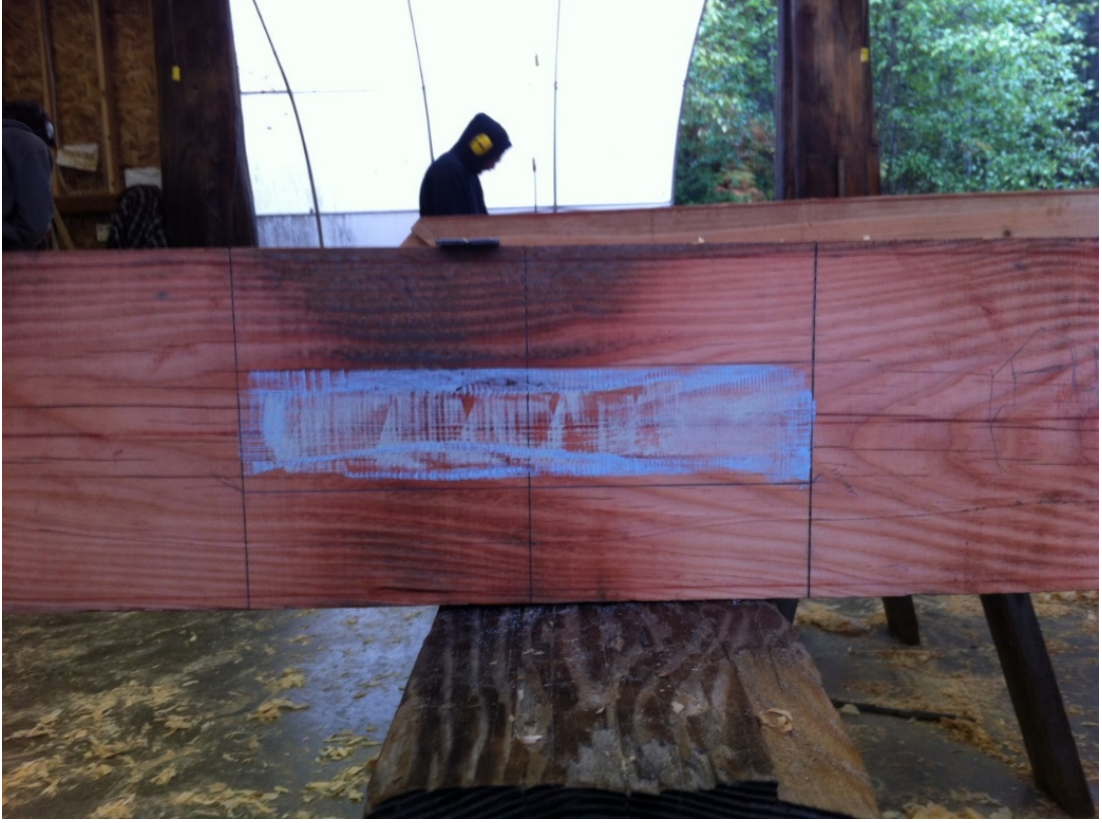
Şekil 4.8: Zıvana alanının işaretlenmesi ve boyanması.
