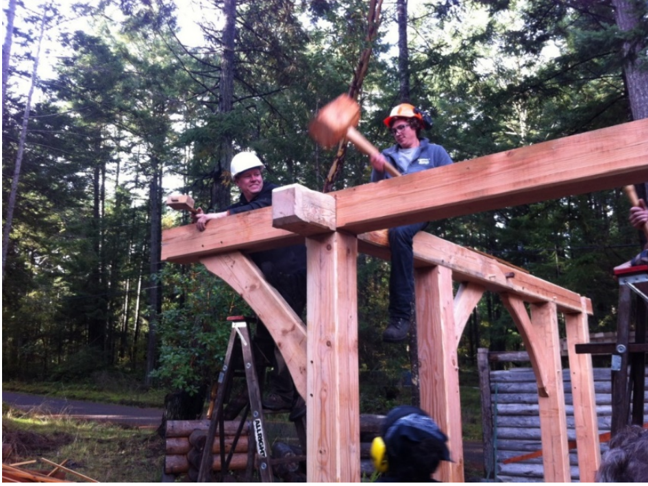
Şekil 4.17: Bileşenlerin ahşap balyoz ile birleştirilmesi.
