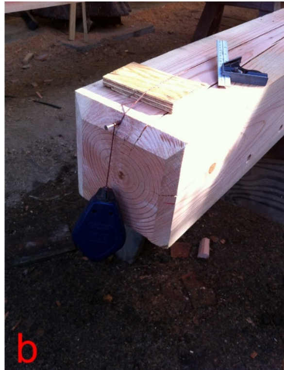
Şekil 3.6: Merkez hattı yönteminde; a) terazi kullanımı b) çırpı ipi kullanımı.
