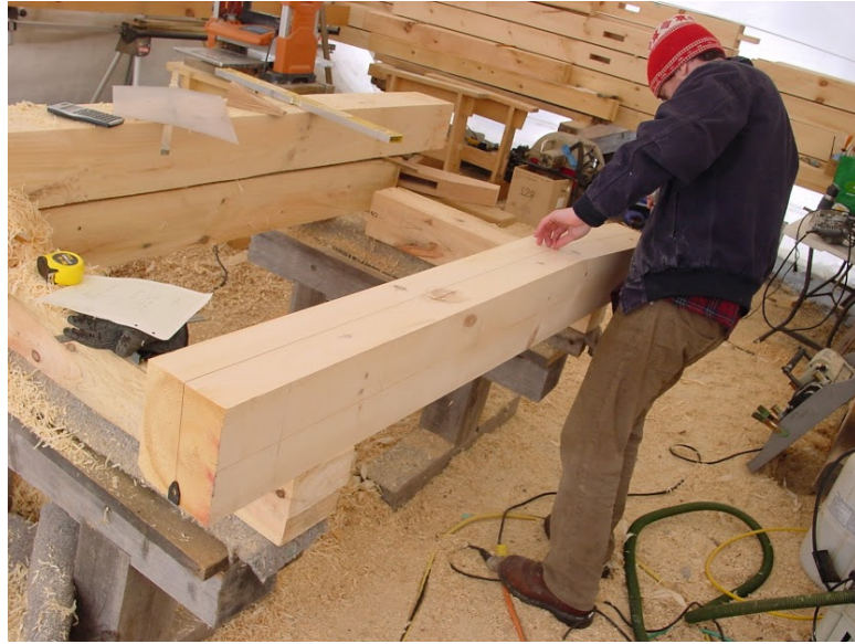
Şekil 4.6: Merkez hattının tesisi (url2).
