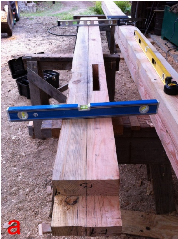
Şekil 3.6: Merkez hattı yönteminde; a) terazi kullanımı b) çırpı ipi kullanımı.
