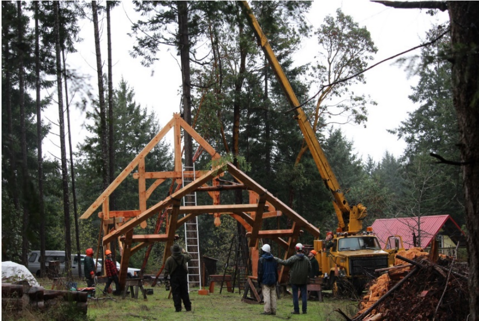
Şekil 4.18: Bileşenlerin yerde birleştirilip ayağa kaldırılması.
