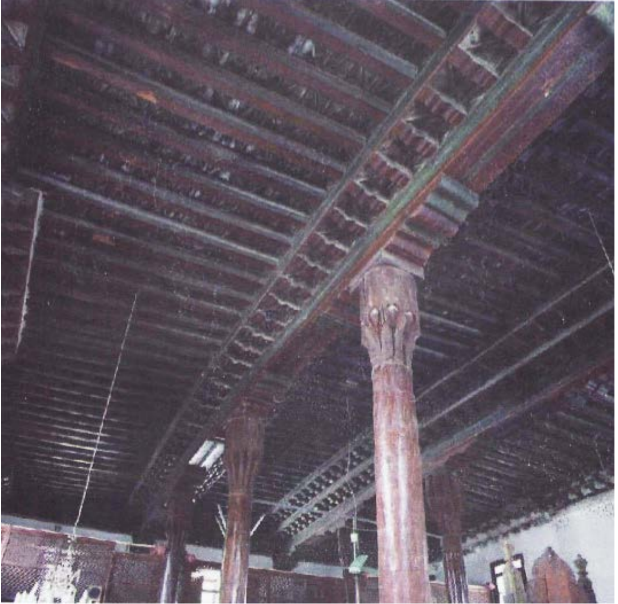
Şekil 5.12: Ayaş Câmii ahşap taşıyıcı elemanları (Karaçağ, 2010, s.119).
