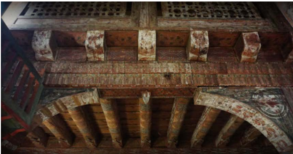
Şekil 5.21: Mahmutbey Câmii ahşap birleşimler (url-13).
