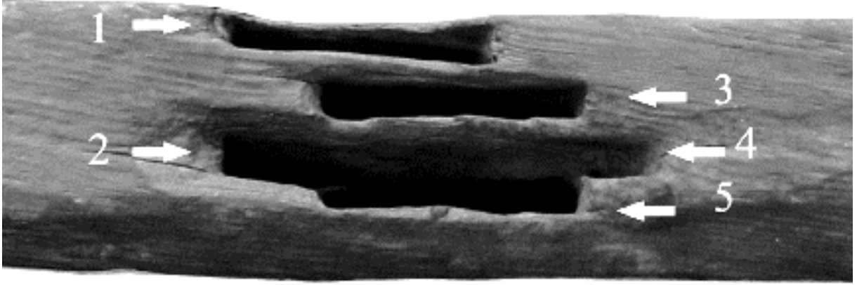
Şekil 2.18: Eski Mısır gemisinde kullanılan düz zıvanalar (Creasman, 2010, s.97).
