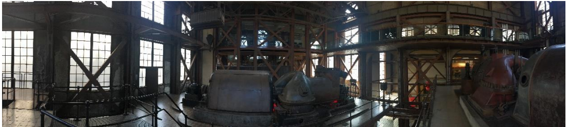
Şekil 63 Santral İstanbul müze işlevinde endüstriyel ekipmanların farklı açıdan panoramik görünümü
