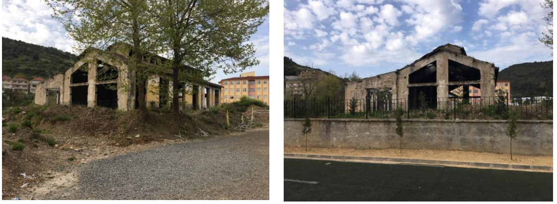
Şekil 109 Atölye binası güney cephe görüşleri
