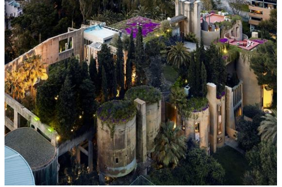
Şekil 19 Yeniden İşlevlendirilme sonrası Fabrika yapısı (Hudson, 2017)
