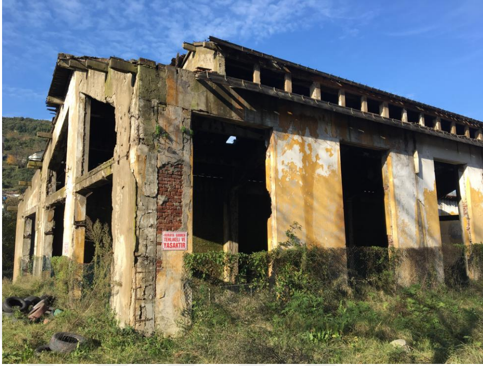
Şekil 105 Atölye binası güneybatı cephesi
