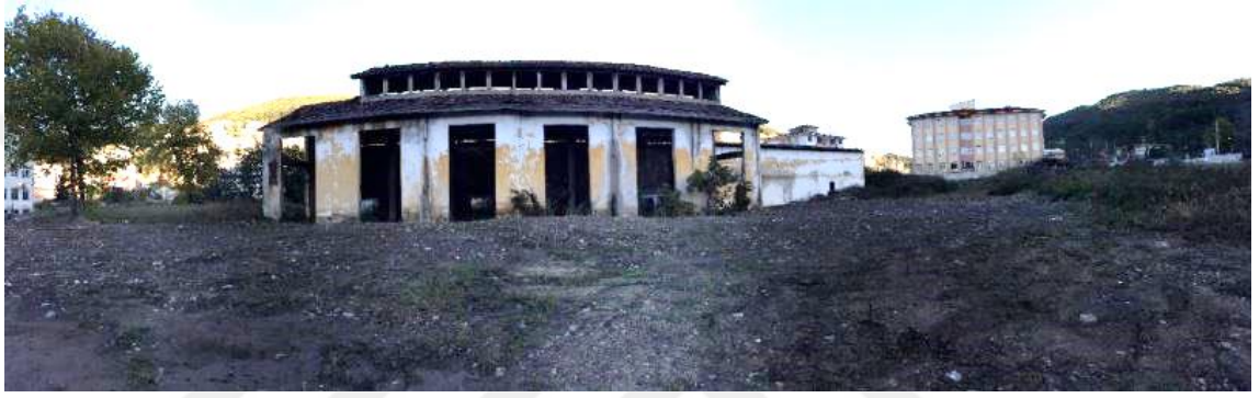
Şekil 118 Ereğli TCDD Lokomotif Bakım Atölyesi
