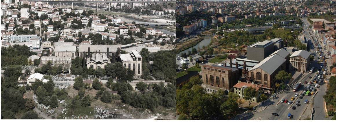
Şekil 55 Santral İstanbul Projesi öncesi ve sonrası hava fotoğrafları (Arkitektüel, 2018)
