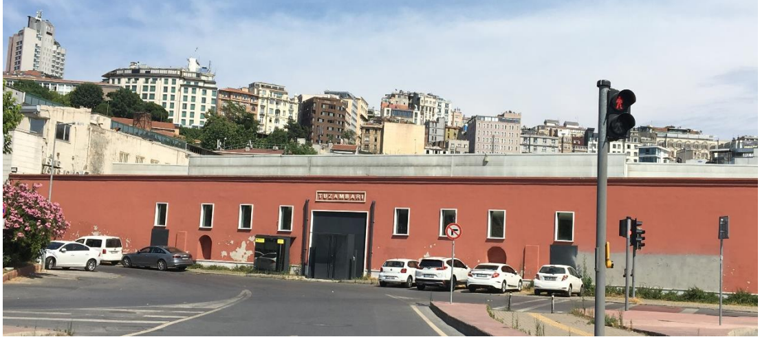
Şekil 64 Tuz ambarı giriş cephesi
