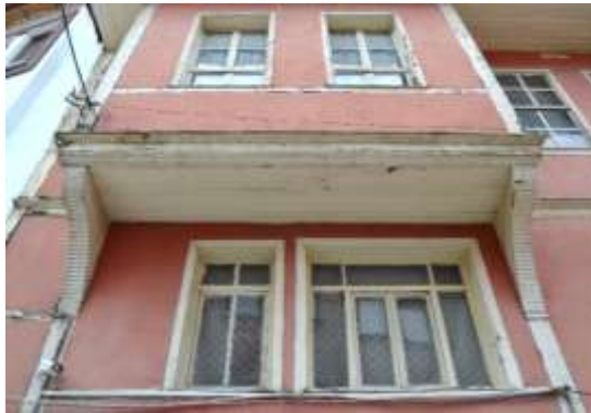
Şekil B. 35.1-04 numaralı oda penceresi, dış görünüş (Ocak, 2019).
