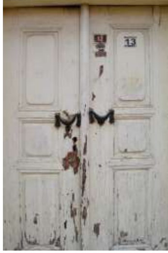
Şekil B. 96. Kütahya Konağı ahşap ana giriş kapı kanatları (Ocak, 2019).
