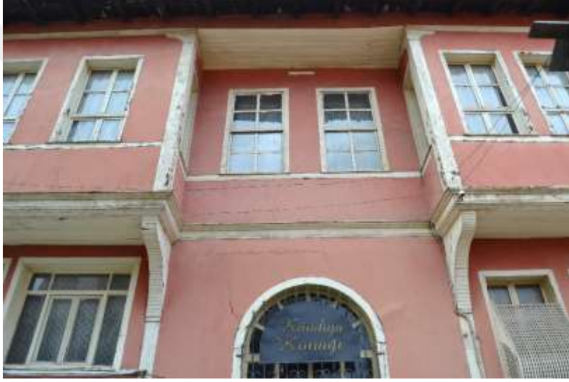
Şekil B. 88. Kütahya Konağı güneydoğu cephesi çıkma düzeni (Ocak, 2019).
