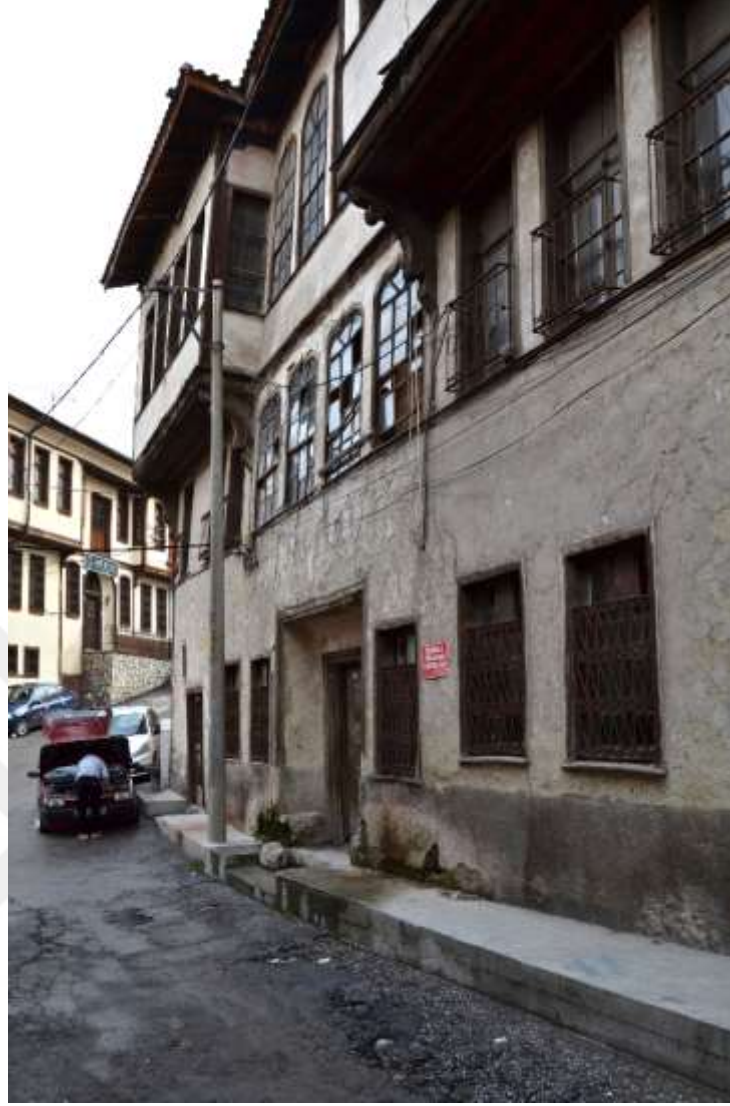
Şekil C. 5. 99 ada 33 parsel konut yapısı giriş cephesi (Ocak, 2019).
