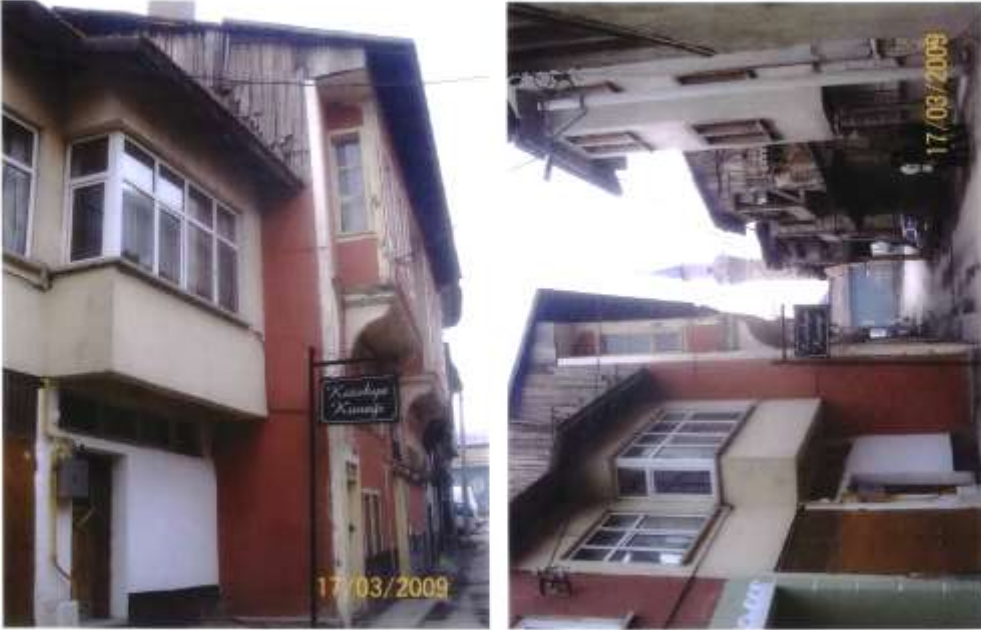
Şekil A. 10. Kütahya Konağı 2009 yılına ait cephe fotoğrafları. (Kütahya Kültür Varlıklarını Koruma Bölge Kurulu Müdürlüğü)
