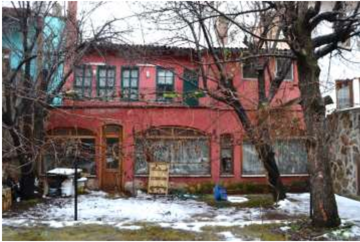
Şekil B. 83. 2-07 numaralı mutfak pencerelerinin kuzeybatı cephesinde görünüşü (Ocak, 2019).
