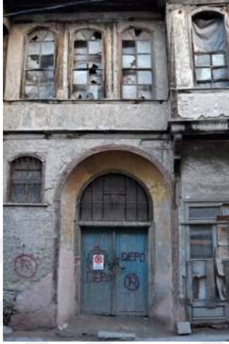
Şekil 4. 10. 106 ada 80 parsel konut yapısı ana giriş kapısı (Mayıs, 2018).
