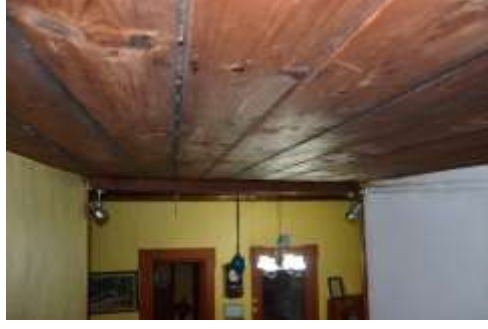
Şekil B. 79. 2-05 numaralı merdiven holü tavanı ile divanhâne tavanı arasındaki geçiş (Eylül, 2018).
