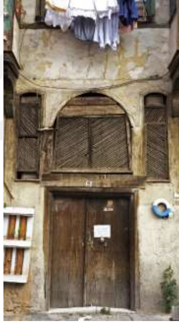
Şekil 4. 8. 141 ada 19 parsel konut yapısı (Eylül, 2018).
