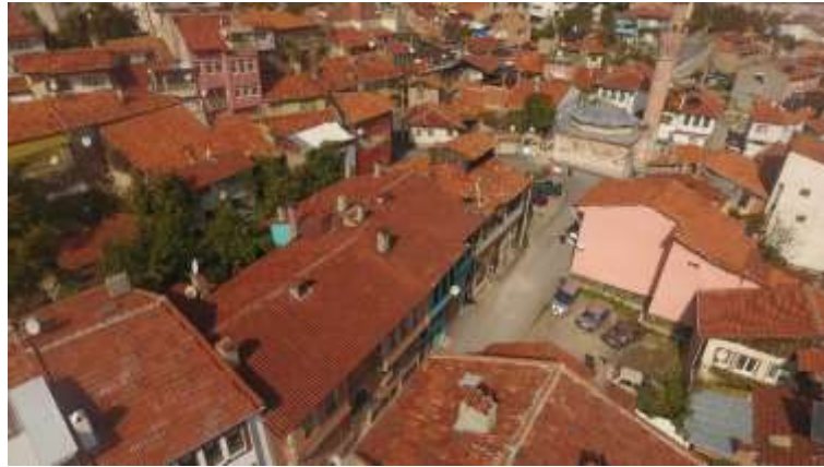
Şekil B. 7. Çatının orta aksında bulunan yükselti (Kasım, 2019).
