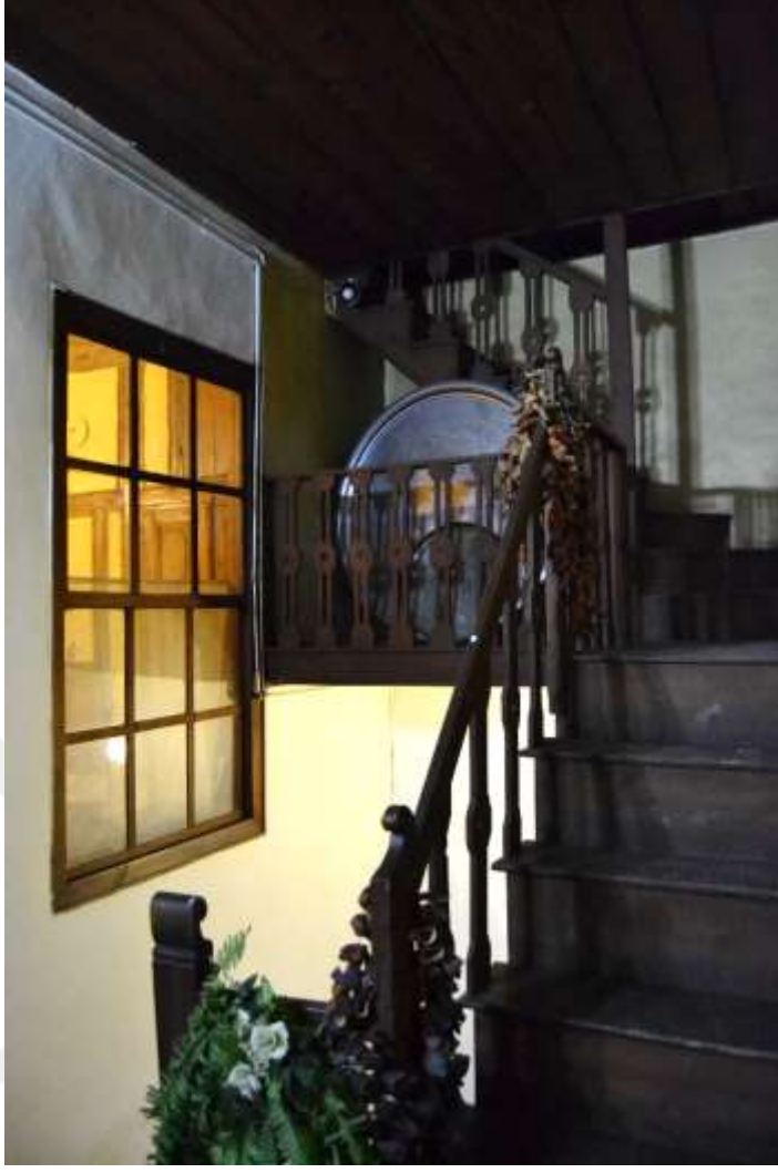
Şekil B. 82. 2-05 numaralı merdiven holü ile 2-04 numaralı oda ilişkisinin sağlayan ahşap giyotin pencere, holden bakış (Eylül, 2018).
