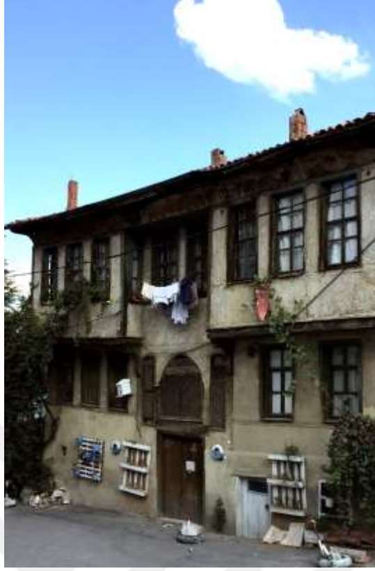
Şekil C. 3. 141 ada 19 parsel konut yapısı giriş cephesi (Ocak, 2019).
