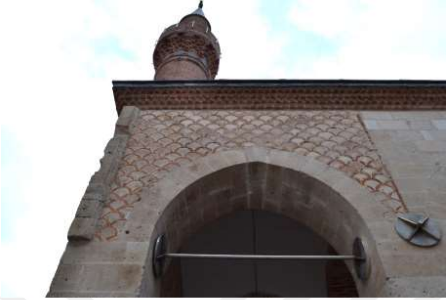
Şekil 2. 29. 2017 yılı onarımında eklenen güçlendirme (Şubat, 2019).
