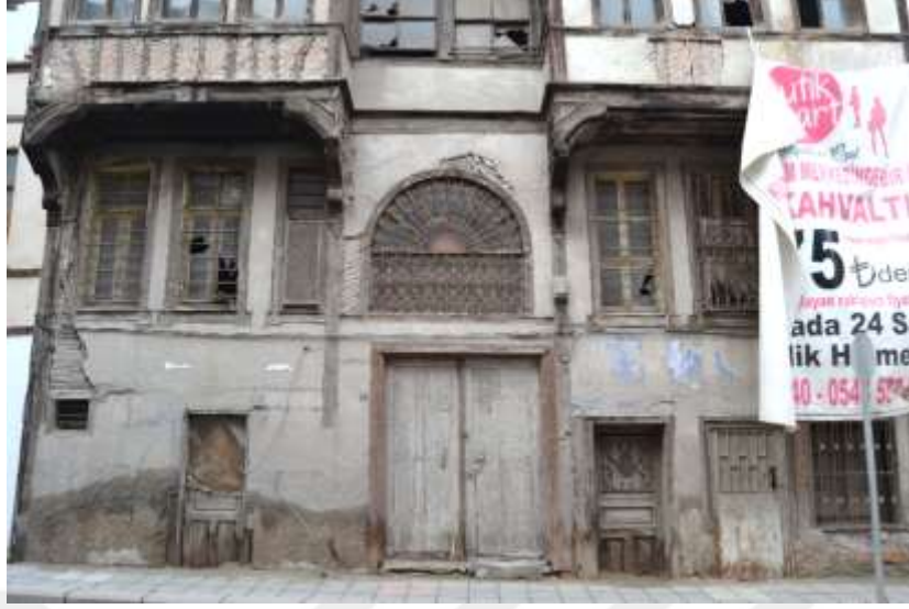
Şekil C. 1. 84 ada 38 parsel konut yapısı giriş cephesi (Ocak, 2019).
