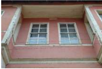
Şekil B. 48. 2-01 numaralı divanhane ahşap giyotin pencereleri, güneydoğu cephesi görünüş (Ocak, 2019).
