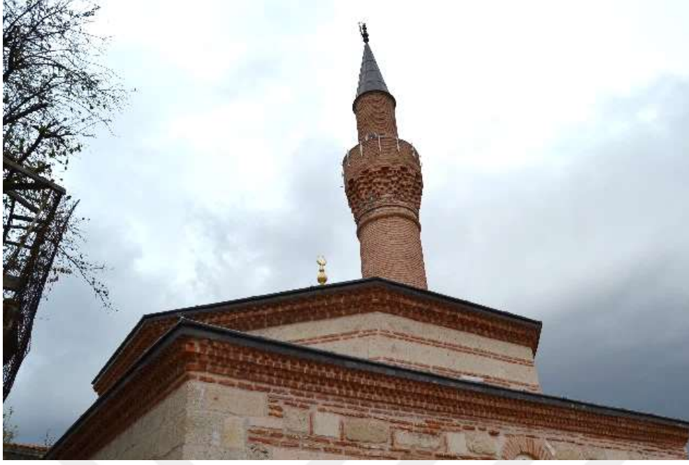
Şekil 2. 33. Kurşunlu Camii kare mekan ve kasnak üzerinde yer alan kirpi saçak (Şubat, 2019).
