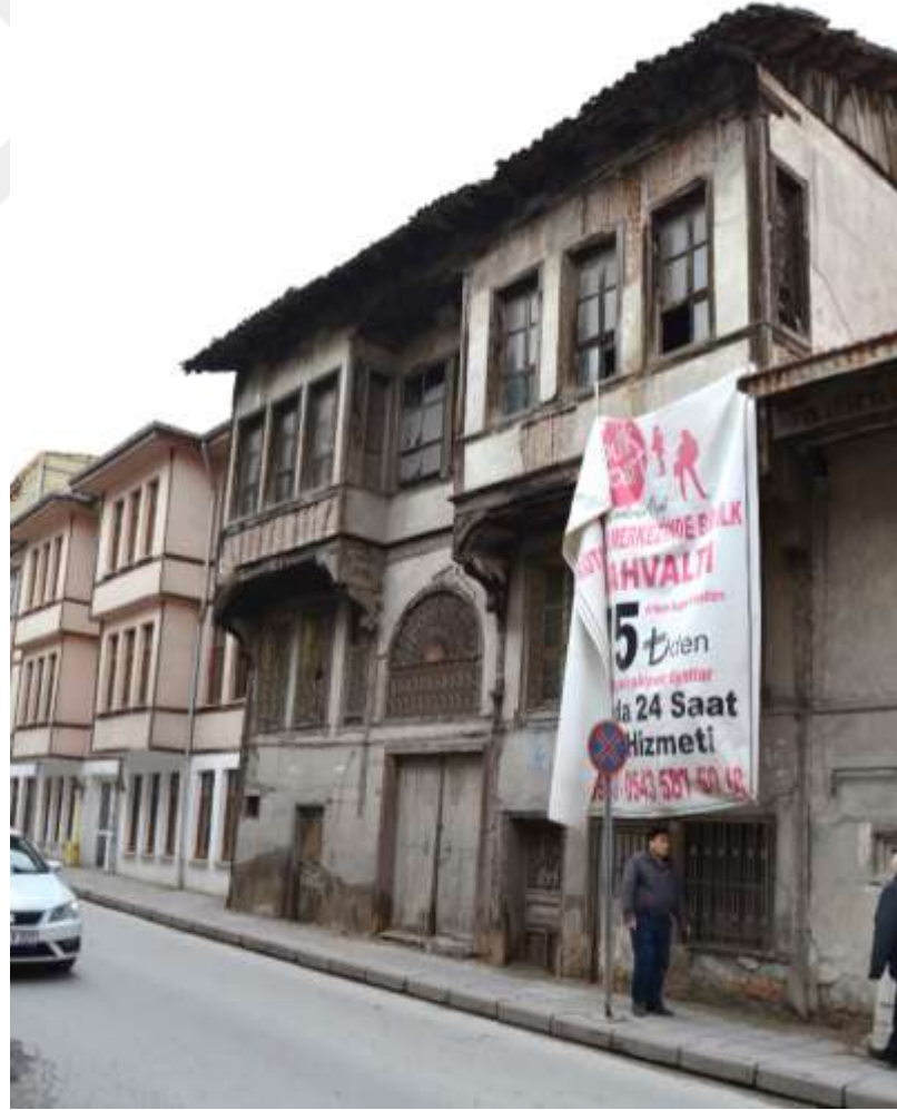
Şekil C. 2. 84 ada 38 parsel konut yapısı çıkma düzeni (Ocak, 2019).
