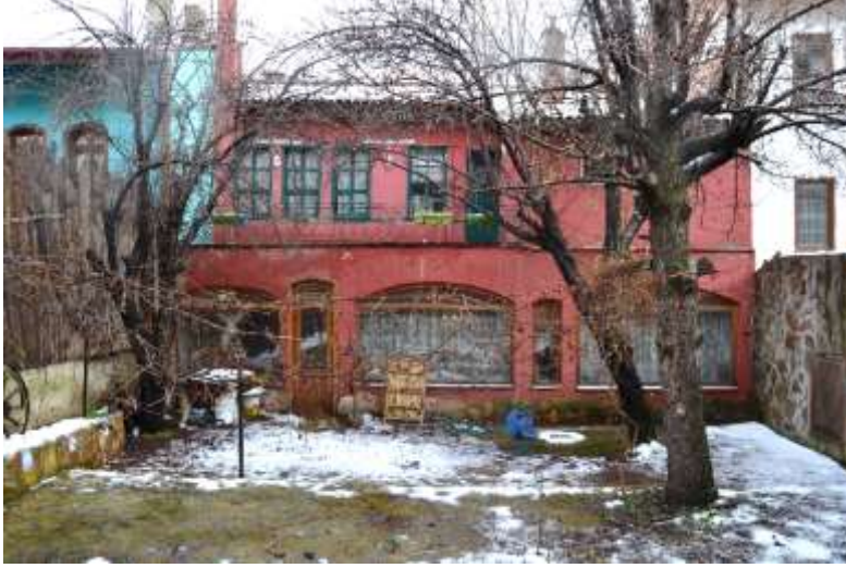
Şekil B. 93. Kütahya Konağı kuzeybatı cephesi (Ocak, 2019).
