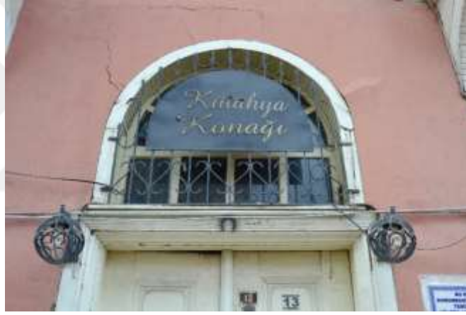
Şekil B. 16. Ana giriş kapısı tepe penceresi dış görünüş (Eylül, 2018).
