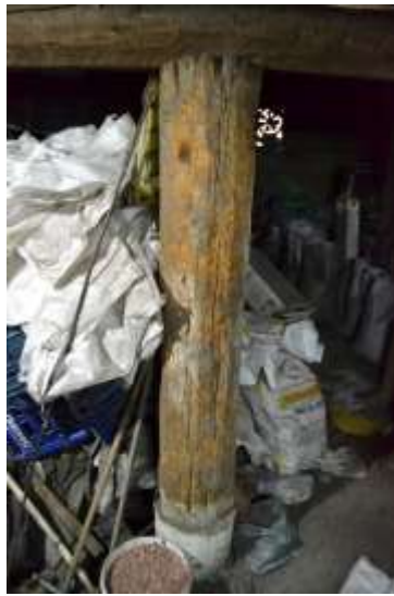
Şekil B. 20. Z-03 numaralı kazan dairesi ahşap taşıyıcı (Ocak, 2019).
