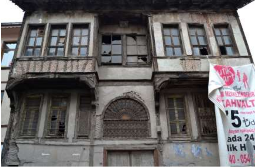
Şekil 4. 6. 84 ada 38 parsel konut yapısı (Ocak, 2019).
