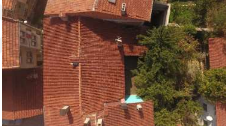
Şekil B. 6. Yapıda bulunan dört bacanın görünüşü (Kasım, 2018).
