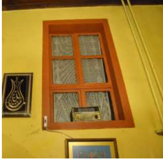
Şekil B. 18. Z-01 giriş holü ile 1-03 numaralı oda arasında bağlantı kuran ahşap pencere (Eylül, 2018).
