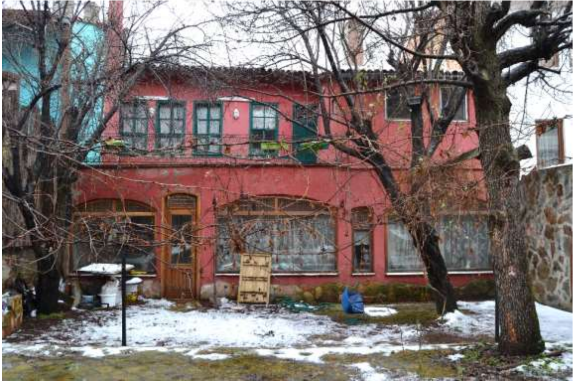
Şekil B. 39. 1-07 numaralı tahtaboş ile 2-08 numaralı teras, kuzeybatı cephesi görünüşü (Ocak, 2019).
