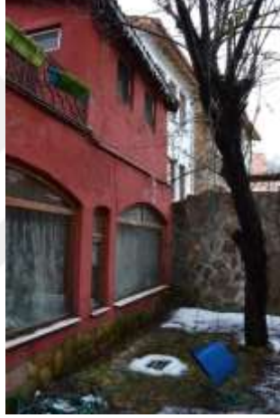
Şekil B. 94. 1-07 numaralı tahtaboşa ait açılır ve sabit pencereler, kuzeybatı cephesi görünüşü (Ocak, 2019).
