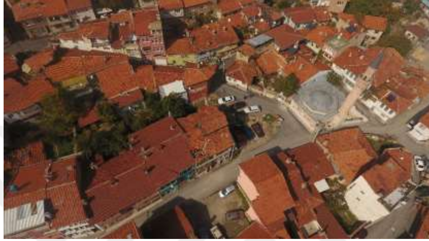
Şekil 2. 28. Kurşunlu Sokak üzerinde yer alan Kütahya Konağı ve Kurşunlu Camii (Eylül, 2018).
