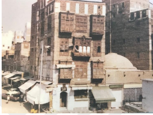
Şekil 3.87.: Gışaşiye Mahallesi’nde bulunan Sultan Süleyman Han Hamamı (Chaudhry, 2011, s. 38)
