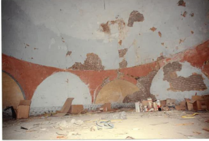
Şekil 3.92.: Camekân kısmının kubbesinin içten görünüşü (Prof. Dr. İbrahim Numan Arşivinden)
