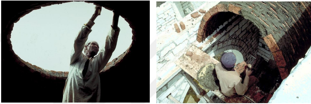
Şekil 2. 2: Nübyeli ustalar kubbeyi ve tonozları tamamlarken, Murad Greiss Evi, 1980
