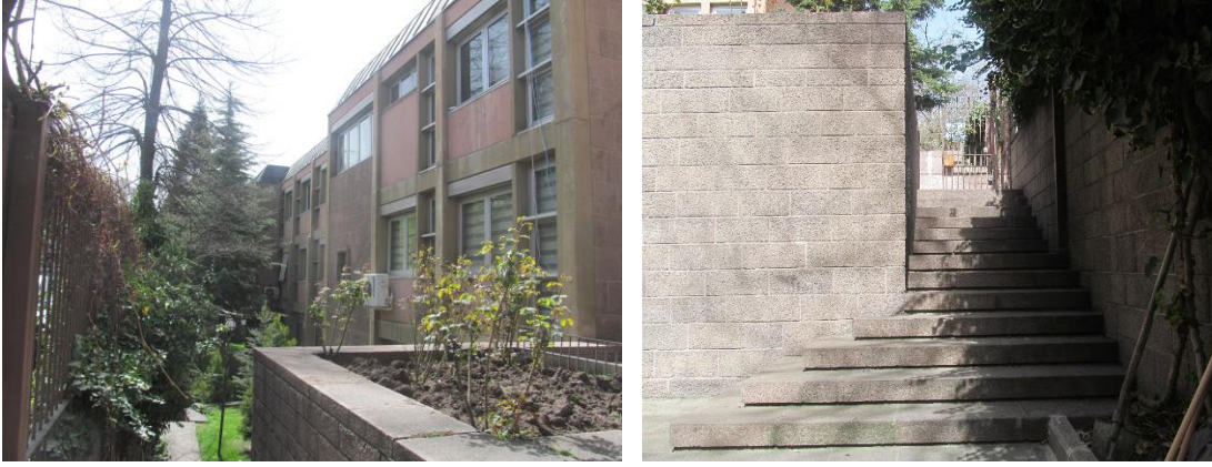
Şekil 2.14: TTK Binası doğu cephesinde, kot farkının çömlemesine dair çephe-iç bahçe ilişkisi
