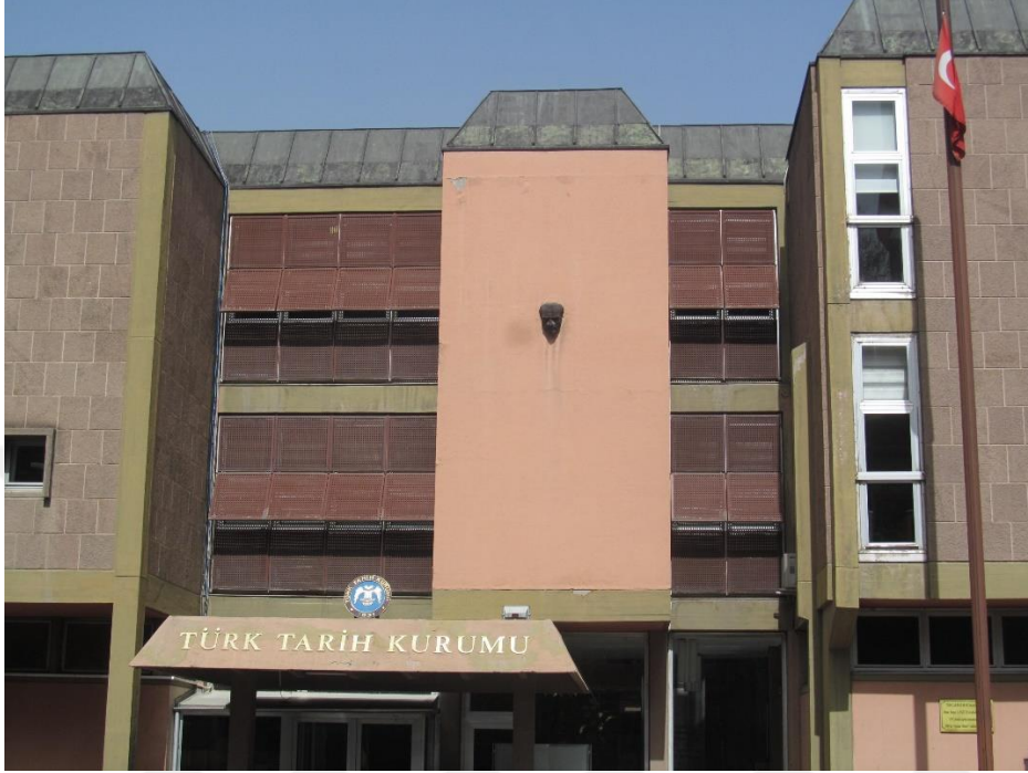
Şekil D.1: Türk Tarih Kurumu binası kuzey cephesi
