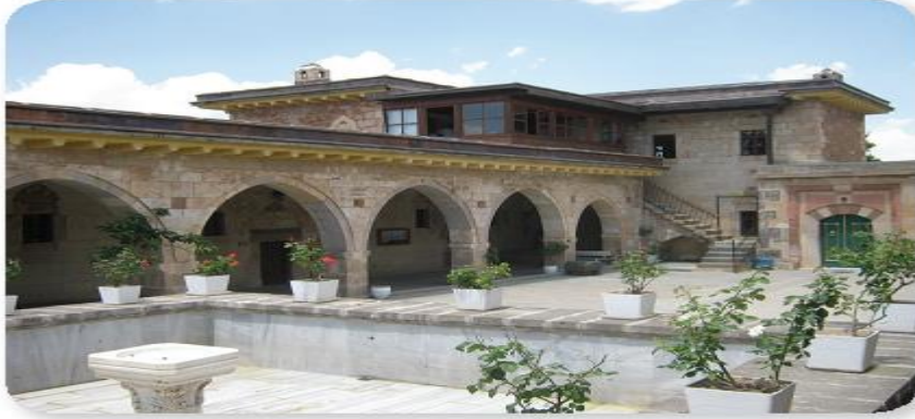
Hacı Bektaş Veli Türbesi / Nevşehir
