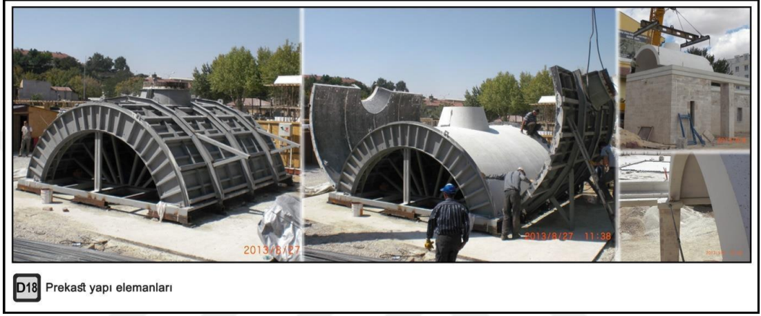
Şekil 3.19: Prekast tonozların imalatı ve yerleştirilmesi
