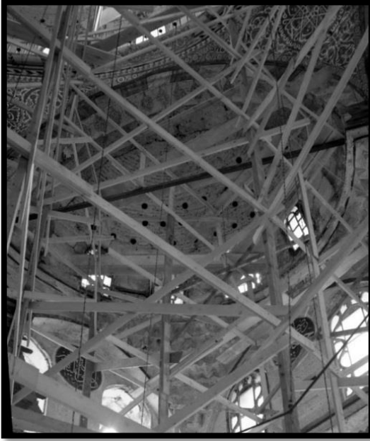
Fotoğraf 152: Güneybatı yarım kubbesinin restorasyon sırasında kazınmış hali
