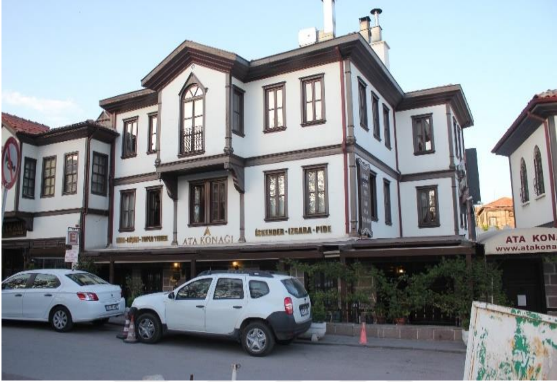
Şekil 4.58. 10 numaralı evin dış cephe fotoğrafı
