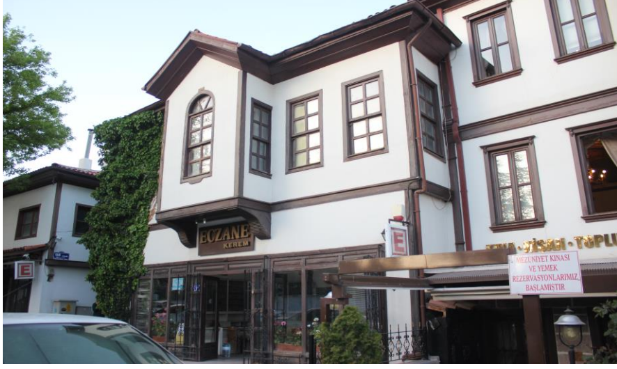
Şekil 4.50. 9 numaralı evin dış cephe fotoğrafı
