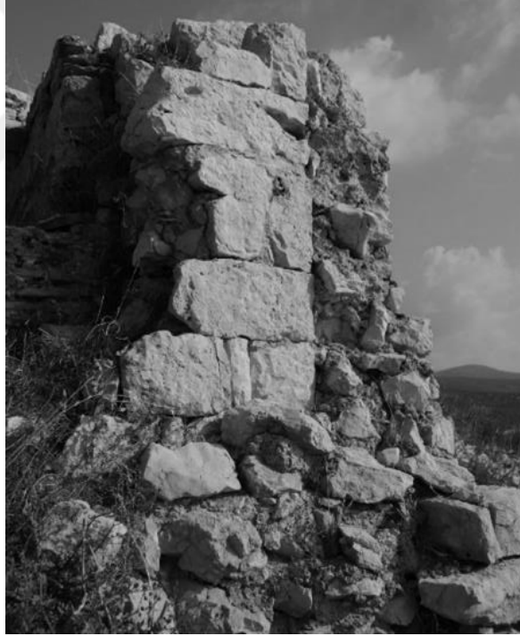
Şekil C. 81. Güney Sarnıç'ın güçlendirilmiş doğu duvarı, 2017 (©BOGA Arşivi).
