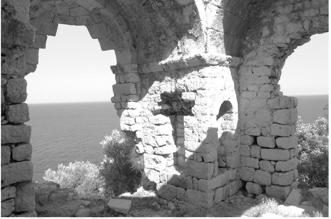
Şekil C. 57. Naosun güneydoğu köşesindeki paye (Solda doğu kaç kolunun güney duvarı üzerindeki düz atkılı niş; sağda güney haç kolunun doğu duvarı üzerindeki kemerli niş), 2010 (©BOGA Arşivi).
