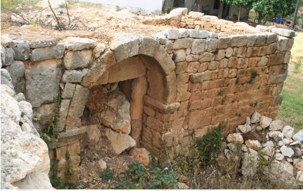
Şekil D. 29. Hasanaliler Kilisesi'nin platformlarından biri. Tonozun başlangıcındaki silmenin Boğsak Adası'ndaki Platform ile aynı profilde olması dikkat çekicidir (Fotoğraf: Salih Saydam, e.t.: 11.03.19, e.a.: http://www.salihsaydam.com/mersin/hasanalilerkilisesi1_tr.html ).
