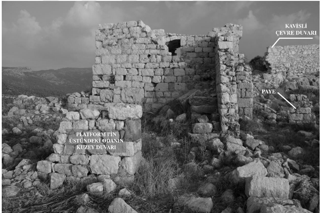
Şekil C. 66. Yapının güney cephesi, 2017 (©BOGA Arşivi).
