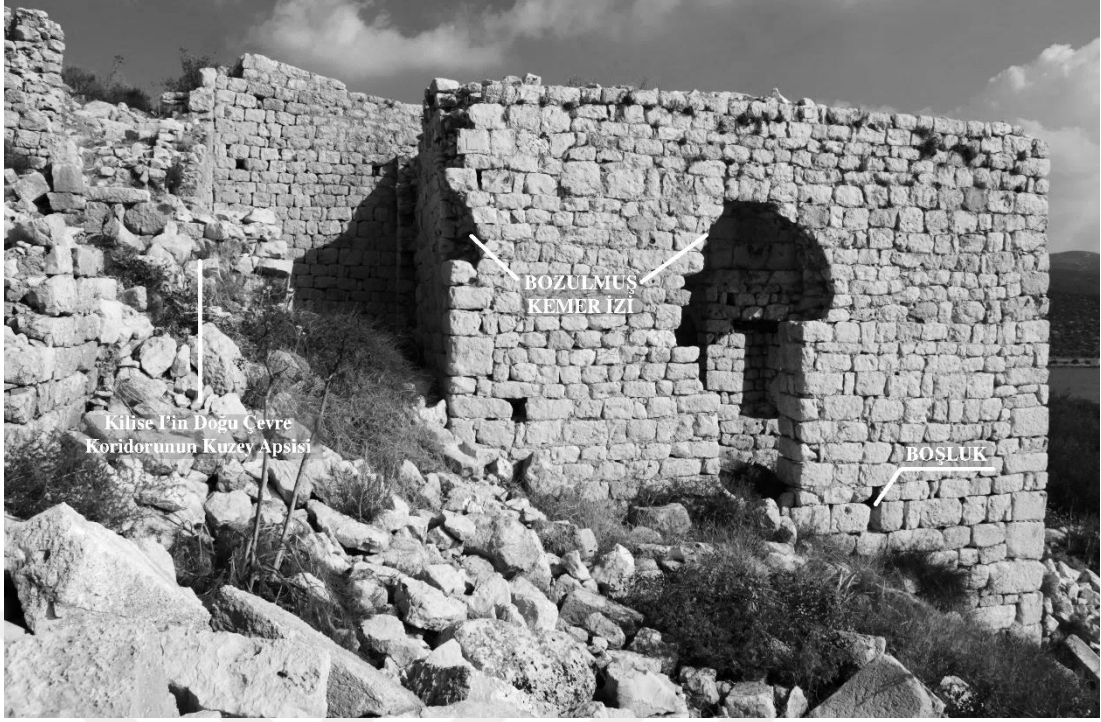
Şekil C. 41. Yapının güney cephesi, 2017 (©BOGA Arşivi).
