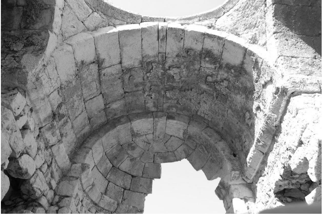
Şekil C. 58. Apsisin yarım kubbesi ve doğu haç kolunun beşik tonoz örtüsü, 2010 (©BOGA Arşivi).
