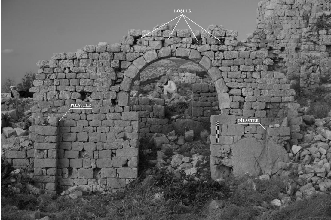
Şekil C. 11. Naosun batı duvarındaki ana giriş kapısı ve kapının her iki yanındaki pilasterler, 2017 (©BOGA Arşivi).
