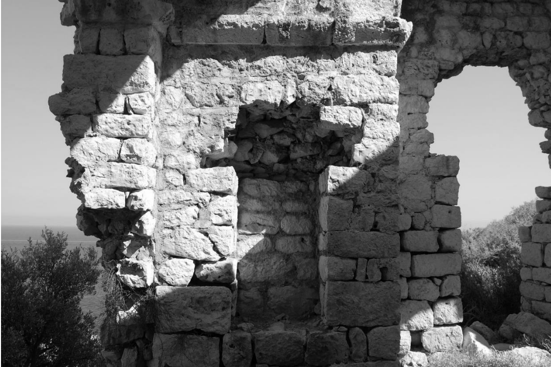
Şekil C. 60. Doğu haç kolunun güney duvarı üzerindeki düz atkılı niş, 2010 (©BOGA Arşivi).
