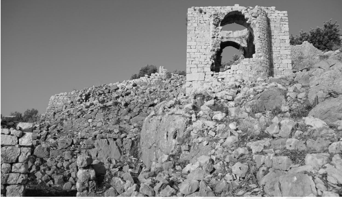
Şekil C. 43. Yapının doğu cephesi, 2013 (©BOGA Arşivi).
