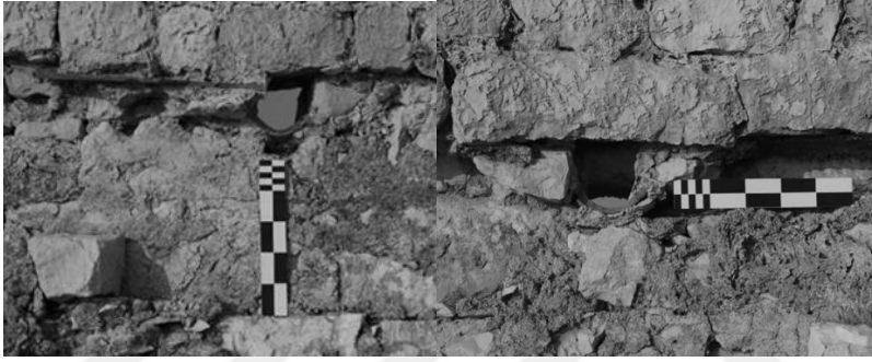
Şekil C. 72. Doğu cephesi üzerindeki künkler. Sırasıyla güneydeki ve kuzeydeki künk, 2017 (©BOGA Arşivi).
