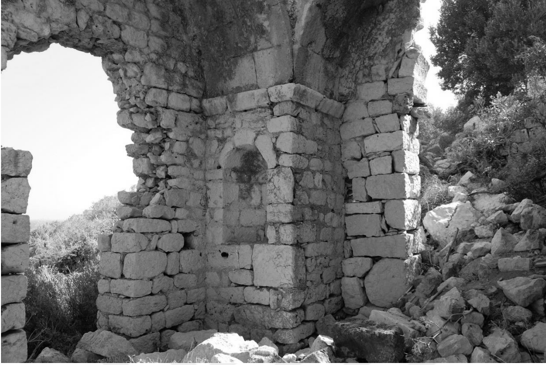
Şekil C. 55. Naosun güneybatı köşesindeki paye (Güney haç kolunun batı duvarı üzerindeki niş (Solda güney haç kolunun batı duvarı üzerindeki kemerli niş; sağda batı haç kolunun güney duvarı), 2010 (©BOGA Arşivi).
