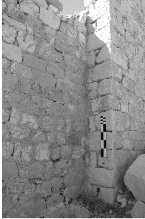
Şekil C. 48. Narteksin kuzey duvarı ile naosun kuzey cephesinin birleşimi, 2017 (©BOGA Arşivi).
