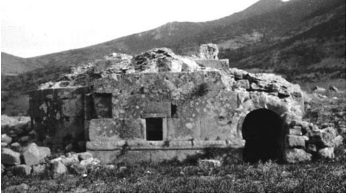
Şekil D. 34. Binbirkilise 12 numaralı yapının kuzey cephesi (Bell, 1907, NUGBA Albüm H).
