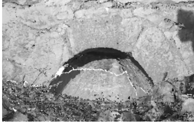
Şekil C. 93. Platform 1'in güney cephesinde konumlanan tanımlanamayan niş, 2016 ortofotosu.
