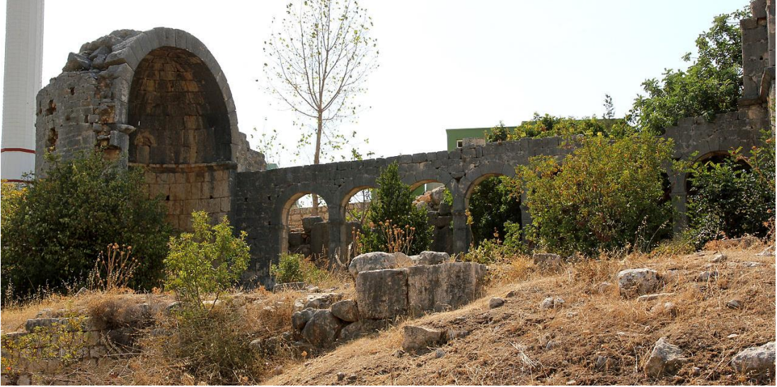
Şekil D. 25. Hasanaliler Kilisesi'nin apsisi ve güney nefine ait arkad, 2012 (Fotoğraf: Klaus-Peter Simon, e.t.: 11.03.19, e.a.: https://commons.wikimedia.org/wiki/Category:Hasanaliler#/media/File:Hasanaliler4.jpg ).
