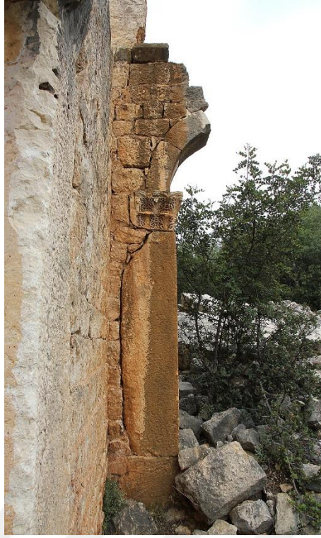
Şekil D. 17. Çatiören Kilisesi'nin naosunun batı duvarı üzerinde korunan, kuzey nef için ait plaster ve kemer taşları, 2016 (e.t.: 11.03.19, e.a.: https://commons.wikimedia.org/wiki/Category:%C3%87at%C4%B1%C3%B6ren#/media/File:%C3%87at%C4%B1%C3%B6ren06.jpg ).
