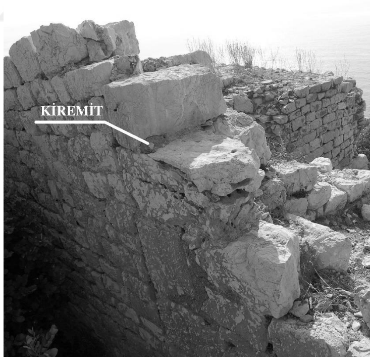
Şekil C. 32. Ek-A'nın duvar kesiti içerisinde dolgu malzemesi olarak harç yanında kiremit kullanıldığı görülmektedir, 2010 (©BOGA Arşivi).
