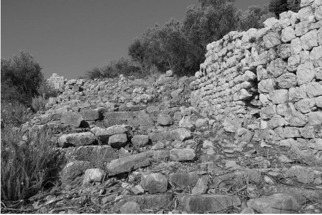
Şekil C. 4. Yapı grubunun güneyindeki basamaklı cadde, 2013 (©BOGA Arşivi).
