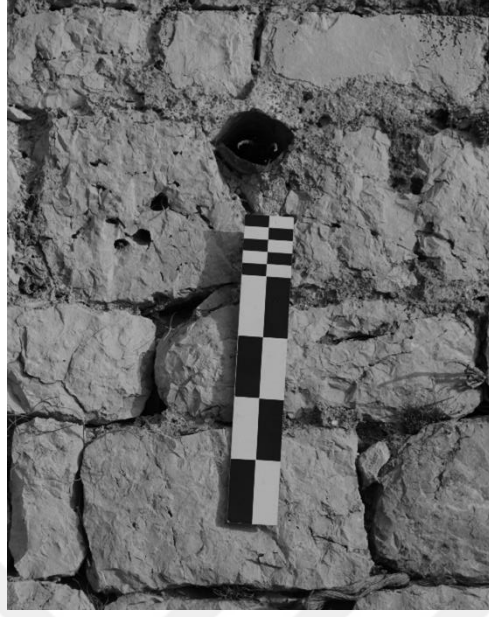
Şekil C. 76. Güney cephesi üzerindeki künk, 2017 (©BOGA Arşivi).
