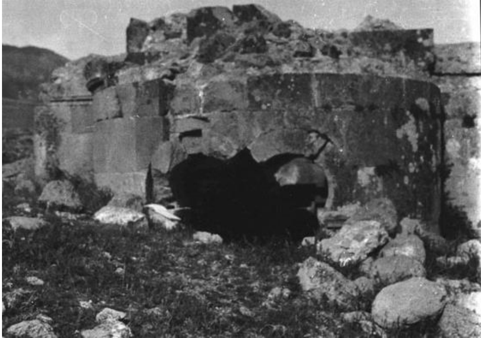
Şekil D. 42. Binbirkilise 12 numaralı yapının apsis cephesi (Bell, 1907, NUGBA Albüm H).
