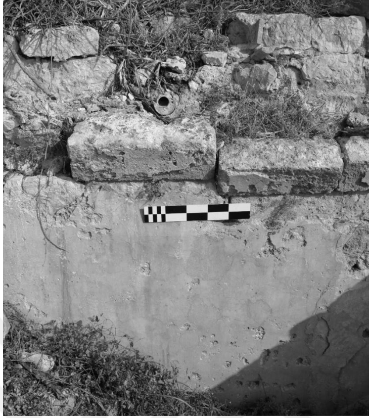
Şekil C. 29. Güney Sarnıç'ın tonozuna ait bloklar ve üstündeki künk, 2017 (©BOGA Arşivi).
