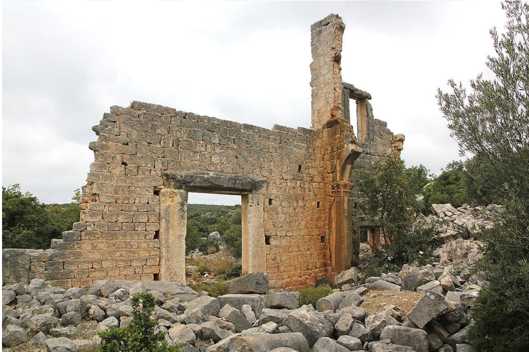
Şekil D. 18. Çatiören Kilisesi'nin naosunun batı duvarı, 2016 (e.t.: 11.03.19, e.a.: https://commons.wikimedia.org/wiki/Category:%C3%87at%C4%B1%C3%B6ren#/media/File:%C3%87at%C4%B1%C3%B6ren07.jpg ).
