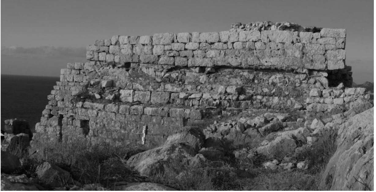
Şekil C. 68. Yapının doğu cephesi, 2017 (©BOGA Arşivi).
