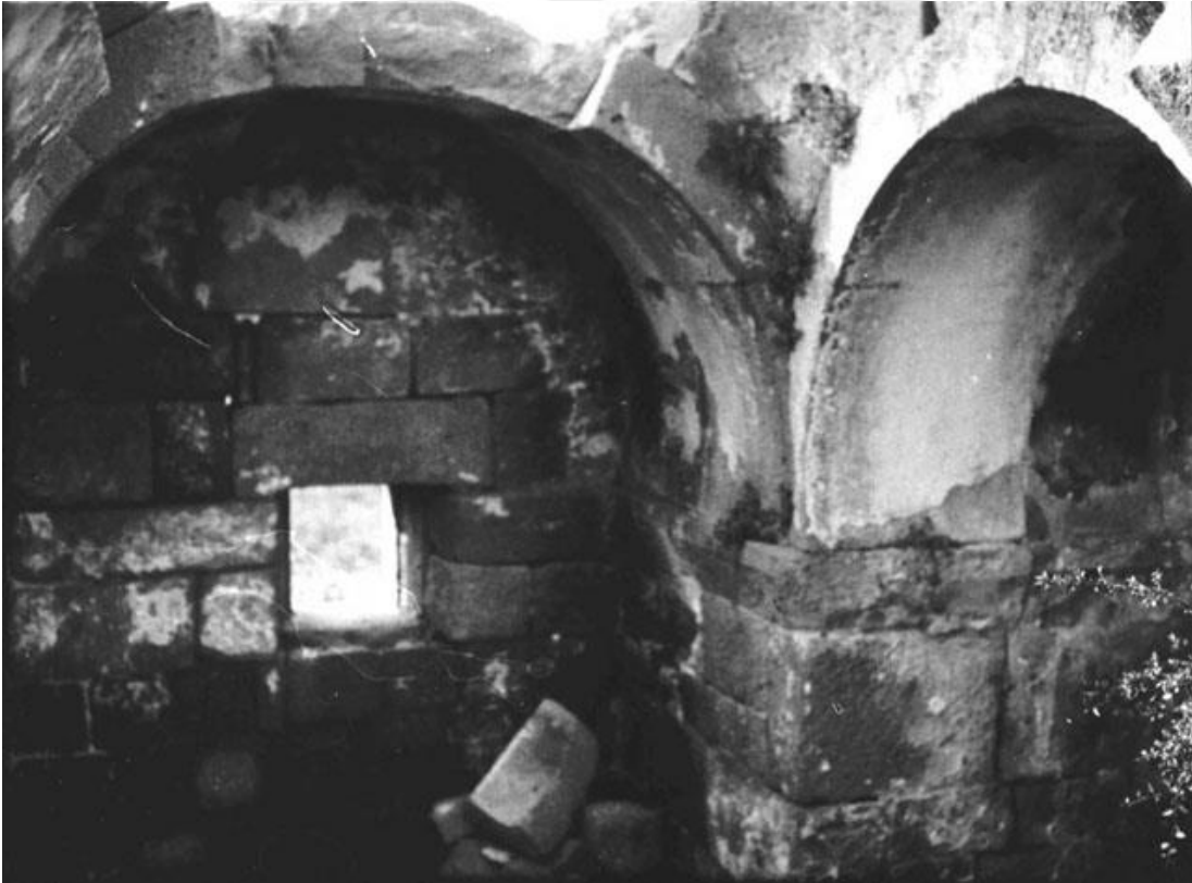
Şekil D. 40. Binbirkilise 12 numaralı yapının iç mekânı (Bell, 1907, NUGBA Albüm H).
