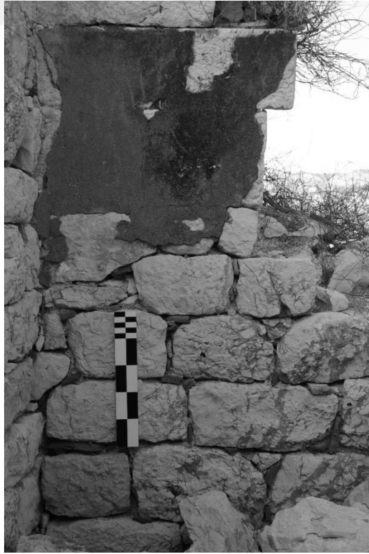
Şekil C. 75. Yapının batı duvarı üzerinde iyi korunmuş hidrolik sıva kalıntısı, 2017(©BOGA Arşivi).
