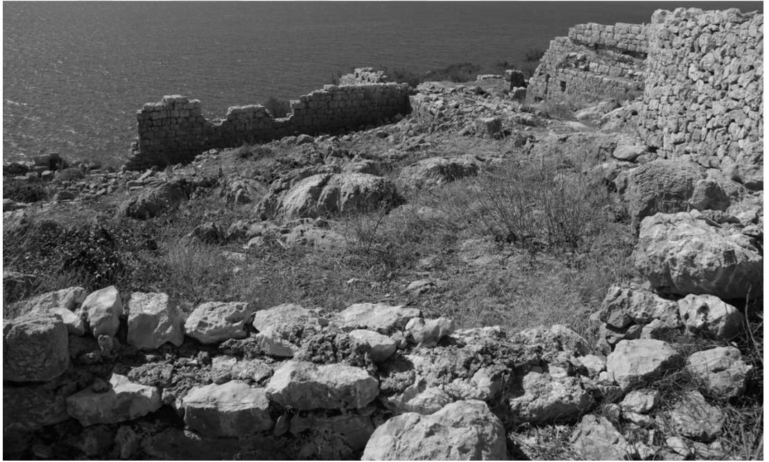
Şekil C. 79. Duvarın kavisinin kuzeydoğu köşesinden duvar ile Kilise 1'in arasında kalan kuzey avlusunun görünüşü, 2017 (©BOGA Arşivi).
