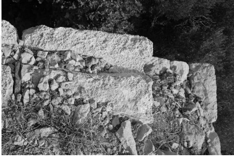
Şekil C. 83. Kilise 5'in çatısının kuzeyindeki su kanalı, 2013 (©BOGA Arşivi).
