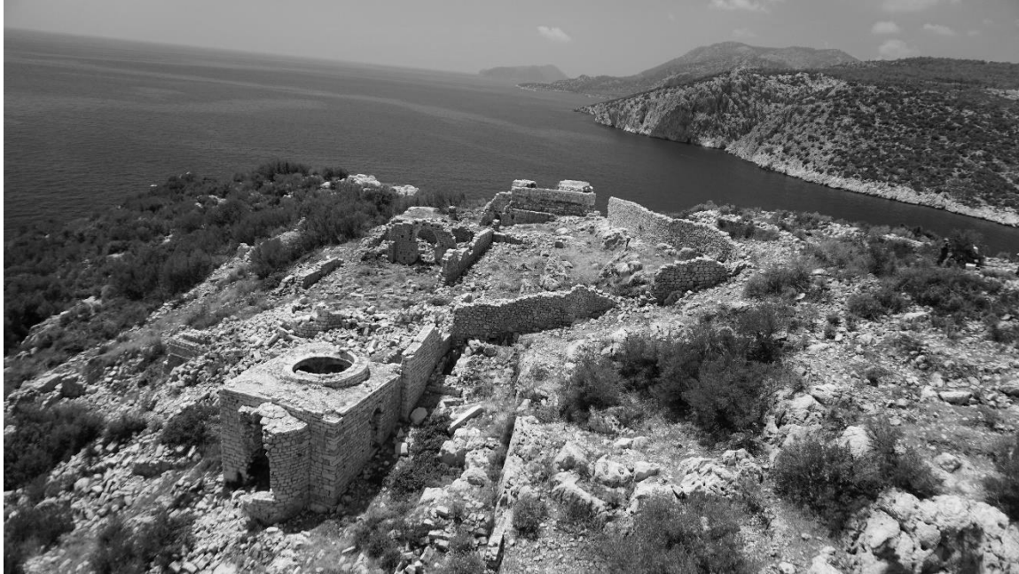
Şekil C. 2. Yapı grubuna doğudan bakış, 2017 hava fotoğrafı (Fotoğraf: Medet Elmalı, ©BOGA Arşivi).
