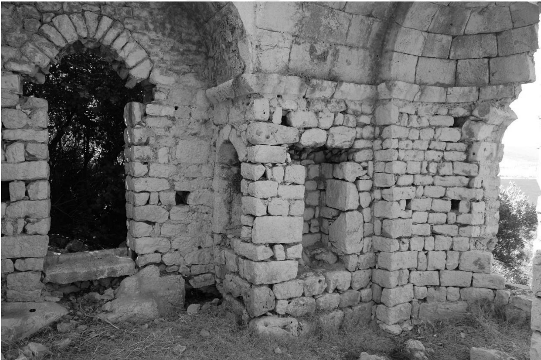
Şekil C. 56. Naosun kuzeydoğu köşesindeki paye (Solda kuzey haç kolunun doğu duvarı üzerindeki kemerli niş; sağda doğu haç kolunun kuzey duvarı üzerindeki düz atkılı niş), 2010 (©BOGA Arşivi).
