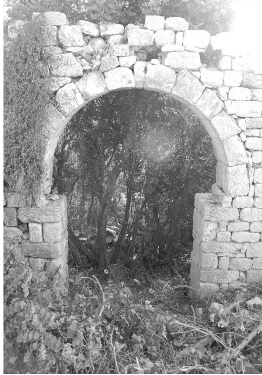
Şekil C. 9. Ana nef geçişi sağlayan kapının narteksten görünüşü, 2010 (©BOGA Arşivi).
