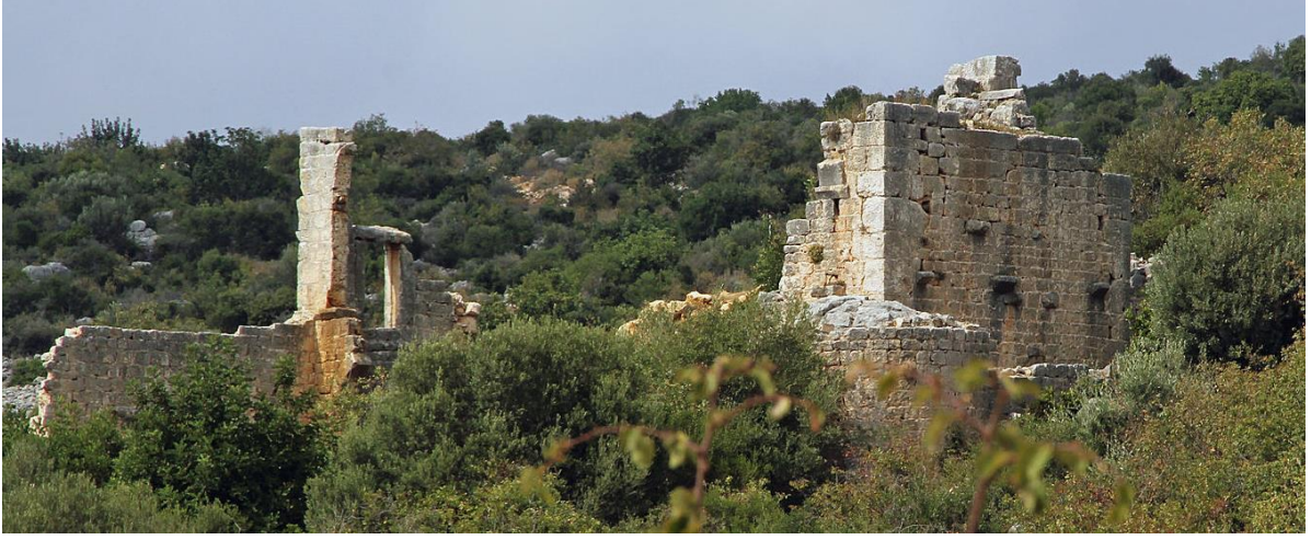
Şekil D. 19. Çatiören Kilisesi doğu mekânlarının batı duvarı üzerindeki konsollar, 2013 (e.t.: 11.03.19, e.a.: https://commons.wikimedia.org/wiki/Category:%C3%87at%C4%B1%C3%B6ren#/media/File:Cati%C3%B6ren9.jpg ).
