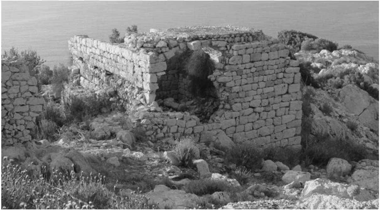
Şekil C. 70. Yapının kuzey cephesi ve doğusunda (solda) kavisli çevre duvarı, 2013 (©BOGA Arşivi).
