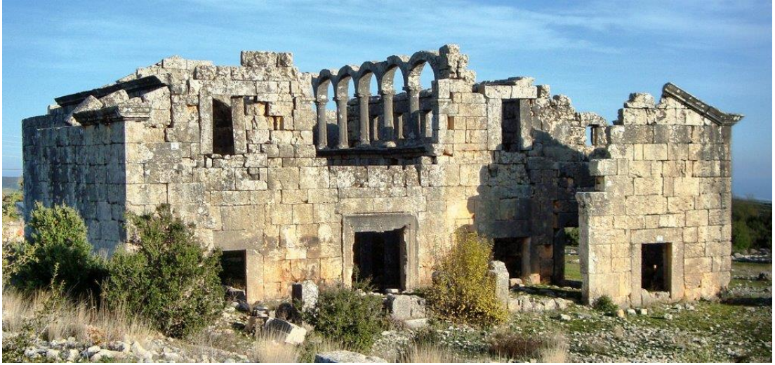
Şekil D. 30. Canbazlı Kilisesi batı cephesi (E.t.: 11.03.19, e.a.: https://mapio.net/pic/p-17367839/ ).
