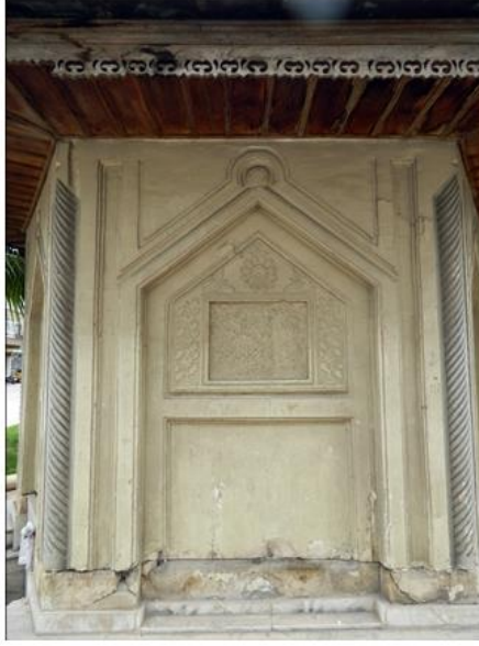
Şekil 2.88. Hüseyin Bey Çeşmesi B Cephesi (Özge Tokur, 2019)
