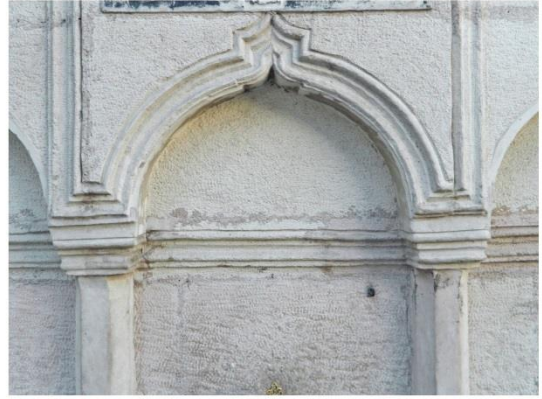
Şekil 2.33. Kuzey cephedeki niş (Özge Tokur, 2018)
