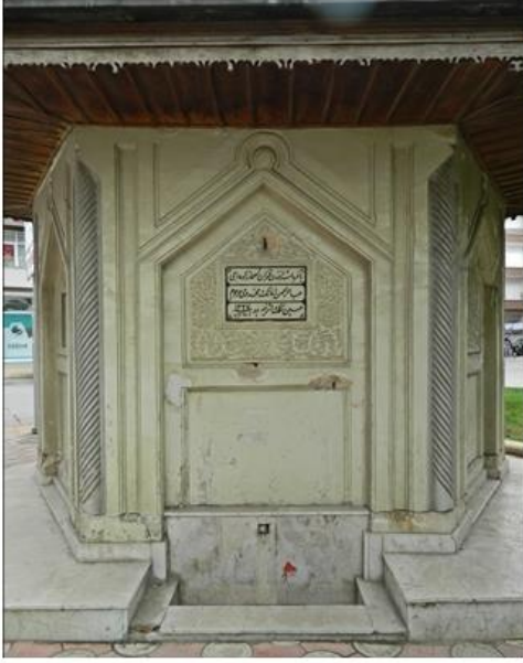
Şekil 2.85. Hüseyin Bey Çeşmesi A cephesi (Özge Tokur,2019)
