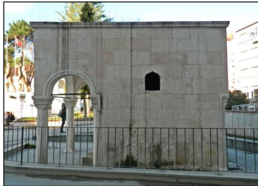
Şekil 2.29. Çeşmenin Doğu cephesi (Özge Tokur, 2019)
