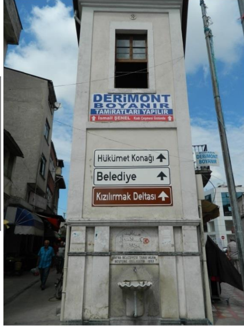
Şekil 2.41. Kadı Çeşmesi ve üzerinde yer alan yapı (Özge Tokur, 2018)
