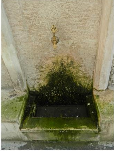
Şekil 2.144. Ali Bey Çeşmesi'nde oluşan yosunlanma (Özge Tokur, 2019)
