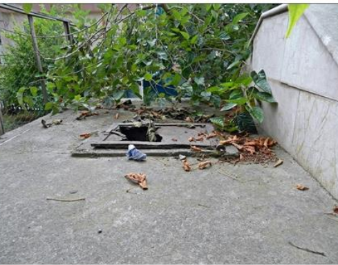
Şekil 2.141. Çeşmenin su deposu (Özge Tokur, 2018)
