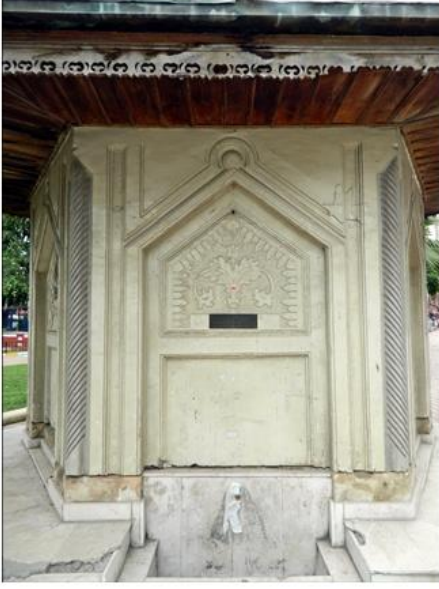
Şekil 2.91. Hüseyin Bey Çeşmesi C Cephesi (Özge Tokur, 2019)
