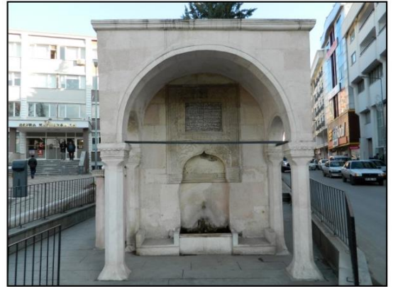
Şekil 2.7. Ali Bey Çeşmesi Güney Cephesi (Özge Tokur, 2019)
