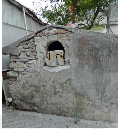
Şekil 2.67. Taşlı Çeşme'nin arka cephesi (Özge Tokur, 2019)
