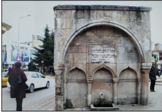
Şekil 2.26. Ali Bey Çeşmesi Kuzey cephesi (S.K.V.K.B.K., f.ç.tarihi: 12.02.1999)
