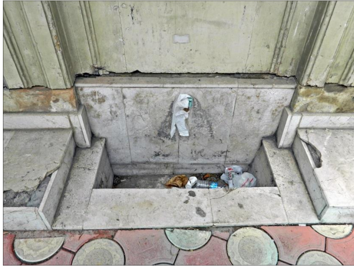
Şekil 2.93. Hüseyin Bey Çeşmesi C cephesi kurnası (Özge Tokur, 2019)
