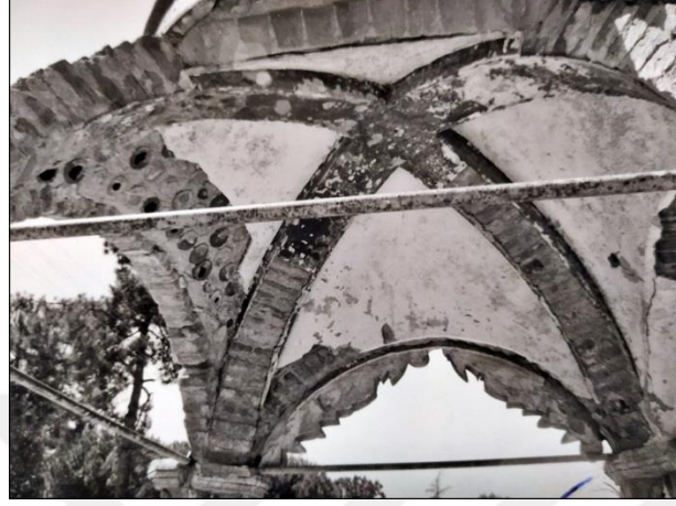
Şekil 2.120. Taçlı Çeşme'nin kubbesine içten görünüşü (S.K.V.K.B.K. f.ç.tarihi: 2001)
