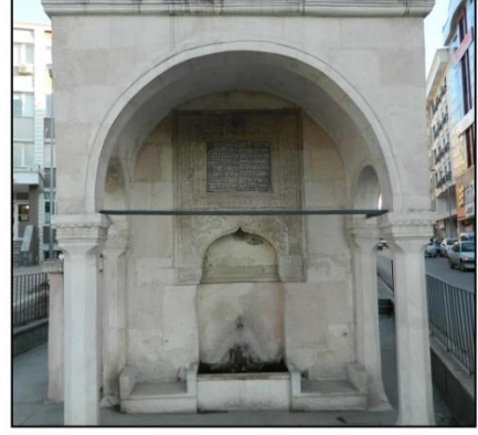
Şekil 2.31. Çeşmenin Güney cephesi (Özge Tokur, 2019)
