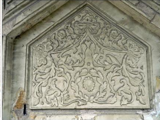
Şekil 2.100. F Cephesi bezeme detayı (Özge Tokur 2019)
