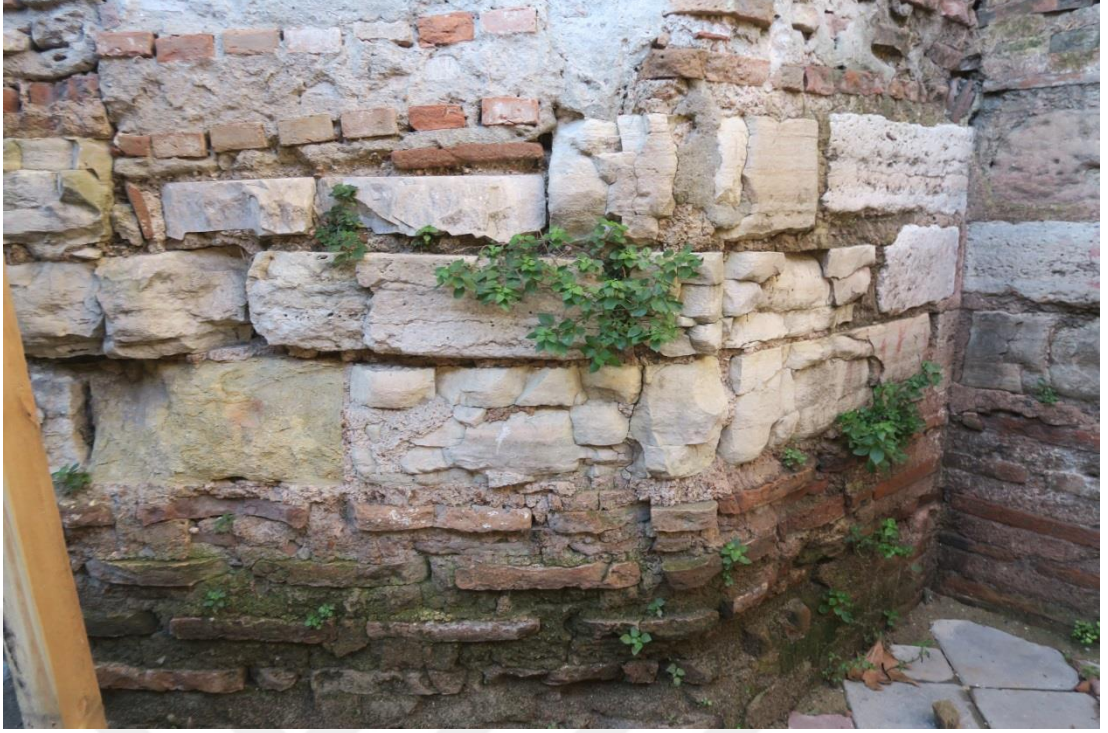
Şekil 2.9: Güney cepheye yakın köşedeki duvar örgüsü
