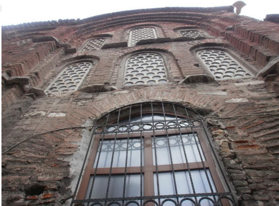
Şekil 2.13: Güney cephe pvc doğrama ve demir parmaklıklar (Birer, 2014)
