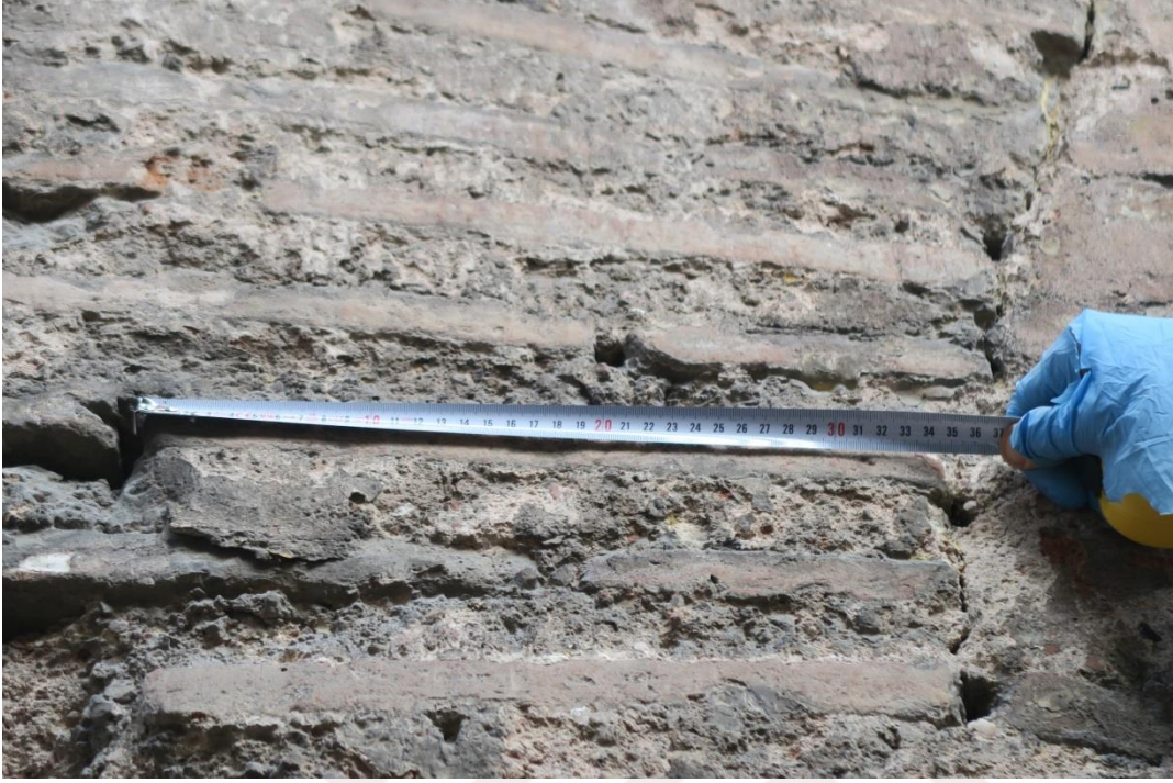
Şekil 2.11: Tuğla malzemedeki yapılan boyut ölçümü
