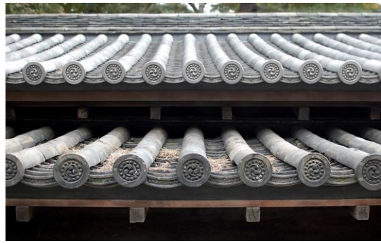
Resim 4.28 Kiremit örtülü çatı (URL-35)
