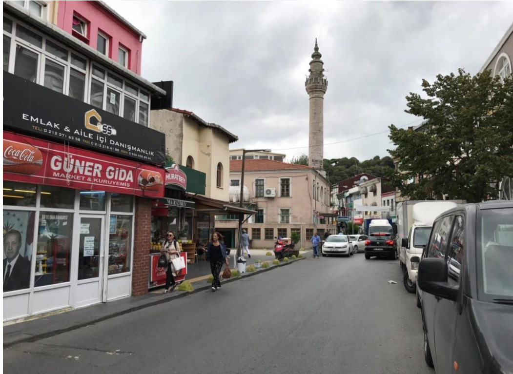
Resim 7- 3.2.2. Cadde aksından camiye ulaşmamız esnasında elektrik kabloları ile beraber klimanın dış tarafa monte edilen düzenliğini görmekteyiz.
