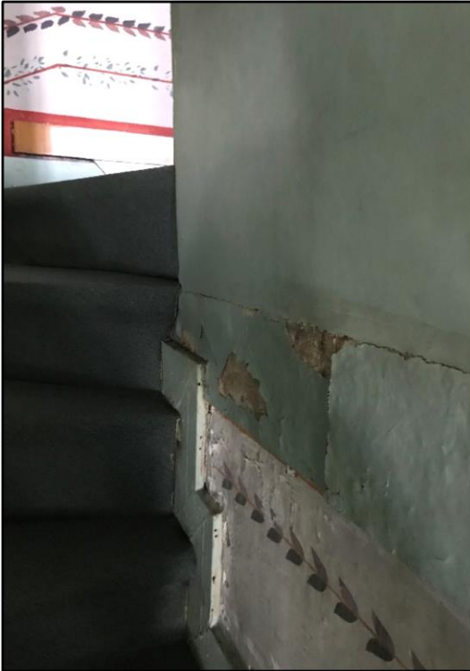
Resim 61- 3.6.2. Caminin Çeşitli Bölümlerinde ki Doğal ve Kullanıma Bağlı Eskimler.
