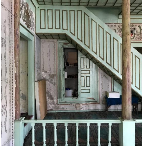
Resim 57- 3.6.2. Caminin Rutubetli bölümleri.
