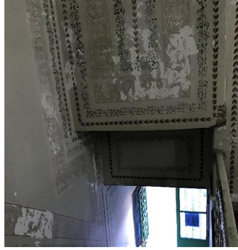
Resim 57- 3.6.2. Caminin Rutubetli bölümleri.
