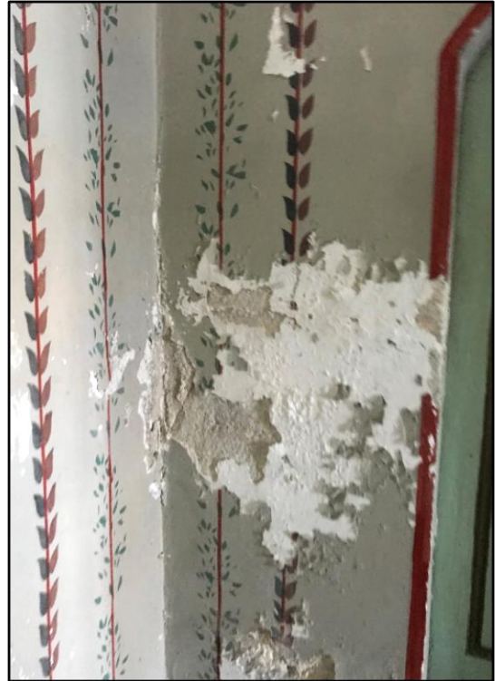
Resim 61- 3.6.2. Caminin Çeşitli Bölümlerinde ki Doğal ve Kullanıma Bağlı Eskimler.
