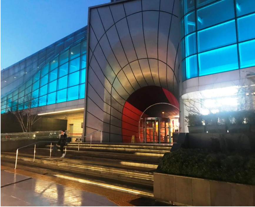
Resim 3.16 : Akmerkez AVM girişi hissedilebilir yüzey uygulaması (Tuba Terece arşivinden, 2019).
