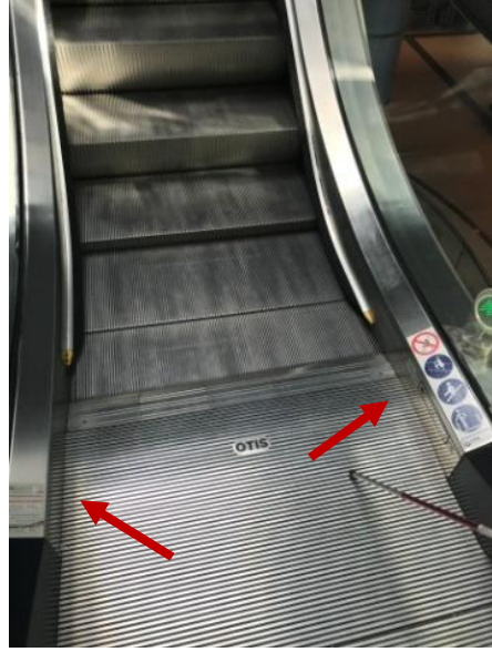
Resim 5.67 : A AVM, yürüyen merdivenleri (Tuba Terece arşivinden, 2018).
