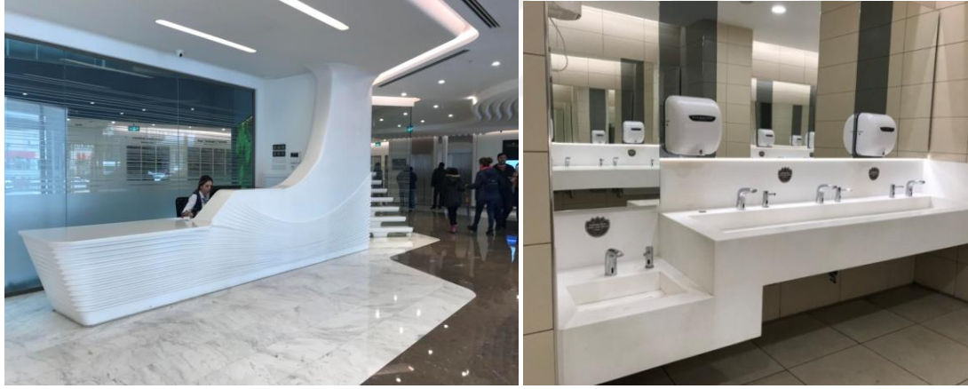
Resim 3.11 : Farklı yüksekliğe sahip danışma bankosu (Medicana Hastanesi Kadıköy) ve bir AVM'de bulunan ayrı çocuk lavabosu örneği (Forum İstanbul AVM, Tuba Terece arşivinden, 2017-2018).
