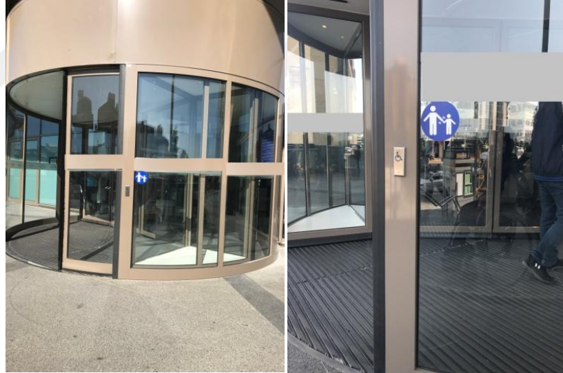
Resim 5.8 : AVM giriş-çıkış kapısında yer alan yardım butonu ve zemin döşemesi (Tuba Terece arşivinden, 2018).
