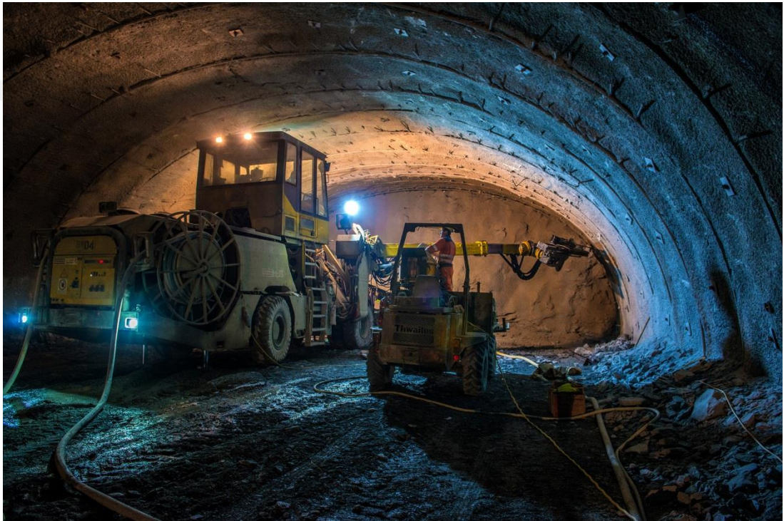
Şekil 17: Yeni Avusturya Tünel Açma Yöntemi (NATM) ile Tünel İnşası (Url-9).
