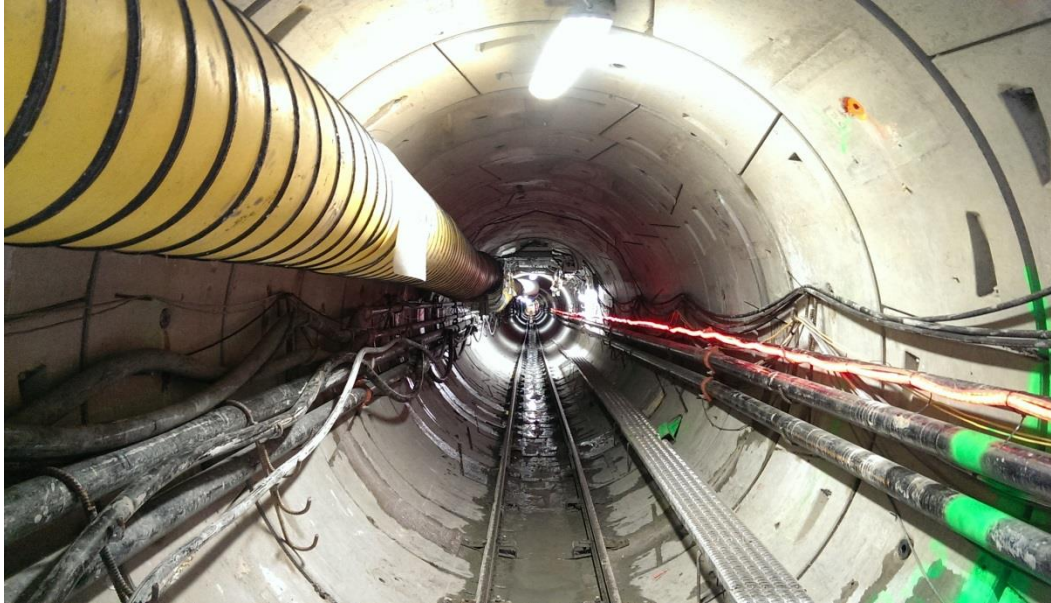
Şekil 19: Tünel Açma Makinesi (TBM) ile Tünel İnşası (Url-11).
