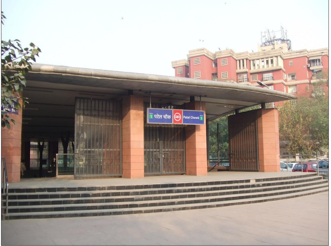
Şekil 40: Patel Chowk İstasyonu Giriş Yapısı (Url-26).
