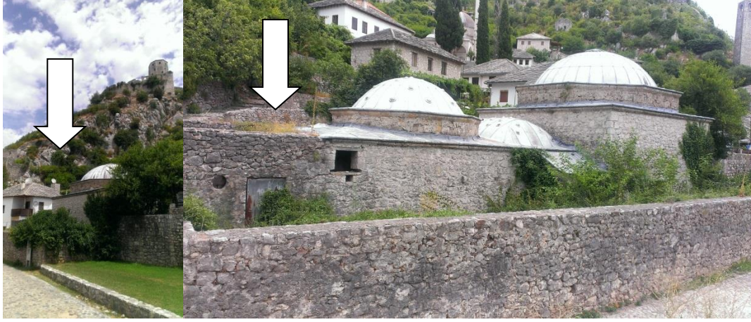
Şekil 3.2.33: Ibrahim Ćehaja Hamamı: soyunma mekânının kubbesi tüm kompozisyonu tamamlanmamış gösteren eksik parçadır (2018 tarihli fotoğraf).
