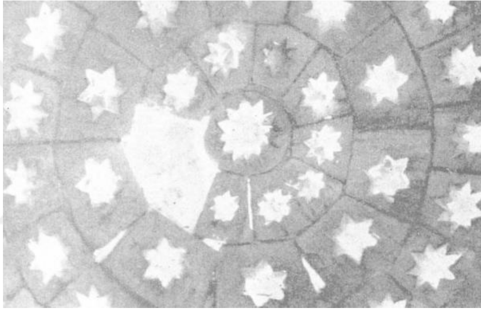
Şekil 3.2.21: Blagaj Tekkesi delikli kubbenin 1952 tarihinde restorasyondan önce çekilmiş görüntüsü (Ayverdi vd. 1981, s.84).
