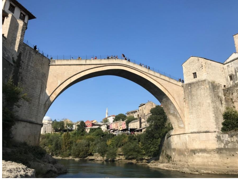
Şekil 2.1.10: Mostar'daki Yeniden İnşa Edilmiş Eski Köprü (yazar tarafından 2018).
