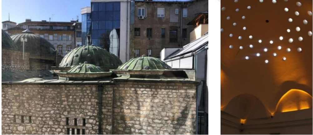
Şekil 2.3.15: Sırasıyla solda Boşnak Enstitüsü'nün çatısının cephe görüntüsü ve kubbe fanusu Gazi Hüsrev Bey Hamamı. Sağda: Bursa'daki Ördekli Hamamı Kültür Merkezi 'nin içinden kubbe aydınlatmasının görünümü ( yazar 2017, 2018 ).
