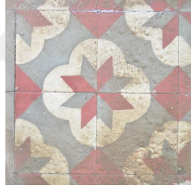
Şekil 2.51: Z02 hol zemin kaplaması. (T. Özderya Arşivi, 2019)
