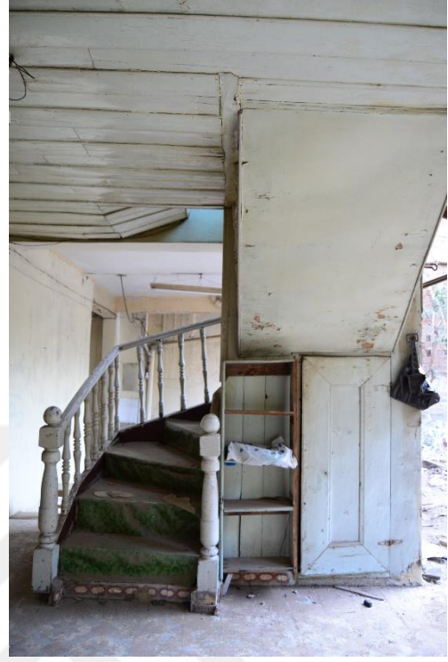
Şekil 2.45: Merdiven altı kapatılarak dolap . (T. Özderya Arşivi, 2019)
