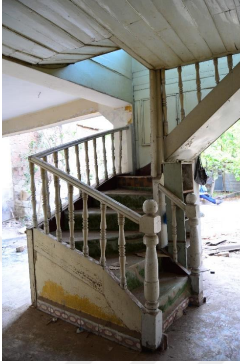
Şekil 2.44: Basamakları pvc kaplanmış merdiven. (T. Özderya Arşivi, 2019)
