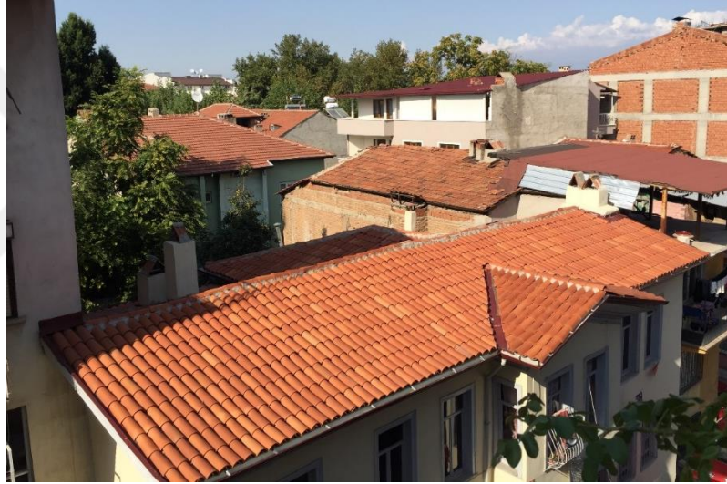
Şekil 2.54: Enver Soylu Evi çatı görünüşü. ( T. Özderya Arşivi, 2019)
