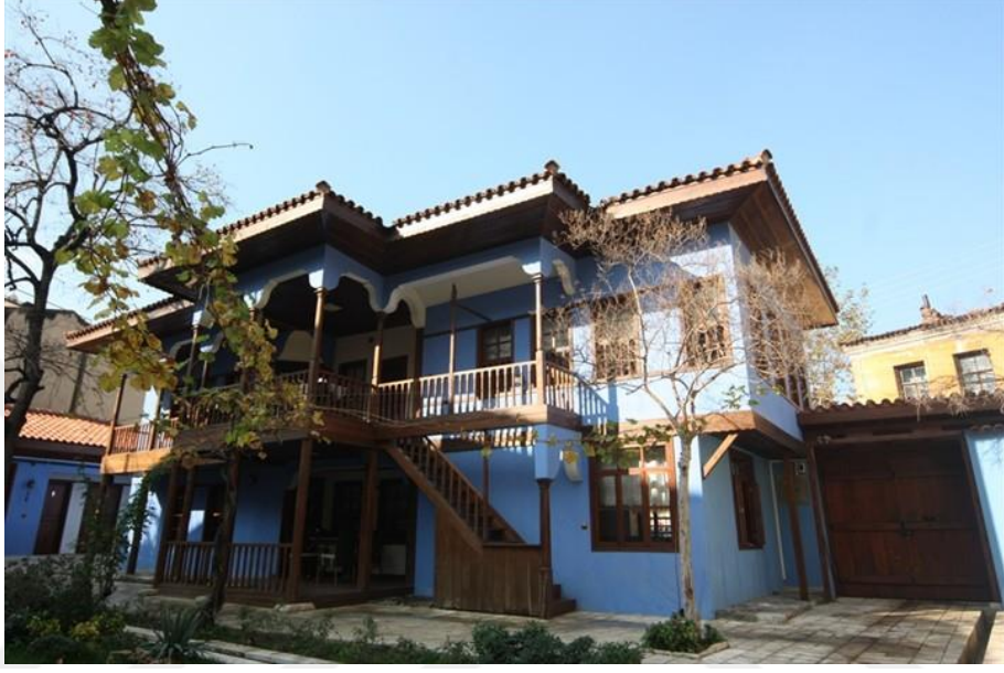
Şekil 1.7: Konyalıoğlu Evi bahçeden görünüşü. (URL-4)
