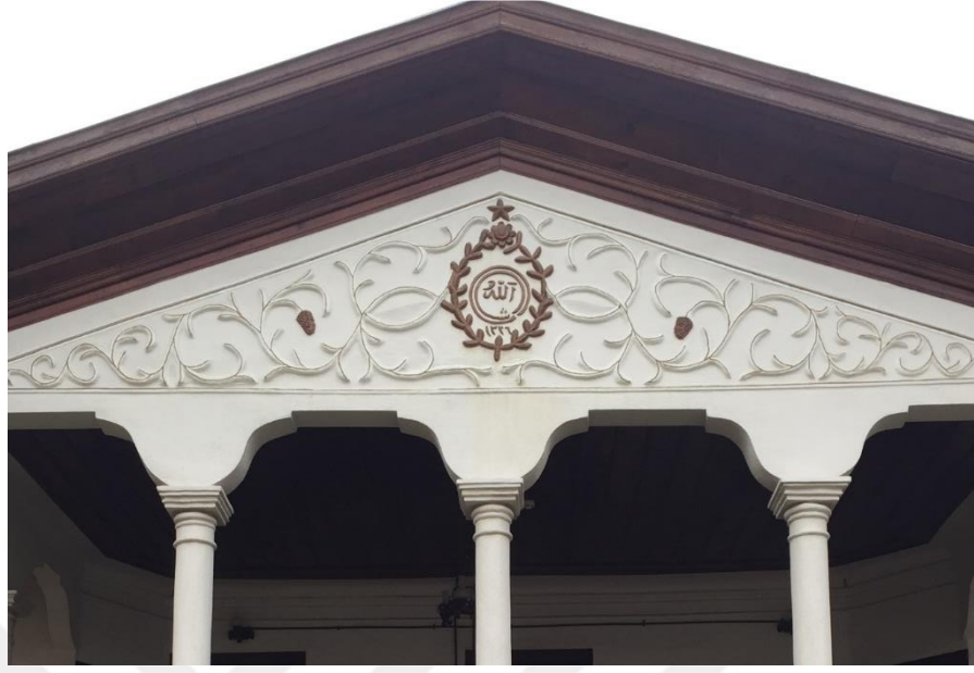
Şekil 1.12: Cephe saçak altında bulunan yapım tarihi ve maşallah yazısı (T. Özderya Arşivi, 2019).
