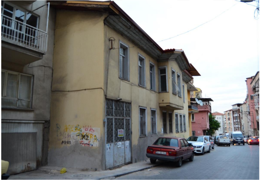
Şekil 2.39: Enver Soylu Evi kuzeybatı cephesi. (T. Özderya Arşivi, 2019)
