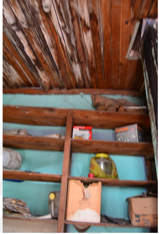
Şekil 2.31: Depo'nun tavan kaplaması. (T. Özderya Arşivi, 2019)
