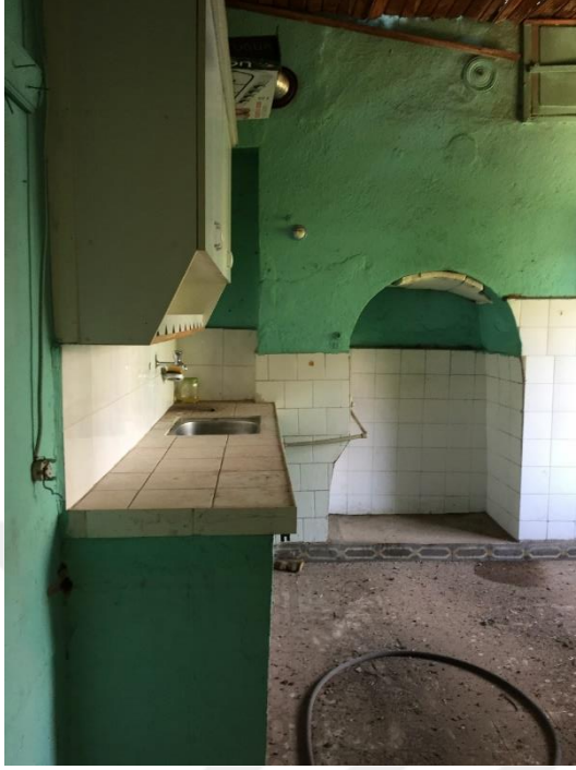
Şekil 2.28: Mutfağın güneybatı duvarı. Banyo genel görünüşü. (T. Özderya Arşivi, 2019)
