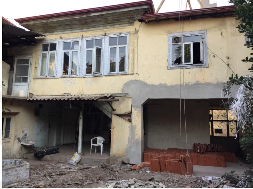
Şekil 2.40: Enver Soylu Evi güneydoğu cephesi. (T. Özderya Arşivi, 2019)
