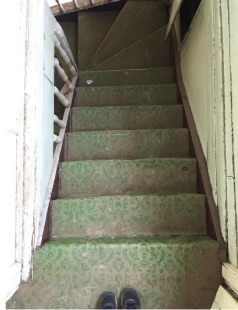
Şekil 2.47: Birinci kattan merdivenin görünüşü. (T. Özderya Arşivi, 2019)
