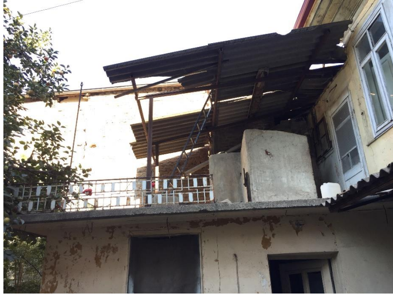
Şekil 2.41: Enver Soylu Evi Güneydoğu cephesi. (T. Özderya Arşivi, 2019)
