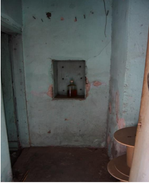
Şekil 2.11: Ahşap duvar nişi (T. Özderya Arşivi, 2019).
