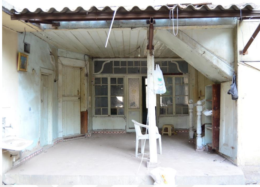
Şekil 2.6: Z02 hol bahçeden görünüşü (T. Özderya Arşivi, 2019).
