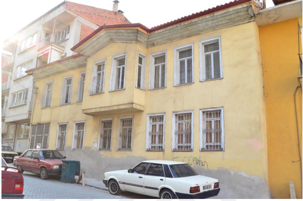
Şekil 2.38: Enver Soylu Evi kuzeybatı cephesi. (T. Özderya Arşivi, 2019)
