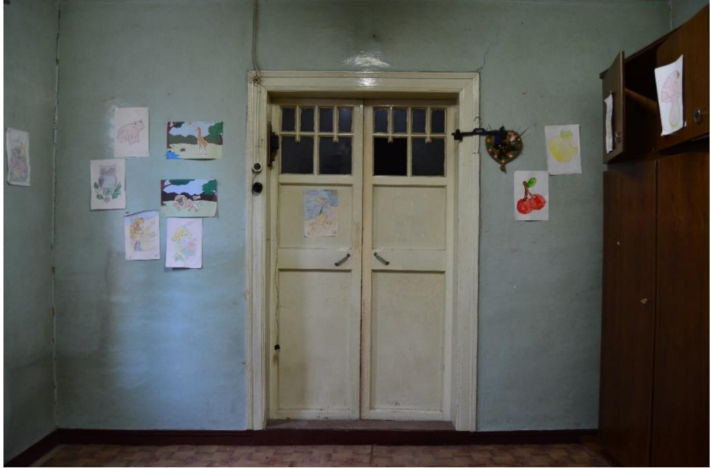
Şekil 2.37: Odanın güneybatı duvarında bulunan ahşap kapı. (T. Özderya Arşivi, 2019)
