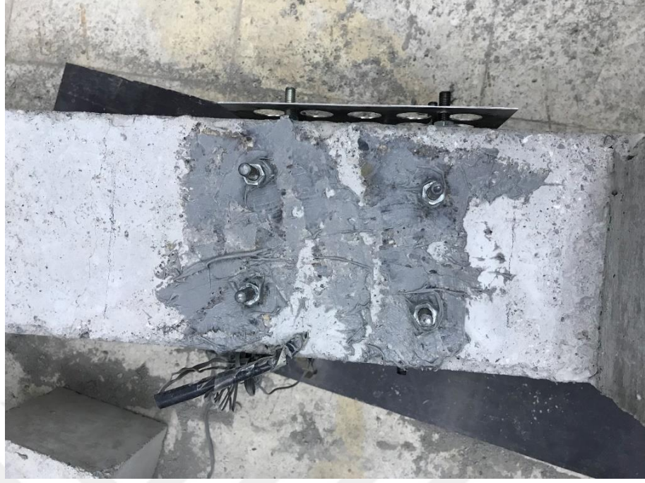
Şekil 3. 29. Ankrāj deliklerine 8 mm'lik tijlerin epoksi ile sabitlenmesi
