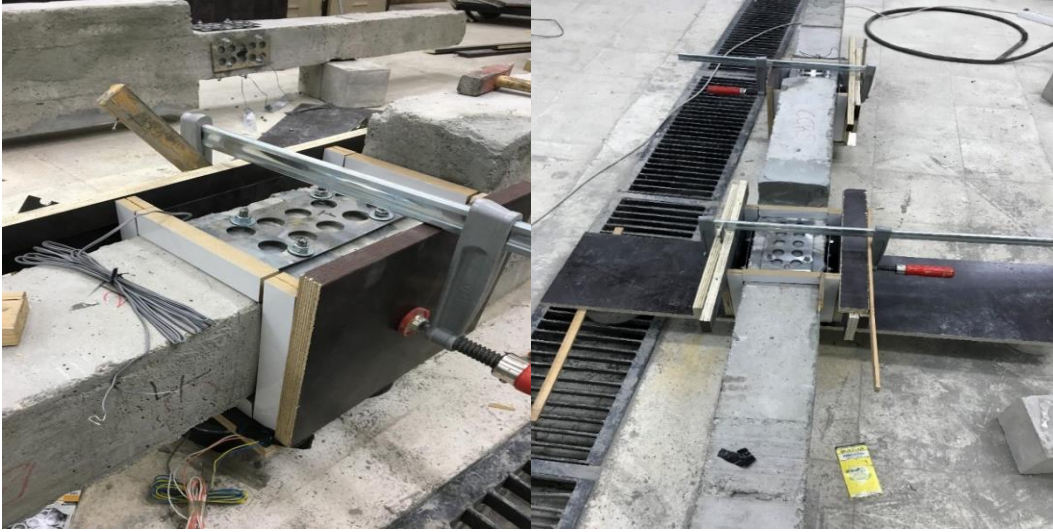
Şekil 3. 31. Kesme açıklığı bölgesinde güçlendirme uygulamasını gerçekleştirmek amacıyla yapısal tamir harcı için kalıp hazırlanması
