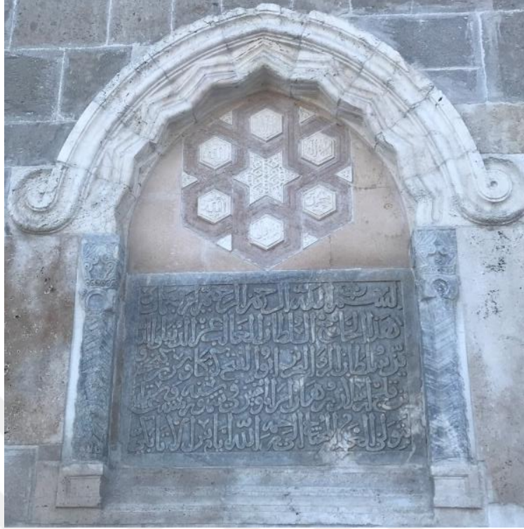
Fotoğraf 2.8: Alaeddin Camii avlu duvarı kemer aynasındaki kitabe(Esma Arıtan, 2019)
