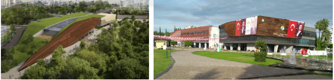
Resim 4.10 Çukurova Hizmet Binası ve Kültür Merkezi kabuk tasarımı (URL-18) ve uygulanmış bina (yazar tarafından)
