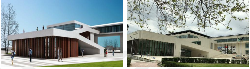
Resim 4.6 Kadiri Belediyesi Hizmet Binası ve Kültür Merkezi tasarımı(URL-11) ve uygulanmış bina (yazar tarafından)
