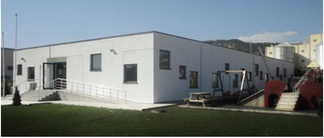
Resim 4.14 Borusan Neşe Fabrikası uygulanmış bina (URL-29)
