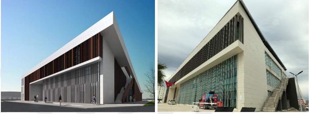
Resim 4.5 Kadirli Belediyesi Hizmet Binası ve Kültür Merkezi tasarımı(URL-11) ve uygulanmış bina (yazar tarafından)
