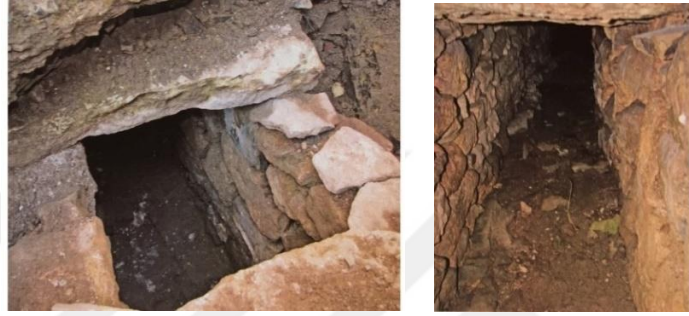
Görsel 325 Caminin güneydoğusunda ortaya çıkartılan altyapı ya da havalandırma kanalının üstten ve içten görünüşü.
