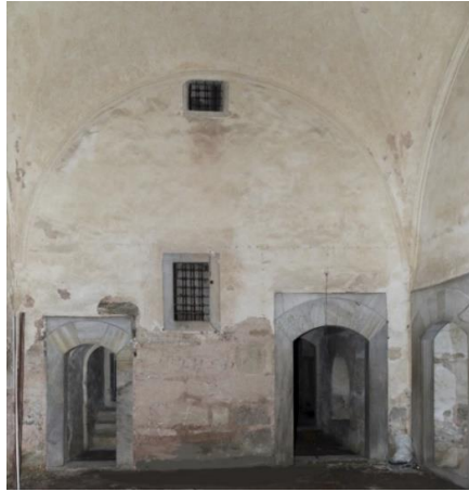
Görsel 240 Aşağı Hünkâr Sofası ile Hünkâr Yatak Odasına geçiş sağlayan kapılar. 335
