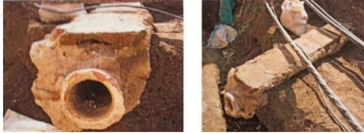
Görsel 326 Caminin güneybatı köşesinden çıkartılmış su künkü.
