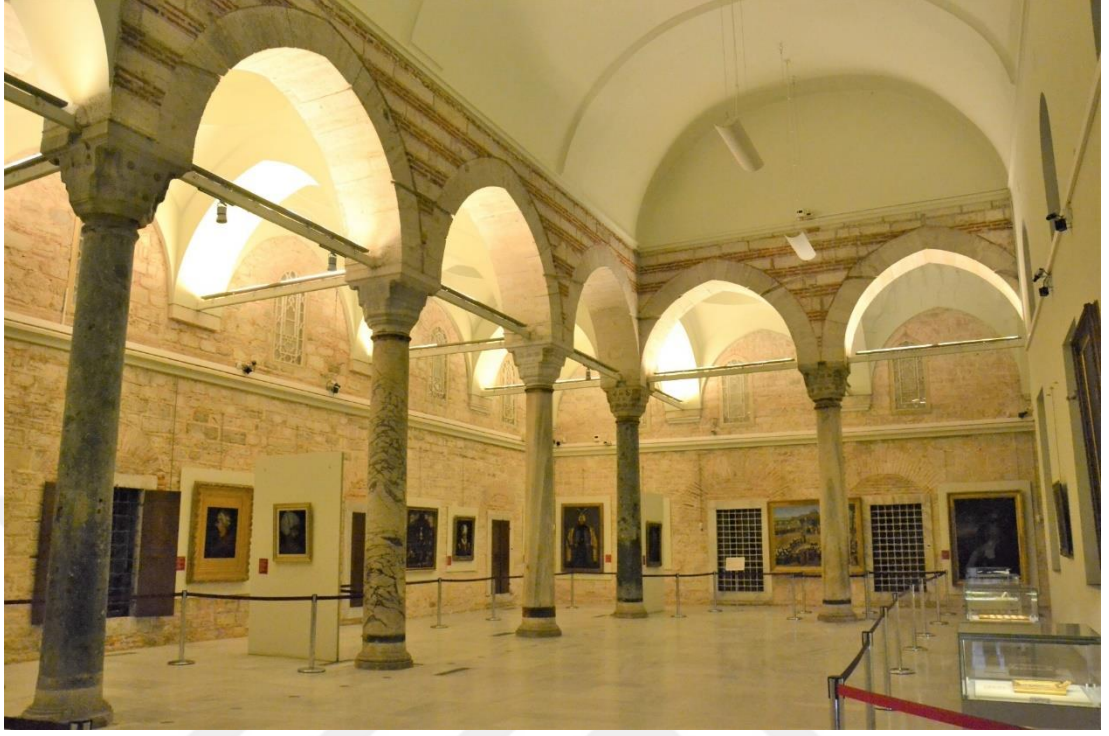
Görsel 304 Eski Has Oda Koğuşu'nun revakları ve sonradan örtülen tonoz kubbe, (Yaman, 2019)
