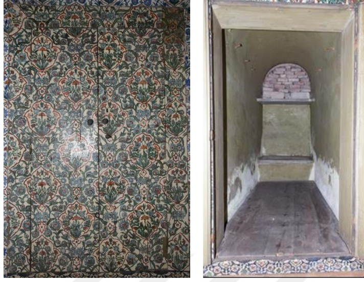
Görsel 243 Taht Odasından alt kata inen diğer kapatılmış merdivenin gizlendiği dolabın kapalı ve açık hali. 339
