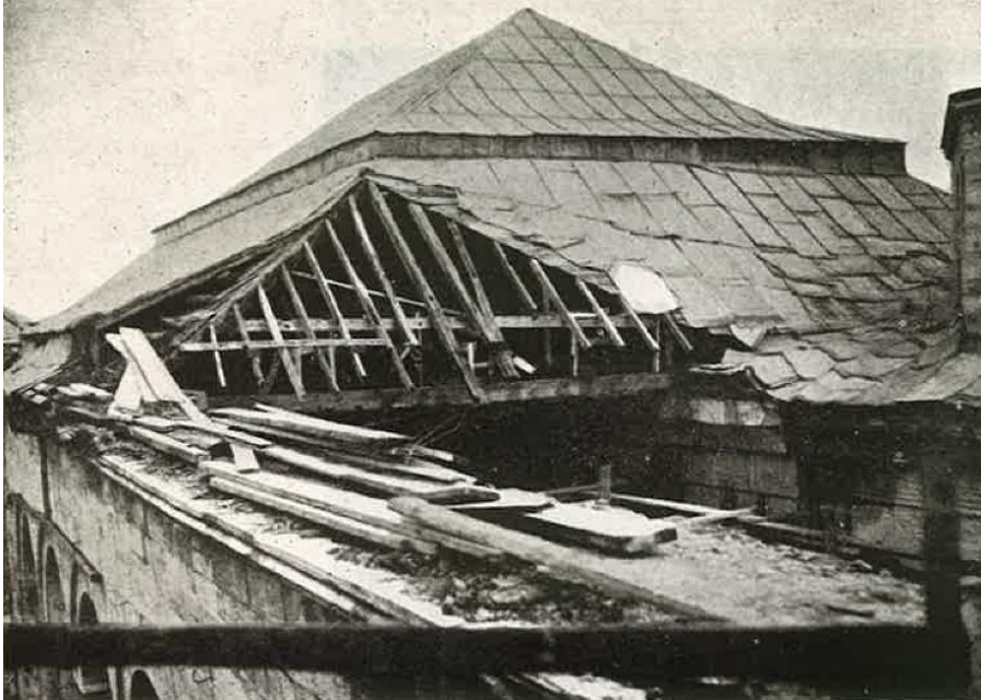
Görsel 197 Onarım sırasında Fatih Köşkü'nün ahşap çatısı, 1942, Tahsin Öz.
