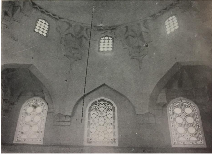
Görsel 195 Onarım sonrasında Fatih köşkü salonu, 1942, Tahsin Öz.
