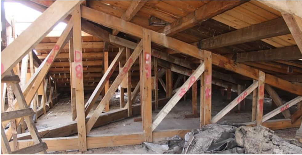
Görsel 204 Fatih Köşkü'nün restorasyon sırasında çatısının sökümü, 2019. 269
