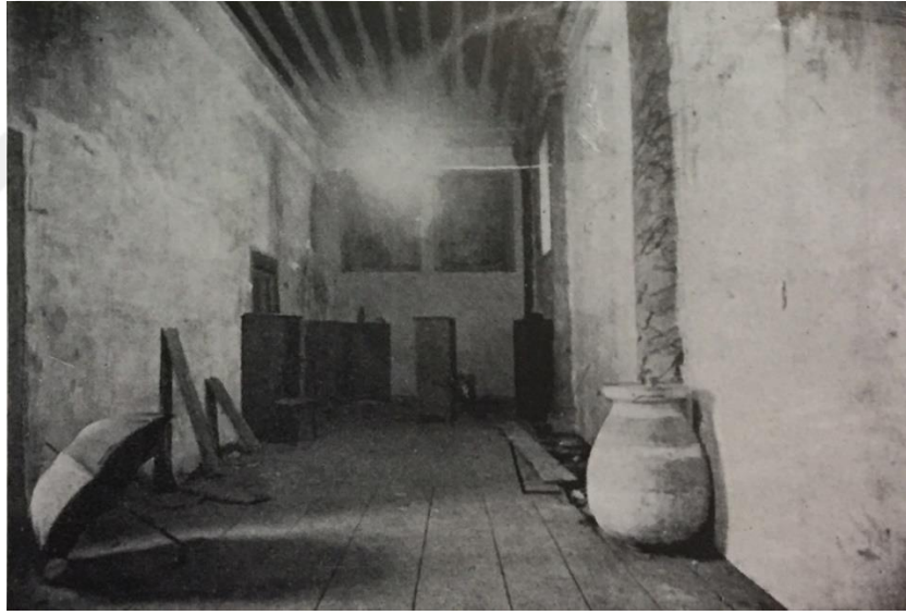
Görsel 302 Onarım öncesinde Has Oda Koğuşu'nda duvarla örülmüş sütunların bulunduğu koridor, 1940'lar, Tahsin Öz.
