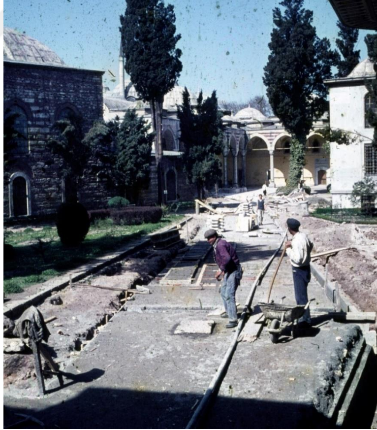
Görsel 373 1960'larda Üçüncü Avlu'da zemin onarımı, Söylemezoğlu, Salt Araştırma.
