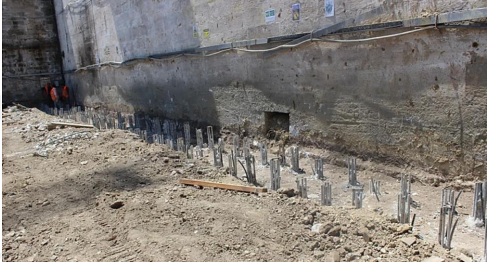
Görsel 203 Fatih Köşkü'nün Marmara cephesinin duvar dibine çift sıra mini kazık uygulaması, 2019. 268
