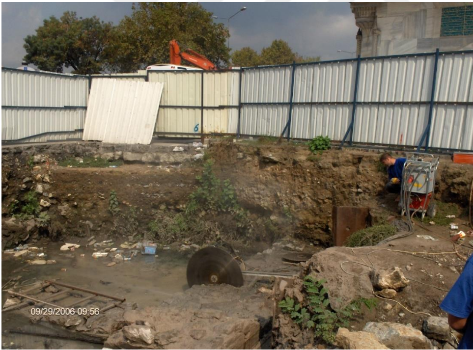
Resim 3. 7- Marmaray Üsküdar şantiyesi disk kesme makinası ile yapı kalıntısını keserek parçalara ayırma, (Somun İnşaat,2006)
