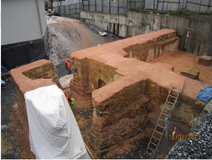
Resim 4. 31- Taşıma sonrası, kilise kalıntısı (Somun İnşaat, 2012)
