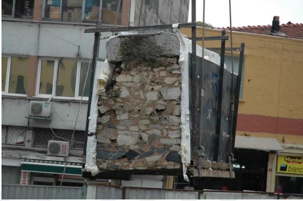
Resim 3. 3- Moloz duvar örgüsü, Kadıköy Söğütluçeşme otopark inşaatı (Somun İnşaat,2013)
