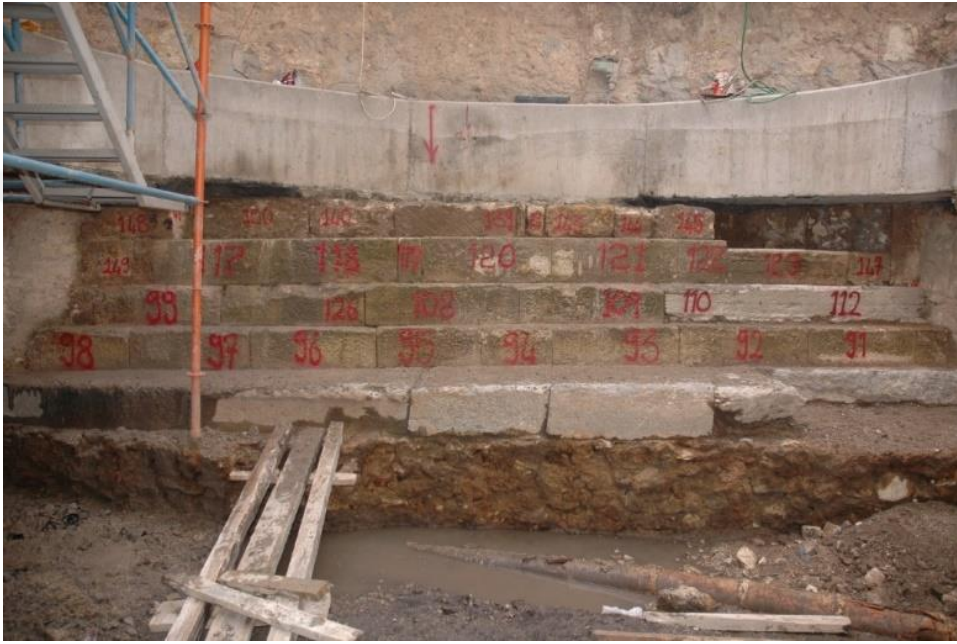
Resim 3. 17- Numaralandırılarak söküm yapılması, Marmaray projesi, Sirkeci istasyonu Roma dönemi duvar kalıntısı, (Somun İnşaat,2012)
