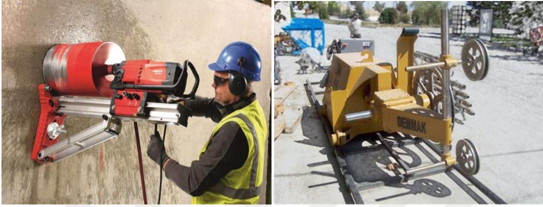
Resim 3. 5- Karot makinası uygulama aşaması Resim 3. 6- Telli (halatlı) kesme makinası
