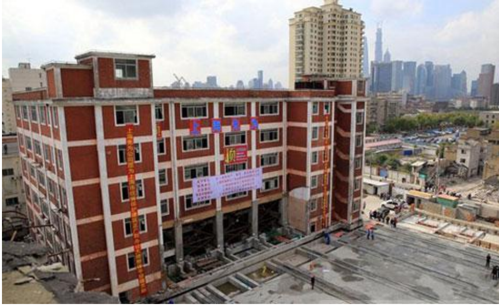
Resim 3. 32- Zhengguanghe Binası, beton raylarda taşınması, Şangay,2013, ( http://www.china.org.cn )
