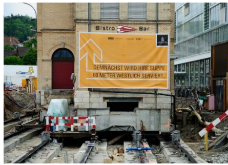
Resim 3. 9- Oerlikon Binasının çelik raylarda 63 mt kaydırılarak taşınması, Zürih,2014, ( http://www.muellertruniger.ch )
