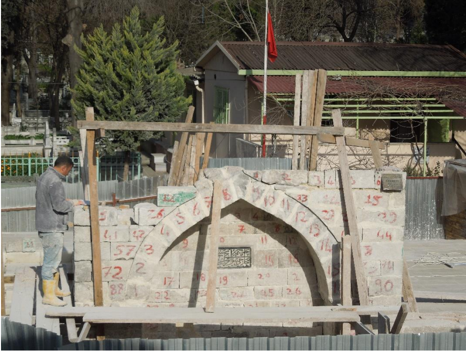
Resim 4. 28- Hacı Bayram Çeşmesi, dikey yönde taşıma sonrası yeniden kurulumu (Kendir, 2012)
