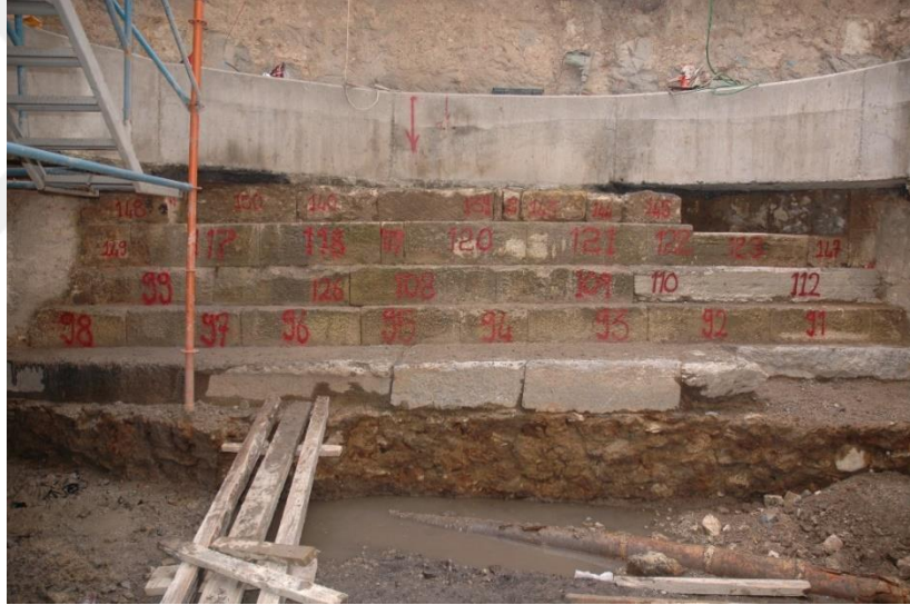
Resim 4. 33- Roma dönemine ait duvar blokları, taşıma öncesi, numaralandırma aşaması (Somun İnşaat, 2012)
