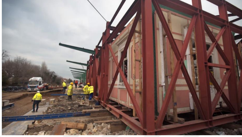
Resim 3. 11- Yeşilköy tren istasyonu taşıma, çelik kafes sistem uygulaması, İstanbul (Somun İnşaat, 2017)
