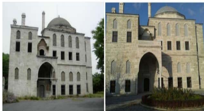
Şekil 3.10.Hünkâr Kasrı' nın 2010' yapılan restorasyon öncesi ve sonrası güney cephesi (Gül, 2015, sy. 11).
