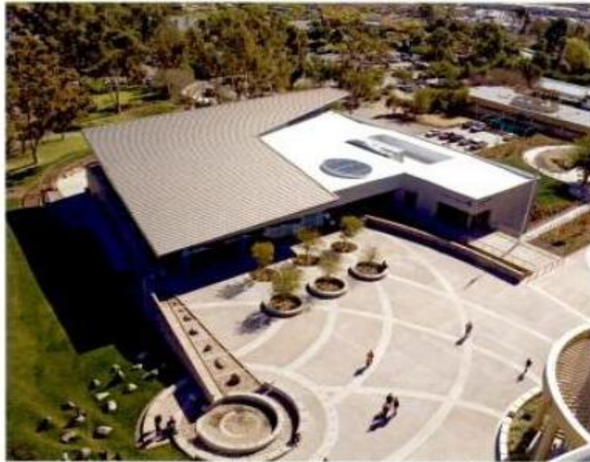
Şekil 11. Roy Lee Walker İlk Okulu: Yağmur Suyu Biriktirecek Biçimde Tasarlanan Çatı (Beaver, 2009: 21).
