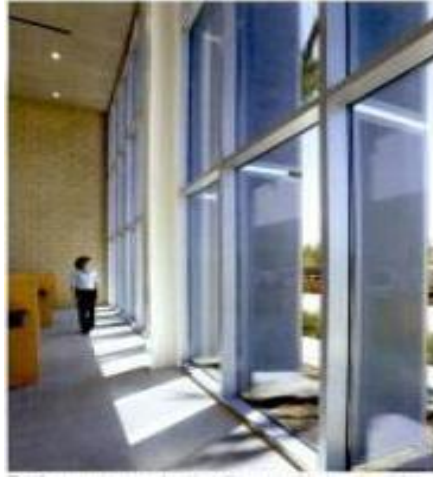
Şekil 3. Doğal Aydınlatmadan Üst Düzeyde Yararlanmayı Sağlayacak Büyük Camlar ve Olumsuz Etkilerini Azaltacak Dikey Işık Rafları (Beaver, 2009: 28).
