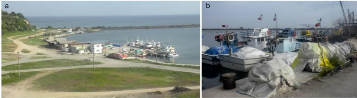
Foto 5.10 İğneada Limanı ve balıkçı barınağı.
