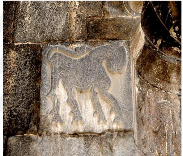
Resim 11, Dağkapı Dış Duvarı Sol.
