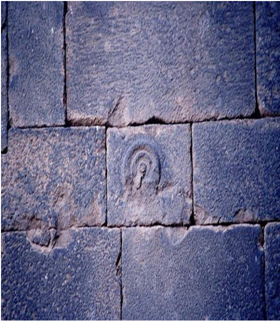
Resim 16, Dağkapı Burcu Dış Duvarından Bir Kesit.
