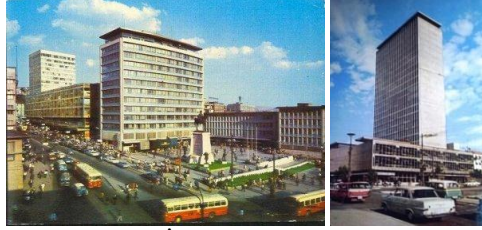
Şekil 2.42. Ulus İş Hanı, Bozkurt, Beken, Bolak, Ankara, 1954 (13 katlı) (solda) (URL-70) (solda) Kızılay İş Hanı, Enver Tokay, Ankara, 1967 (24 katlı)(sağda) (URL-71) (sağda)
