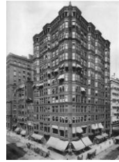
Şekil 2.11. Tacoma Binası, William Holabird ve Martin Roche, (URL-15) Yıl:1887-1889
