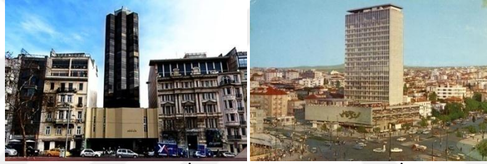
Şekil 2.43. Odakule İş Merkezi, Tecimel Taner, İstanbul, 1975 (21 Katlı) (URL-72) (solda) Emek İş Hanı Enver Tokay, İlhan Tayman, Ankara, 1965 (23 katlı) (URL-73) (Begeç 1999). (sağda)
