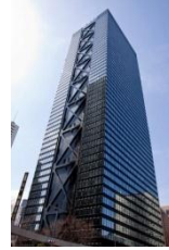
Şekil 2.27. Shinjuku Mitsui Binası, Nihon Sekkei, 1972-1974 (URL-38)
