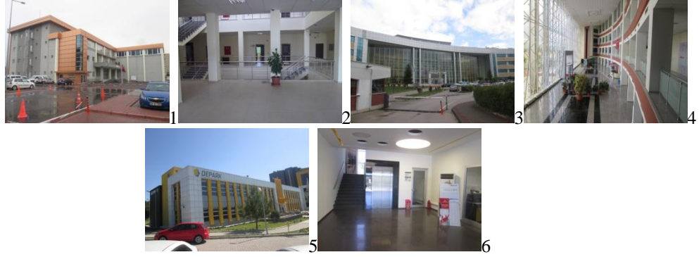
Şekil 4.25. Tekno 3 (1 ve 2), Ulutek Araştırma (3 ve 4) ve Alfa (5 ve 6) Binaları Bina Giriş Rampaları, Asansörleri
