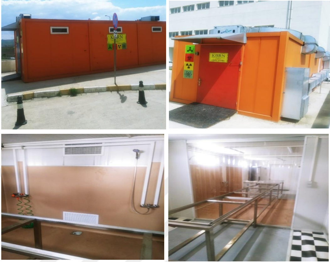
Şekil 2.5 Hatay Devlet Hastanesi KBRN Arındırma Ünitesi [64].
