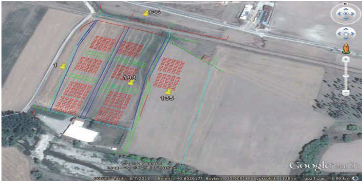
Şekil 35. Çerkeş ilçesi geçici barınma alanı
