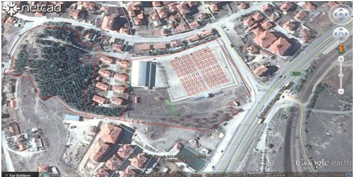
Şekil 29. Kurşunlu İlçesi geçici barınma alanı
