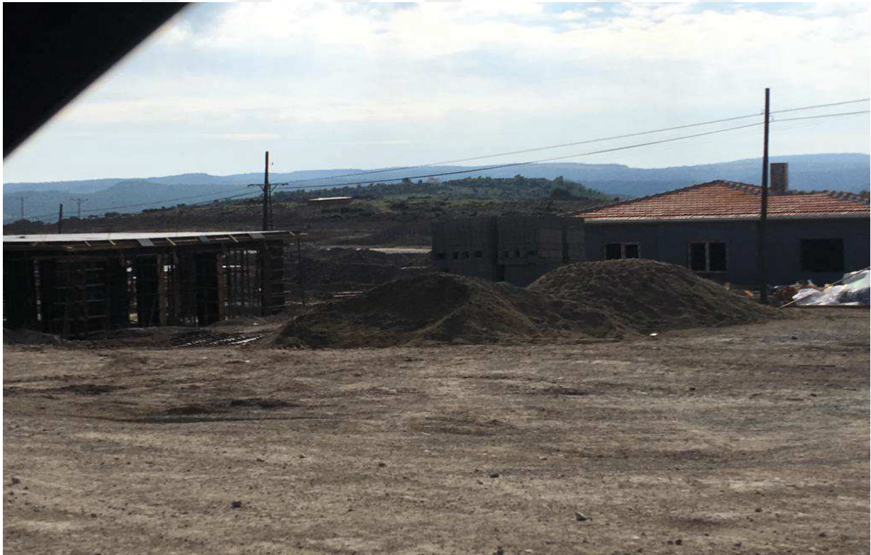
Fotoğraf 6. Yukarıköy kalıcı konut inşaatı 16.3.2019
