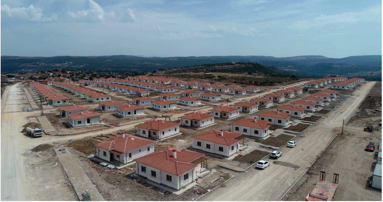
Fotoğraf 7. Çanakkale-Ayvacık Depremi Yukarıköy kalıcı konutları ( www.sözcü.com.tr , 2017)
