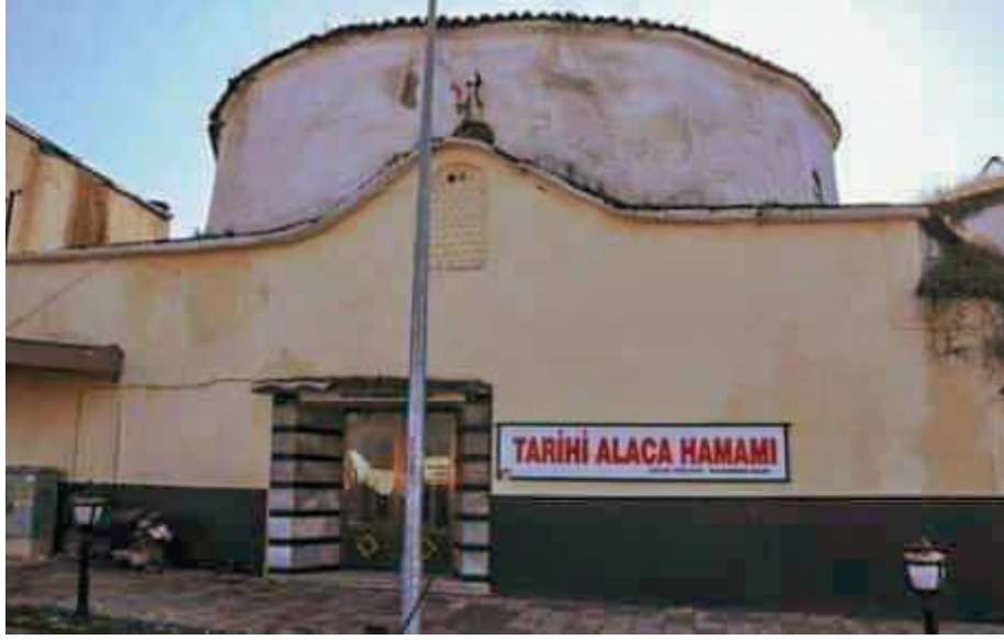
Fotoğraf 43. Bakım ve onarımı yapılmadığı için bugün oldukça kötü durumda olan Alaca Hamamı.
