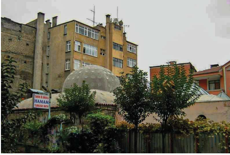
Fotoğraf 42. Çarpık yapılaşma sonucu şehir yerleşmesinin içerisinde kalan Sekiz Direkli Hamam.
