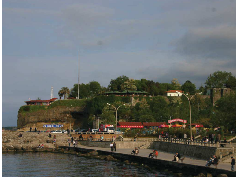
Fotoğraf 10. Günümüzdeki haliyle Güzelhisar (Ganita) batı cephesi.
