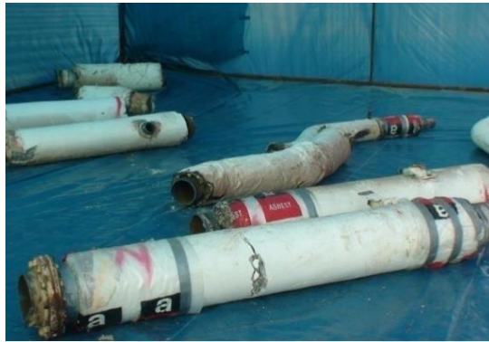
Resim 20. Etiketlenmiş Asbestli Malzeme (İSGÜM, 2014).
