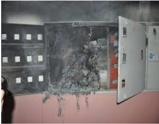
Şekil 9. Tekstil Sektöründe Yangına Neden Olmuş ve Doğru Düzenlenmiş Yangın Panoları (Anonim, 2017).
