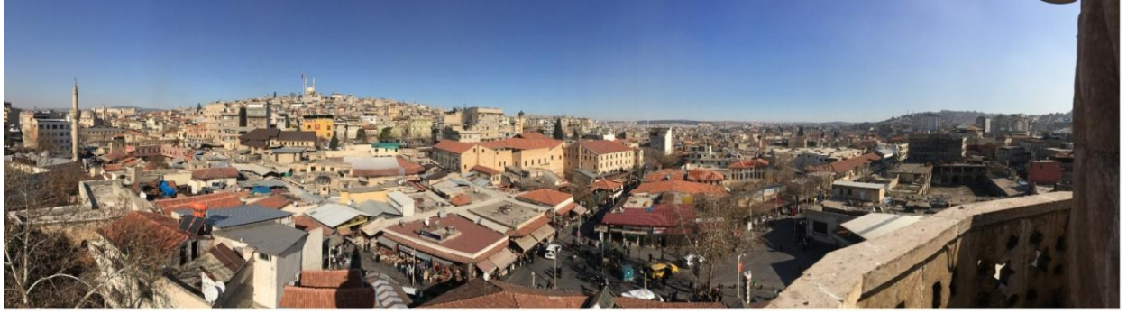
Şekil 30. Hacı Nasır Cami minaresinden çalışma alanı panoramik görüntüsü, 2017
