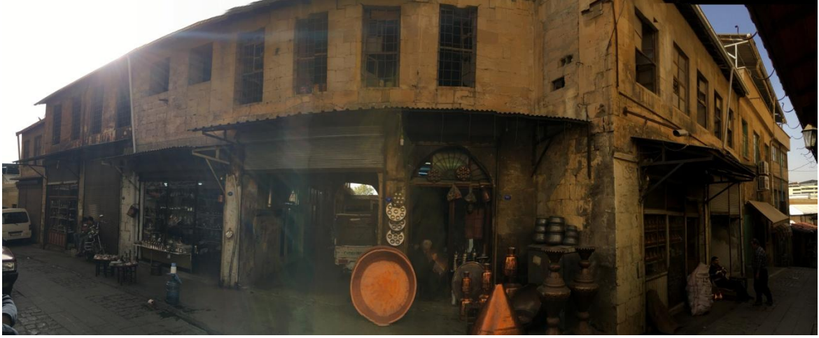
Şekil 58. Pir Sefa Un Fabrikası'nın günümüz işlevi
