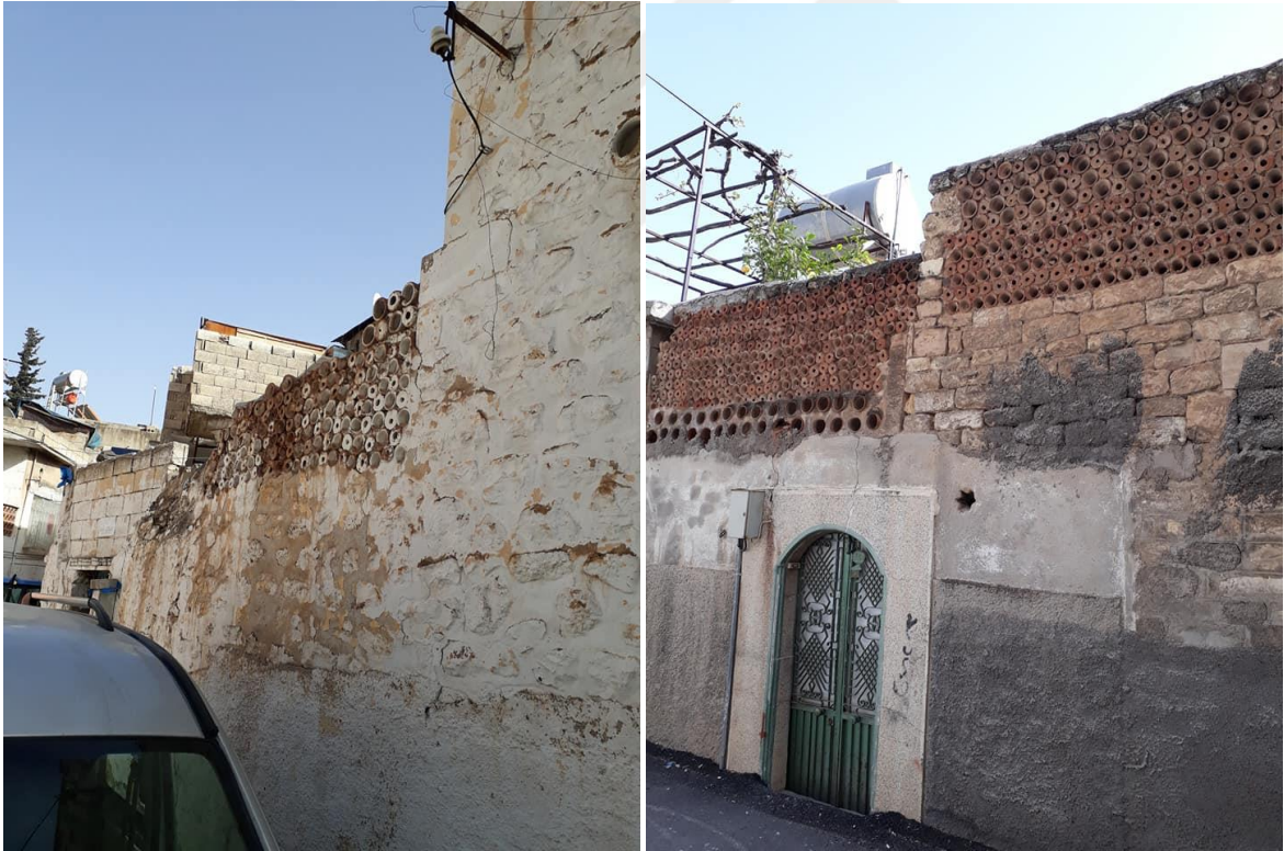
Şekil 71: Belli Yükseltiden Sonra Sokak Duvarlarının Delikli Yapılışı (Berbah), 2018
