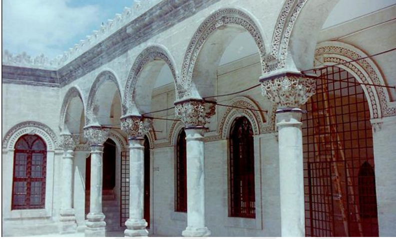
Şekil 157: Revak örneği, Mardin (Kaya, 2012)
