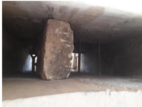
Şekil 151: Kilis Belediye Konukevi'nin orta eyvanındaki havalandırma bacası, 2018
