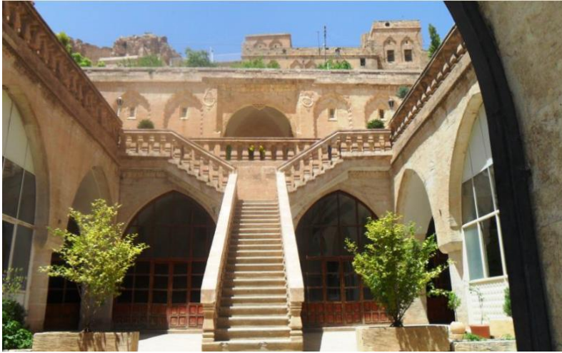
Şekil 158: Bir avlunun merkezinde u şeklinde dizilmiş revaklar, odalar ve eyvanlardan oluşan bir yapı, Mardin (Kaya, 2012).
