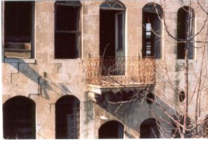
Şekil 190: Balkon (tescilsiz yapı) (Dik, 2006)
