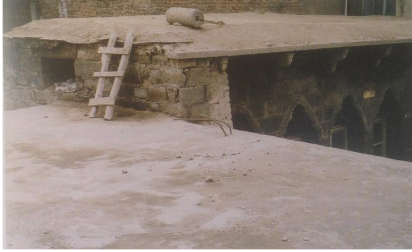
Şekil 177: Toprak örtülü düz dam ve loğ taşı (Yıldız, 2011).
