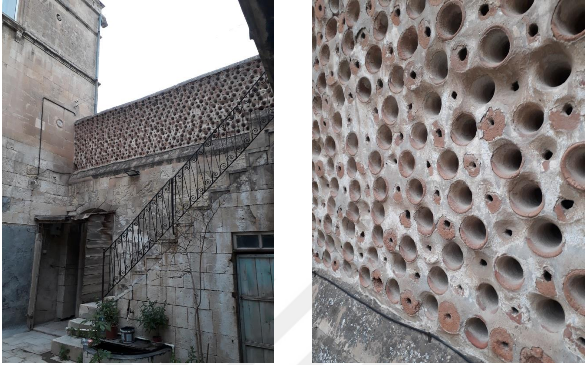
Şekil 72: Belli Yükseltiden Sonra Sokak Duvarlarının Delikli Yapılışı (Berbah, 2018)
