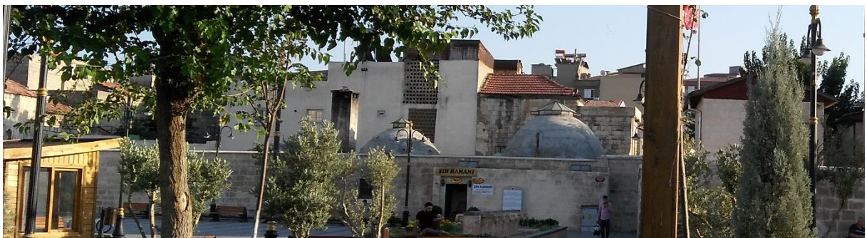
Resim 99 Restorasyon sonrası hamam cephe, 2018
