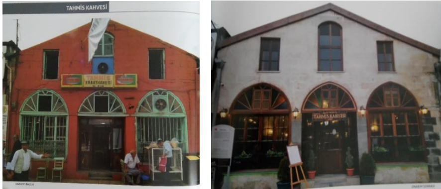
Resim 28 Tahmis Kahvesi Soldaki 2011 öncesi, Sağdaki Restorasyon Sonrası 2016 Kaynak: V.E.D.B., 2016: 114-115
