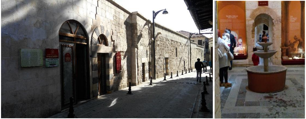
Resim 15 Restorasyon Sonrası Müze Olarak Kullanılan Hamamdan Görünüm 2018
