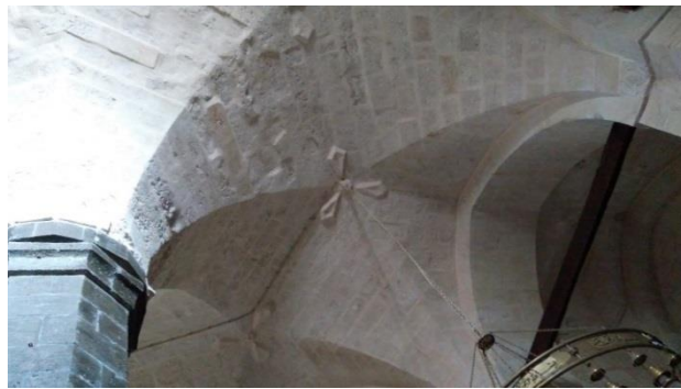
Resim 52 Sekiz Kollu Yıldız Oluşturan Yelpaze Tonozun Sivri Kemere Bağlanması ve Üç Kollu Kabartma Pervane Motifi 2018
