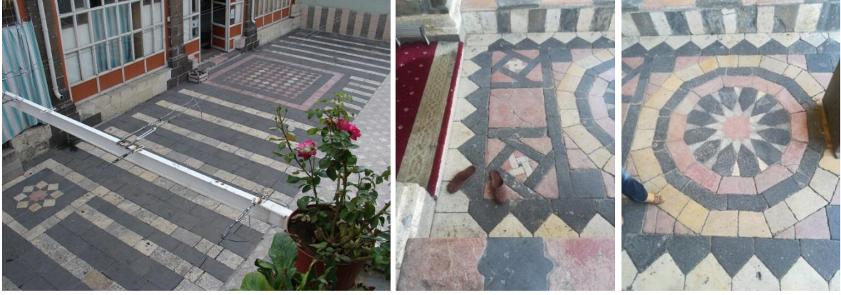
Resim 56 Soldaki Avlu (Z08) Renkli Taş İşçilikli Zemin Döşemesi 2007 Öncesi, Ortadaki ve Sağdaki Son Cemaat Yeri önü Renkli Taş İşçilikli Zemin Döşemesi 2018
