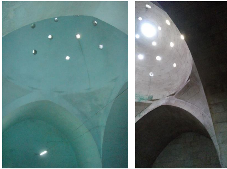
Resim 92 Iıkkılık bindirmeli üçgen geçişli dairesel ışık gözlü kubbe Soldaki 2008, Sağdaki 2018 Kaynak: Soldaki G.V.B.M.
