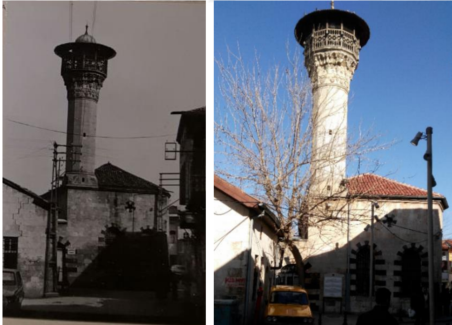
Resim 6 Kozluca Manzumesi Camii; Soldaki 1976, Sağdaki 2018 (Restorasyon Sonrası) Kaynak: Soldaki G.K.T.V.K.K.B.M. (Tescil Fişi Resmi)
