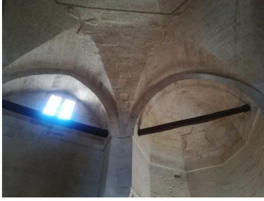
Resim 50 Manastır Tonozu, Sivri Kemer ve Yepaze Tonozun Gömme Ayağa Bağlanması, Gergi Çubukları 2018.
