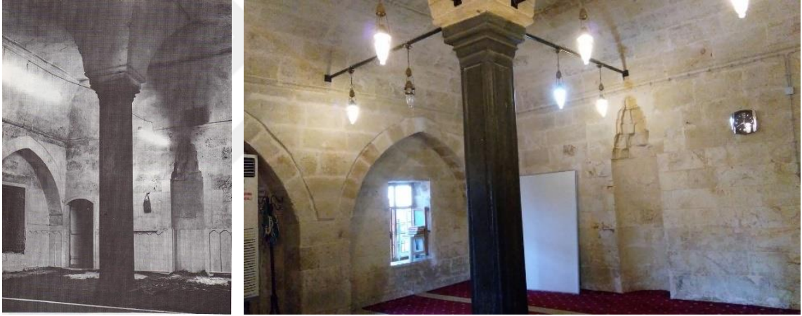
Resim 68 Zaviyeden Görünüm; Soldaki 1989, Sağdaki 2018 Kaynak: Soldaki (Çam, 1989: 34)
