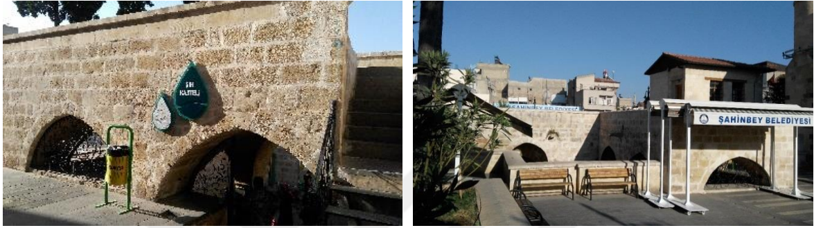
Resim 83 Avludan Kastle görünümü 2018 (Restorasyon sonrası)
