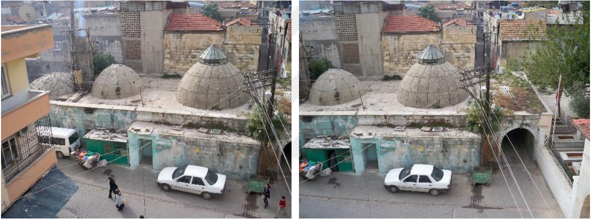
Resim 98 Hamam ve Kabaltıdan görünüm 2008 Kaynak: G.V.B.M.
