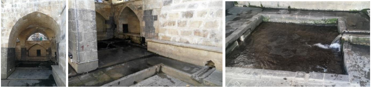
Resim 82 Kastelin Batı, Güney Duvarı ve Havuzun Restorasyon Sonrası görünümü 2018
