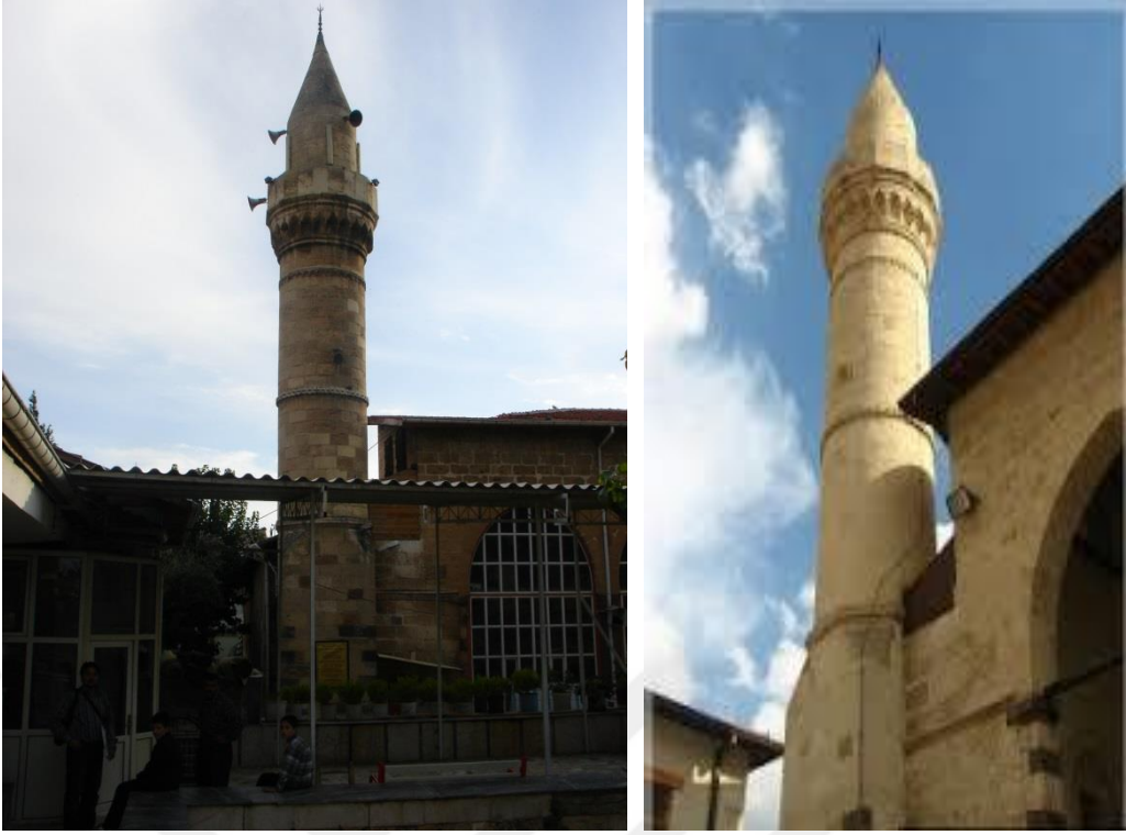
Resim 60 Şeyh Fetullah Camii Minaresi (Şekil 39) ( Z07);Soldaki 2007 öncesi, Sağdaki 2018
