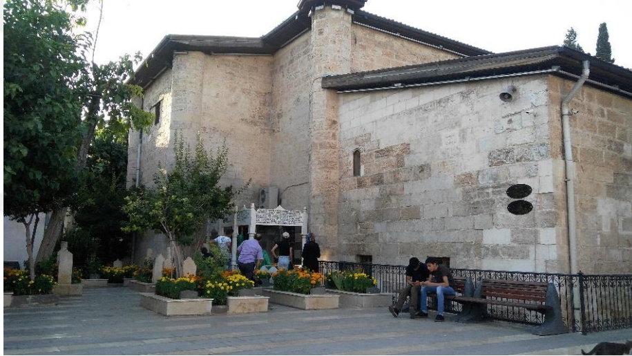
Resim 49 Şeyh Fetullah Camisi ve Zaviyesi Güney Cephe, 2018
