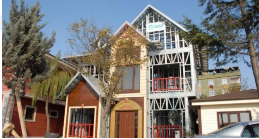
Resim 5 : Ön Yapımlı Yapı Elemanlarının Kullanıldığı Konut
