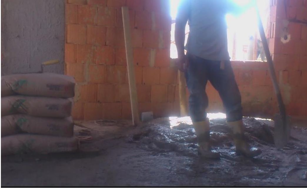
Resim 2. Geleneksel Duvar Harcınının Hazırlanması
