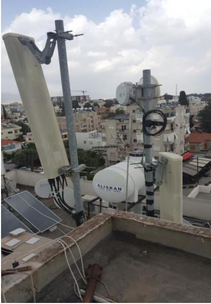
Resim 5: KKTC Lefkoşa'da bulunan bir baz istasyonunda kullanılan bir sektörel anten
