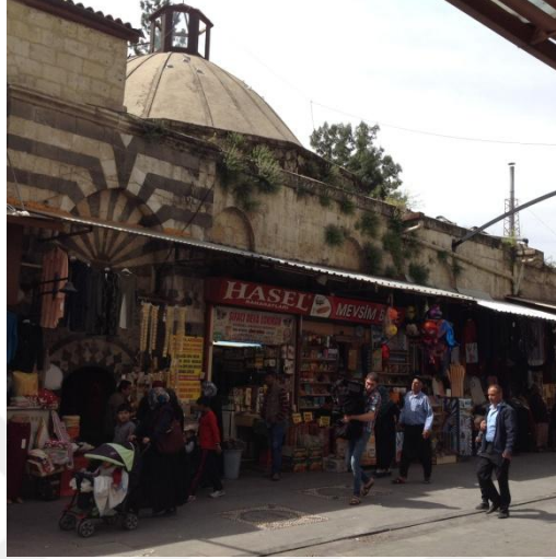
Şekil 70. Hüseyin Paşa Hamamı, dış cephe görüntüsü (2018)
