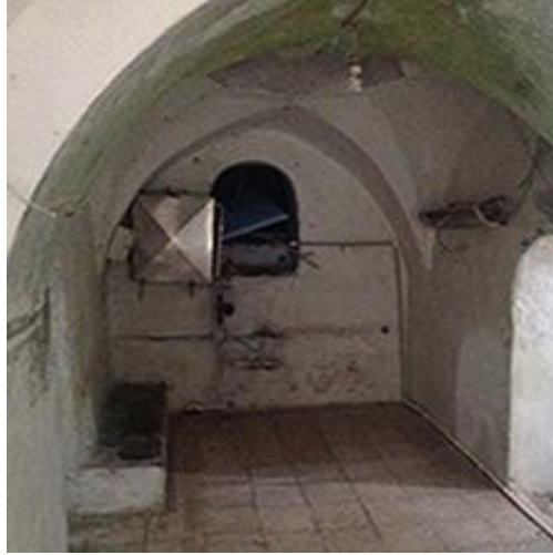
Şekil 47. Keyvanbey Hamamı, su deposuna açılan kapak görüntüsü (2017)
