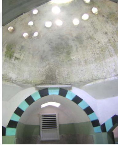
Şekil 55. Tabak Hamamı, su deposu kapağı görüntüsü (GVBM, 2006)
