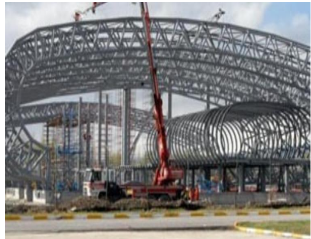
Resim 4.4.3. Terminal binası taşıyıcı sistemi görünüş-2 ( http://wowturkey.com , 14 Nisan 2018'de erişildi).
