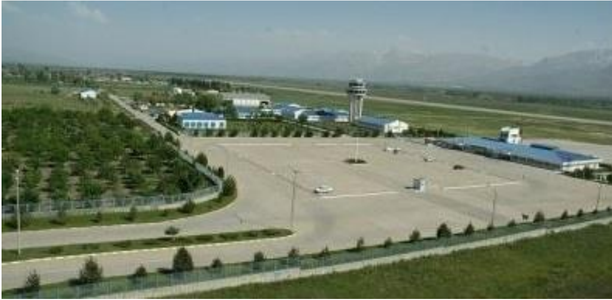
Resim 4.4.1. Erzincan Havalimanı eski terminal binası ( http://wowturkey.com , 14 Nisan 2018'de erişildi).
