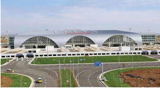
2.6.1. Diyarbakır Havalimanı görünüşü ( https://www.aydinlik.com , 2 Mayıs 2018'de erişildi).
