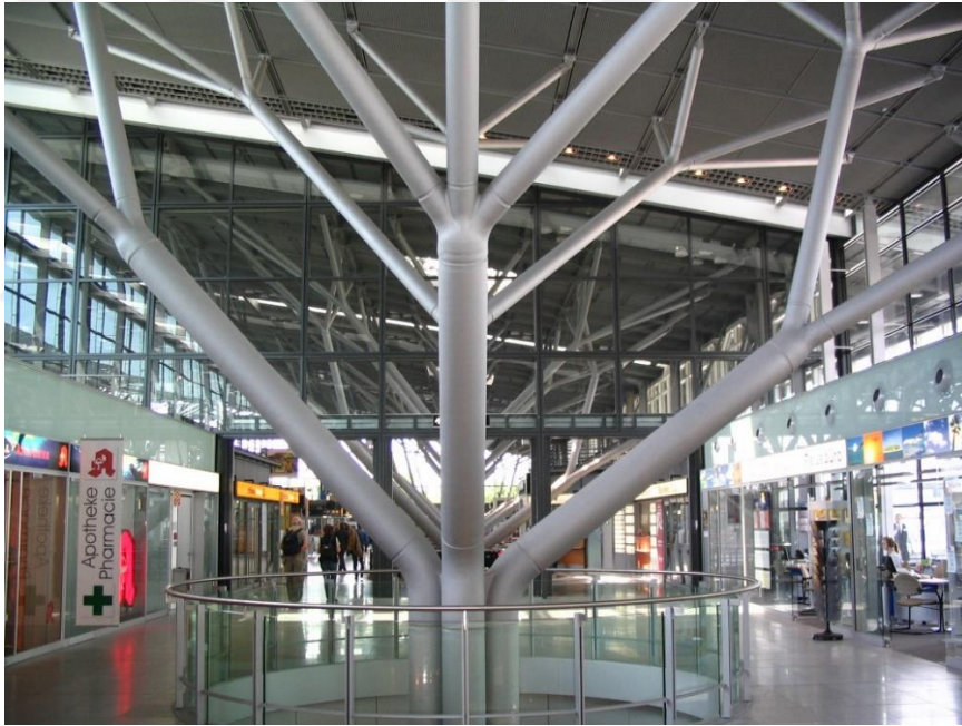
Resim 4.8.3. Terminalin ağaç şeklindeki taşıyıcısı ( https://commons.wikimedia.org , 20 Nisan 2018'de erişildi).
