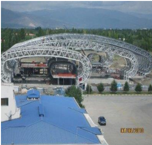
Resim 4.4.2. Terminal binası taşıyıcı sistemi görünüş-1 ( http://wowturkey.com , 14 Nisan 2018'de erişildi).
