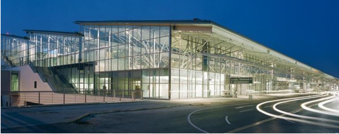
Resim 4.8.1. Stuttgart Havalimanı-Terminal 3 perspektif görünüşü (YEM Yayın, 2013: 70).
