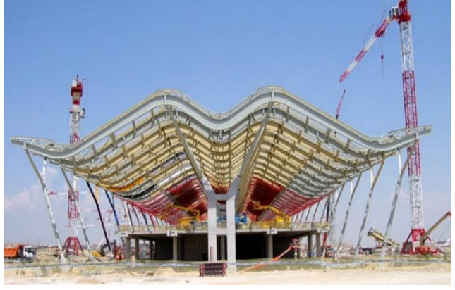
Resim 4.6.5. Terminal binası inşaatı, taşıyıcı sistem görünüşü ( http://constructalia.arcelormittal.com , 20 Nisan 2018’de erişildi).
