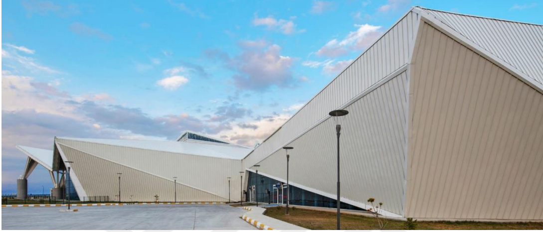
Resim 4.5.6. Terminal binası dış görünüşü ( http://www.arkiv.com.tr/ , 20 Nisan 2018'de erişildi).
