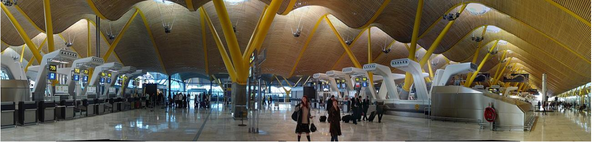
Resim 4.6.6. İç mekândan taşıyıcı ve çatı ilişkisinin görünüşü ( https://tripway.com , 20 Nisan 2018’de erişildi).
