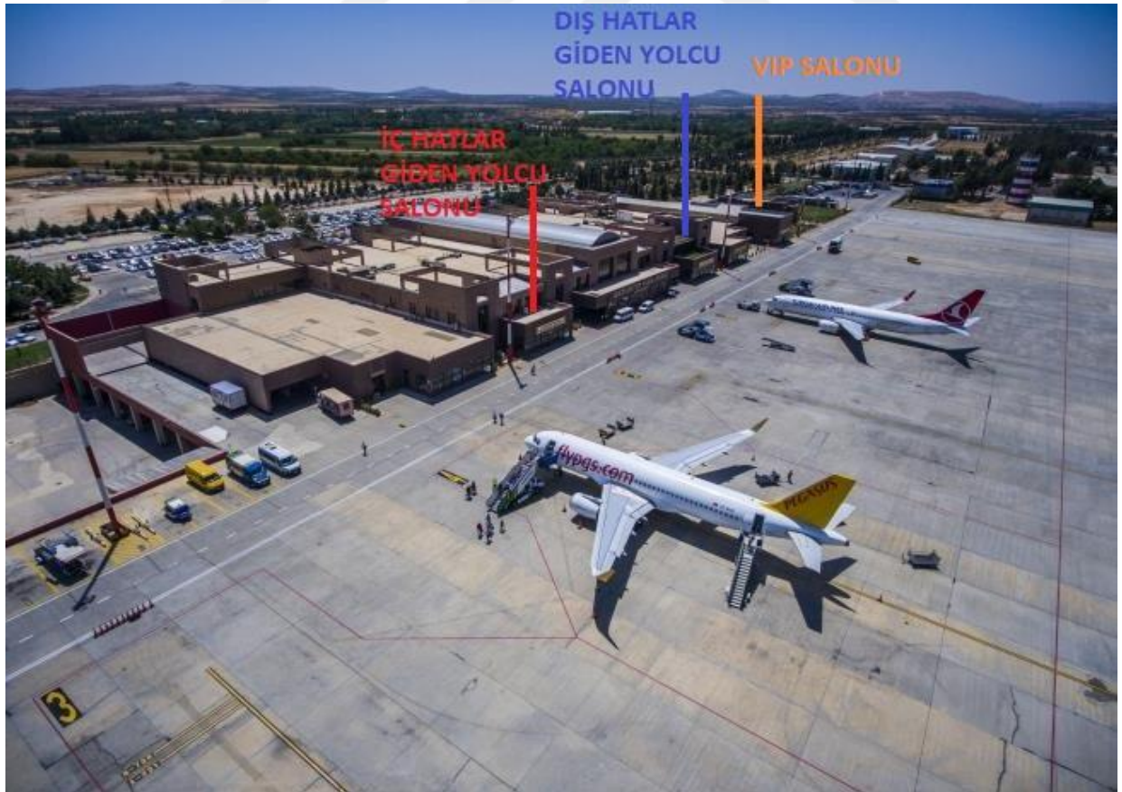
Şekil 4.1.10. Mevcut terminal binası apron görünüşü.
