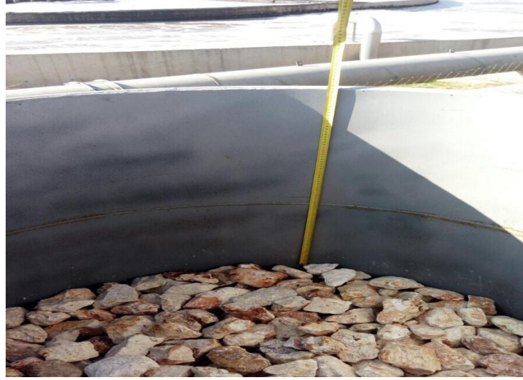
Resim 3.4. Reaktör içerisindeki dolgu malzemesi
