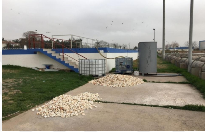
Resim 3.1. Reaktörün işletmeye hazır halinden bir görünüm
