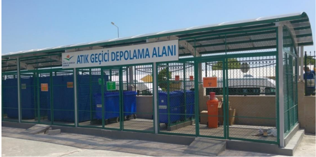
Şekil 2.14. Atık geçici depolama alanı
