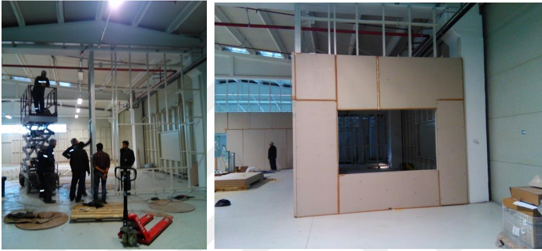
Şekil 7. Lidersan Ambalaj Fabrikası Ek Bina Şantiyesi, Tanrıverdi Gezer, Z.Ö. 2016
