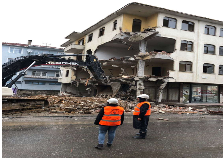
Resim 3.3. Uzman Personel ile Kontrollü Yıkım (Kocaeli Büyükşehir Belediyesi, 2017 )
