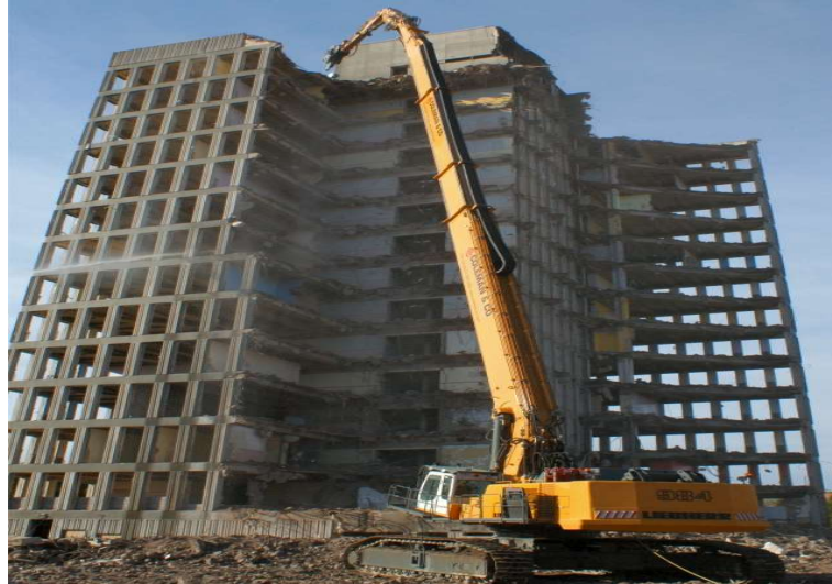
Resim 3.9. Uzun Erişimli Yıkım Makinesi İle Yıkım Tekniği (Kocaeli Büyükşehir Belediyesi, 2017 )
