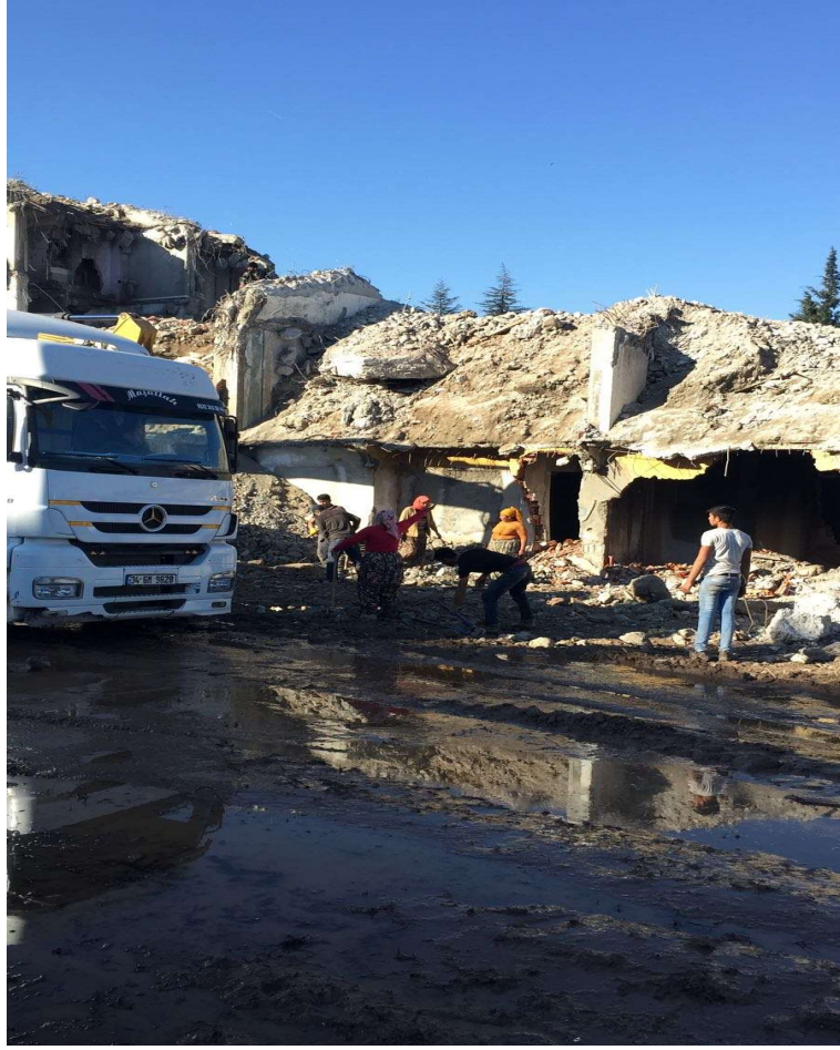
Resim 3.21. İzmit 42 Evler, Yıkım Çalışması (Kocaeli Büyükşehir Belediyesi, 2017 )
