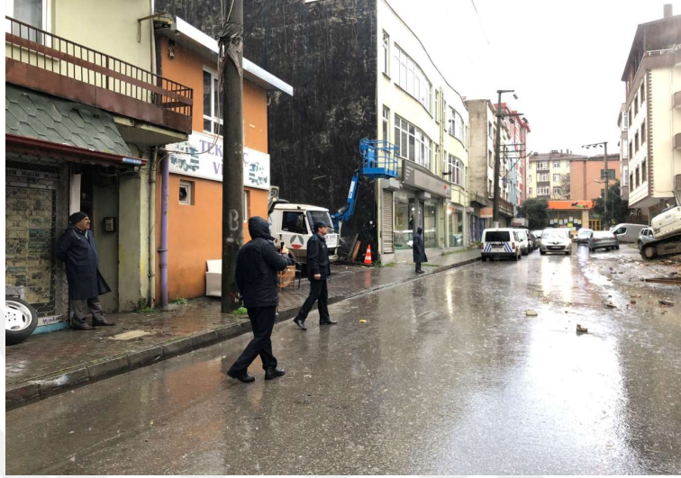
Resim 3.26. Yıkım Alanında Alınan Güvenlik Tedbirleri (Kocaeli Büyükşehir Belediyesi, 2017 )
