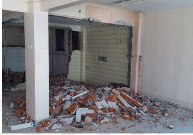
Resim 3.1. Yıkım Öncesi Bina Hazırlığı (Kocaeli Büyükşehir Belediyesi, 2017)
