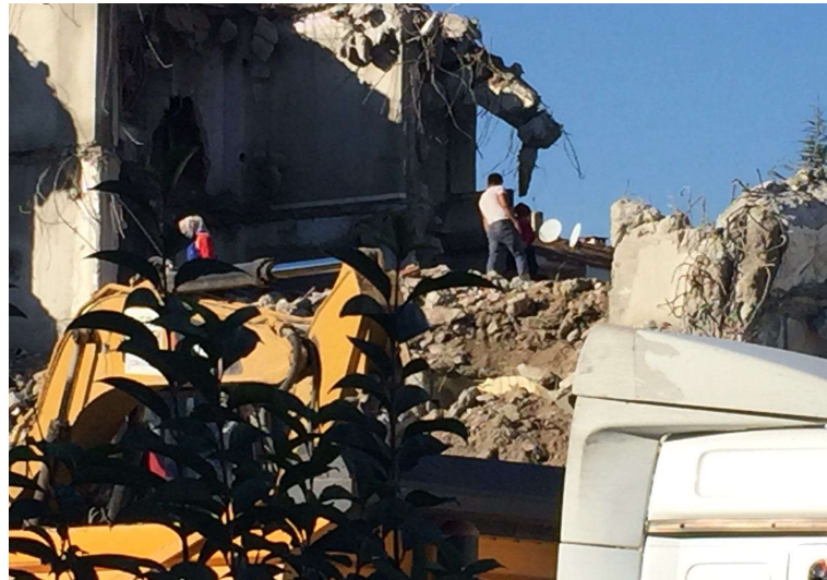
Resim 3.24. İzmit 42 Evler, Yıkım Çalışması (Kocaeli Büyükşehir Belediyesi, 2017 )
