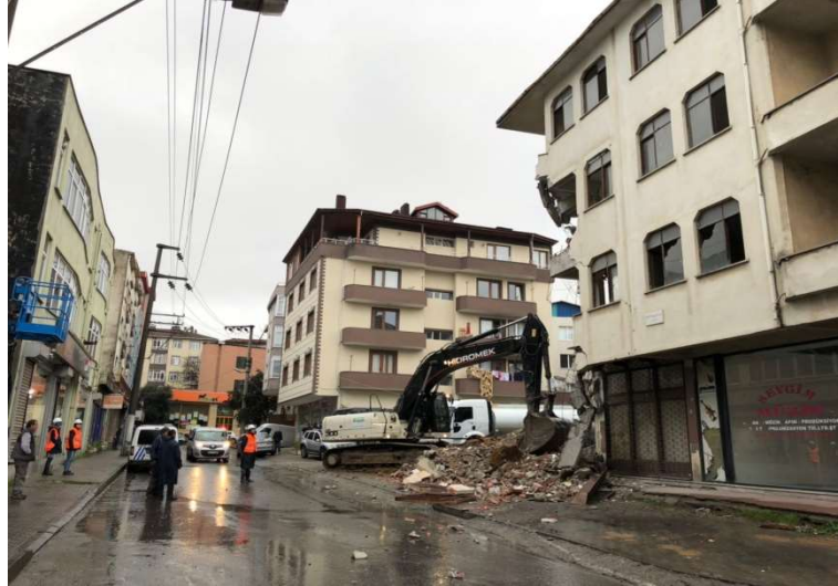
Resim 3.10. Ekskavatör İle Yıkım Tekniği (Kocaeli Büyükşehir Belediyesi, 2017)
