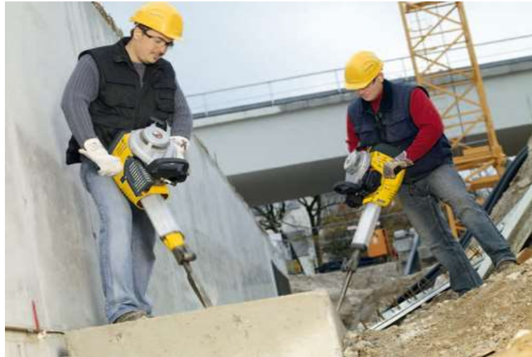
Resim 3.13. Kompresör İle Yıkım Tekniği (Yıkım İşlerinde İş Sağlığı Ve Güvenliği Yöntemleri)
