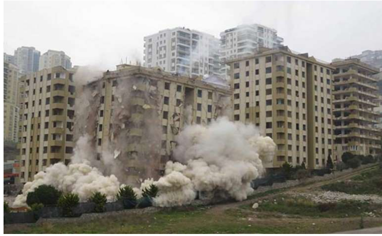
Resim 3.8. Patlayıcı Madde Kullanılarak Yıkım Tekniđi ( https://mehmetsaatci.wordpress.com/category/ ) 26.11.2012
