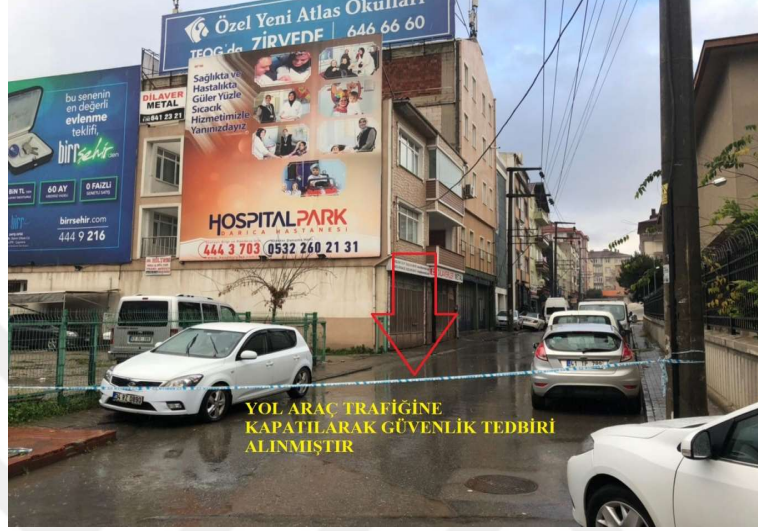
Resim 3.2. Yıkım Alanında Güvenlik Tedbirleri (Kocaeli Büyükşehir Belediyesi, 2017 )
