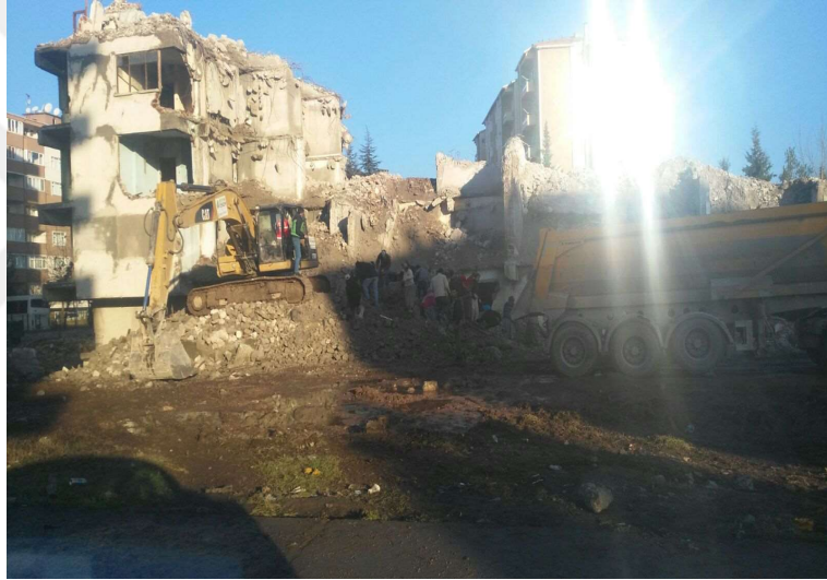
Resim 3.20. İzmit 42 Evler, Ekskavatör İle Yıkım Çalışması (Kocaeli Büyükşehir Belediyesi, 2017 )
