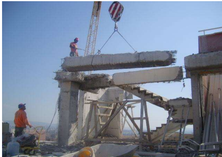
Resim 3.12. Beton Kesme Yıkım Tekniği (Yıkım İşlerinde İş Sağlığı Ve Güvenliği Yöntemleri)
