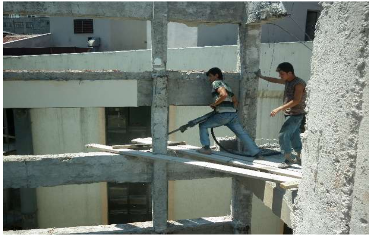
Resim 3.16. Yüksekte Güvensiz Çalışma (Yüksekte Çalışmalarda İş Sağlığı ve Güvenliği)
