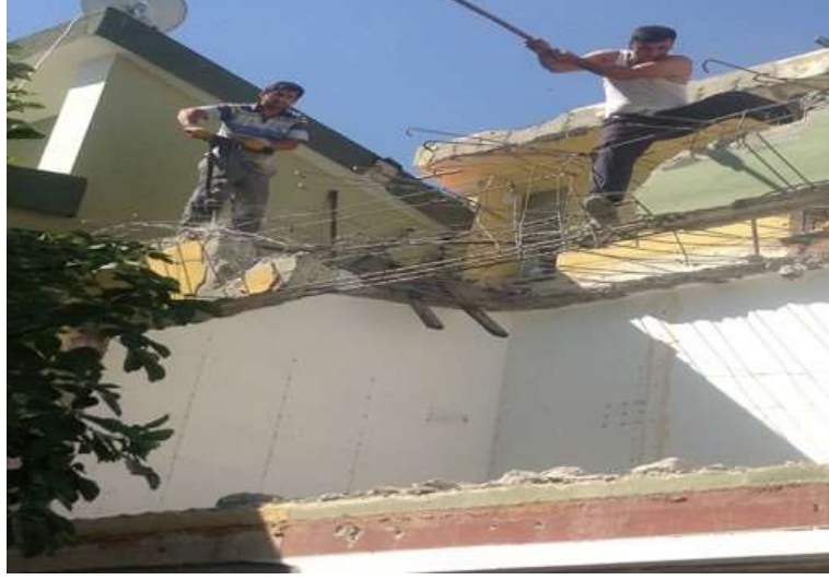
Resim 3.17. Yüksekte Güvensiz Çalışma (Yüksekte Çalışmalarda İş Sağlığı ve Güvenliği)
