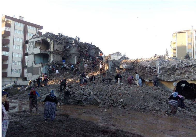
Resim 3.22. İzmit 42 Evler, Yıkım Çalışması (Kocaeli Büyükşehir Belediyesi, 2017 )
