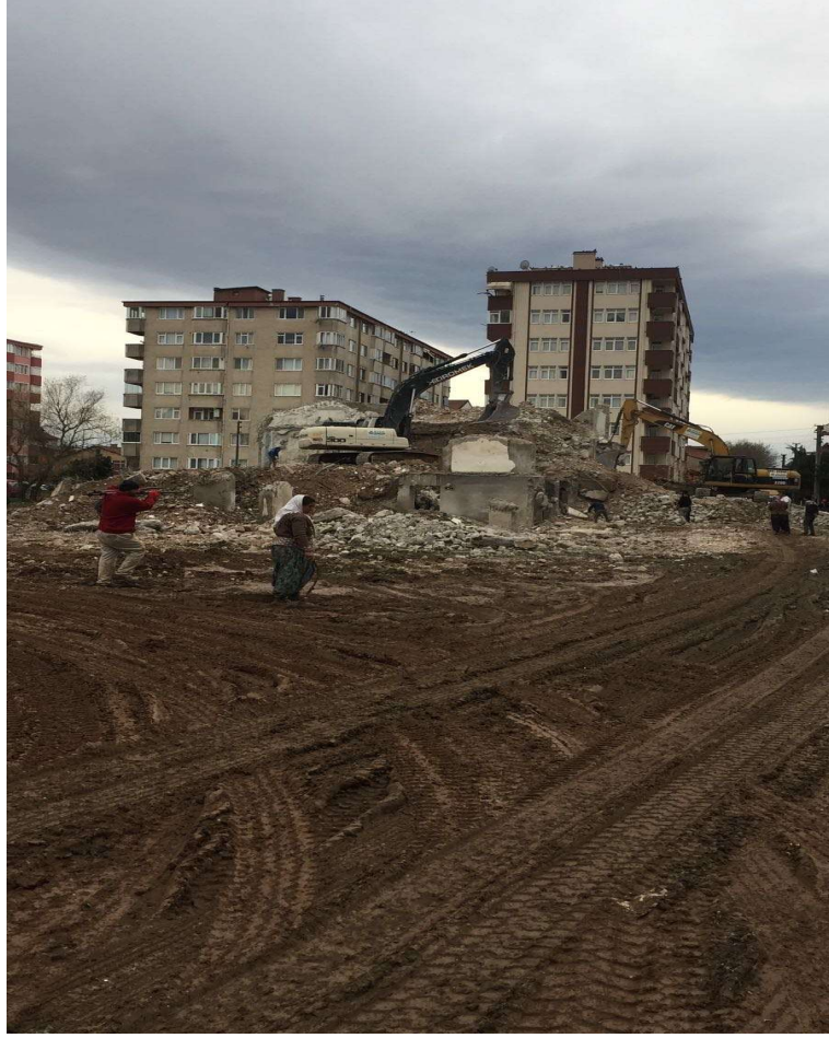
Resim 3.23. İzmit 42 Evler, Yıkım Çalışması (Kocaeli Büyükşehir Belediyesi, 2017 )
