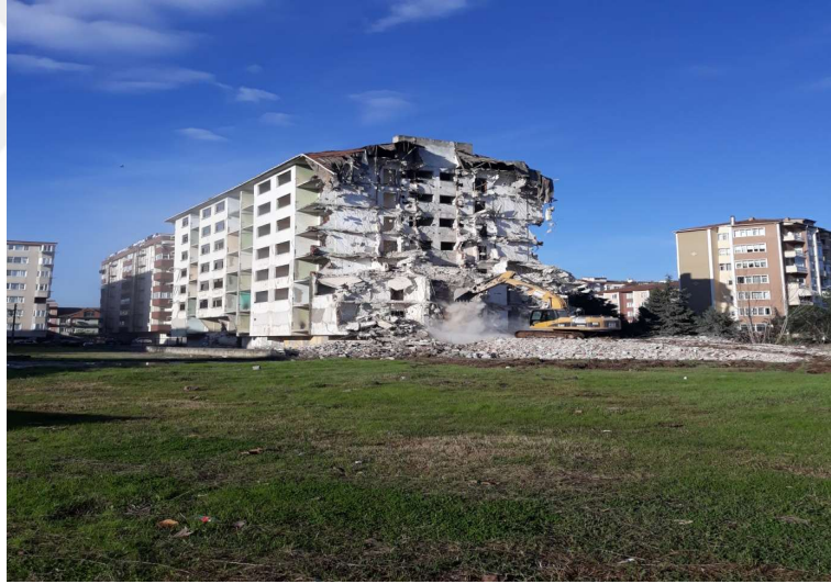
Resim 3.19. İzmit 42 Evler, Uzun Erişimli Makine İle Yıkım Çalışması (Kocaeli Büyükşehir Belediyesi, 2017 )
