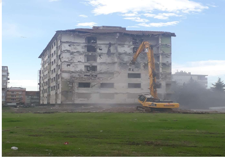
Resim 3.25. İzmit 42 Evler, Yıkım Çalışması (Kocaeli Büyükşehir Belediyesi, 2017 )
