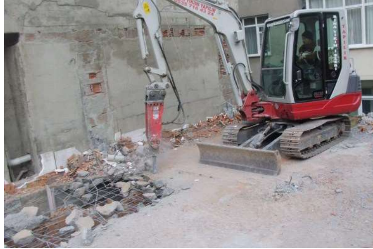
Resim 3.11. Mini Ekskavatör İle Yıkım Tekniği (Yıkım İşlerinde İş Sağlığı Ve Güvenliği Yöntemleri)
