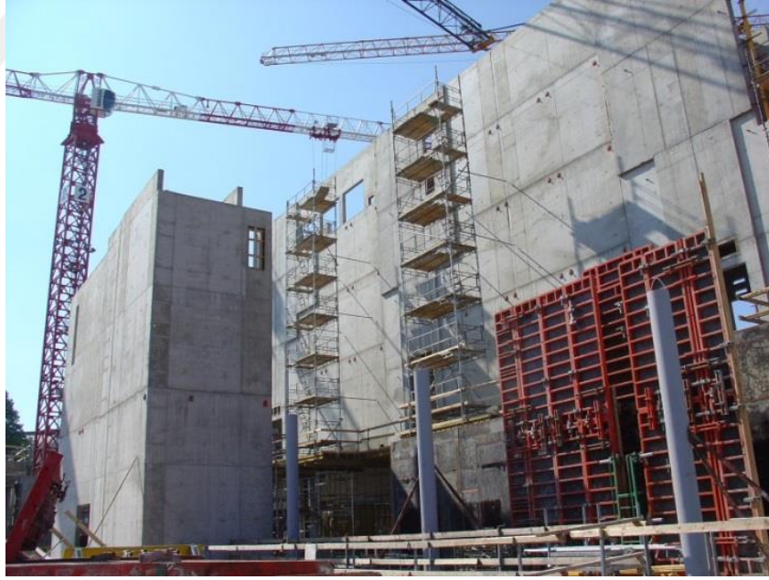
Şekil 4.45. Helsinki Müzik Merkezi yapım aşamasındadır.
