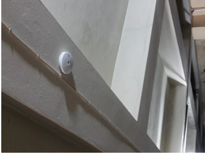
Şekil 4.4.Duman Algılama Dedektörü Uygulaması
