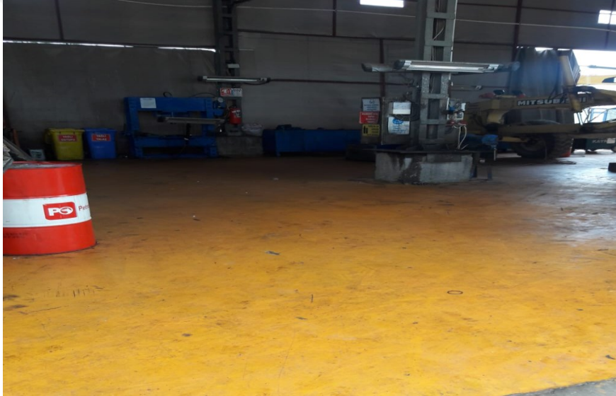
Şekil 4.16. Tamir Bakım Atölyesi Epoksi Zemin Uygulaması Sonrası
