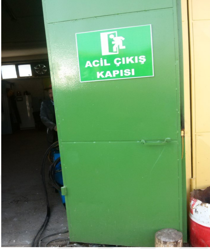
Şekil 4.8.Boya Atölyesi Acil Çıkış Kapısı Uygulaması
