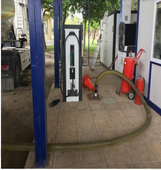
Şekil 4.44. Akaryakıt İstasyonu Yeni Hali-1
