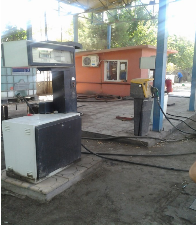
Şekil 4.43. Akaryakıt İstasyonu Eski Hali
