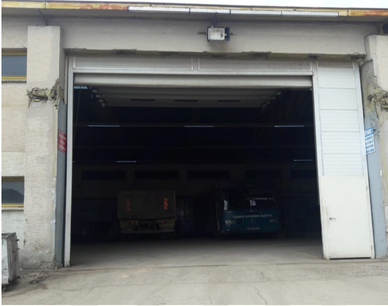
Şekil 4.10. Kamyon Tamir Atölyesi Otomatik Kapı Uygulaması
