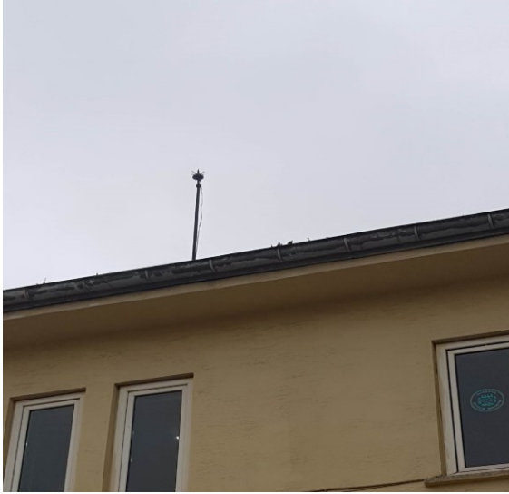
Şekil 4.31. Paratoner Uygulaması
