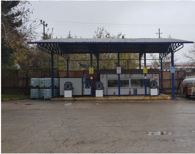
Şekil 4.45. Akaryakıt İstasyonu Yeni Hali-2
