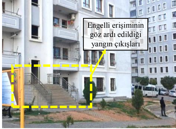
Umut Toplu Konut Alanı Engelli Erişiminin Gözardı Edildiği Yangın Çıkışları(Rampa Bulunmamaktadır.)
