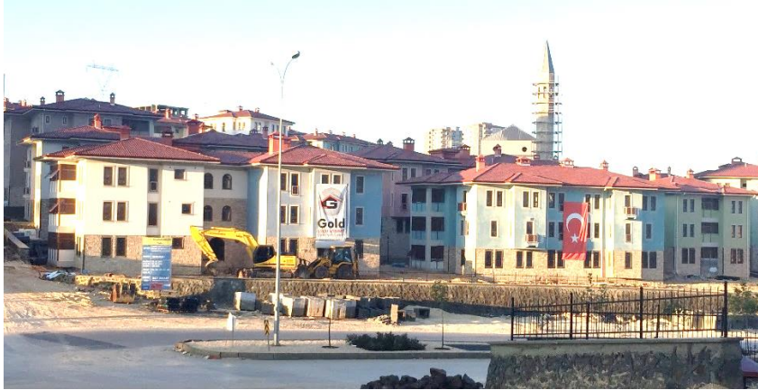
Beylerbeyi Toplu Konut Alanında Ada Sınırdaki Cepheleri Caddeye Bakan Konutlar
