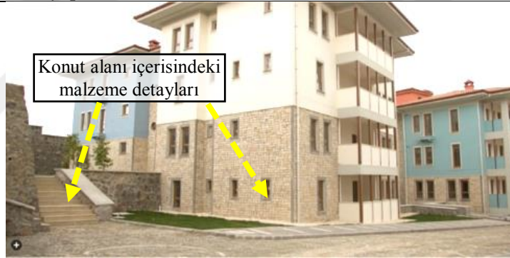
Beylerbeyi Toplu Konutları (Beylerbeyi Toplu Konut Alanı, 2018)
