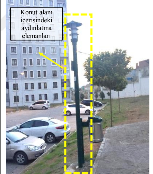
Umut Toplu Konut Alanı İçerisinde Aydınlatma Elemanları
