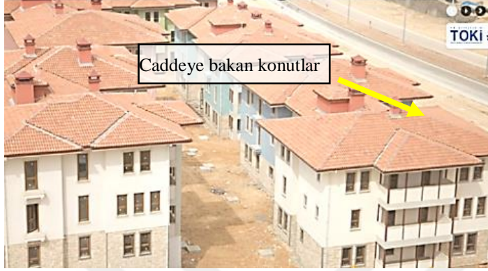
Beylerbeyi Toplu Konut Alanında Ana Caddeye Bakan Konutlar (Beylerbeyi Toplu Konut Alanı, 2018)
