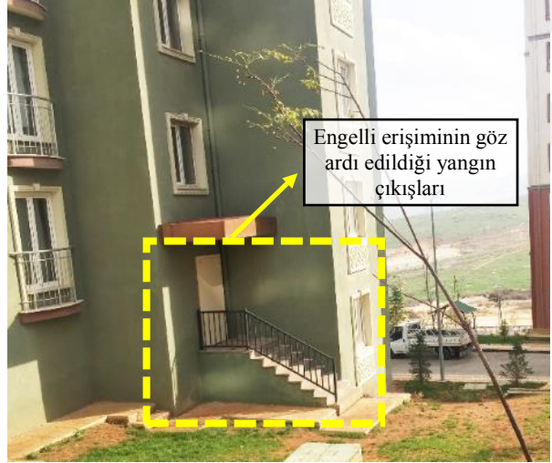
Kahvelipınar Toplu Konut Alanı Engelli Erişiminin Gözardı Edildiği Yangın Merdiveni Çıkışları(Rampa Bulunmamaktadır.)
