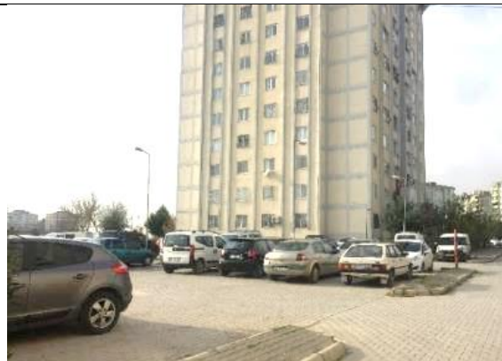
Karataş Toplu Konut Alanı İçerisindeki Açık Otopark Alanı
