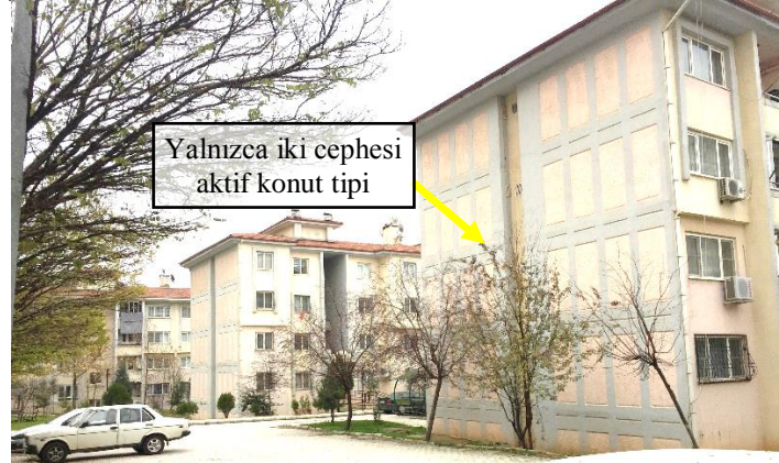
Karataş Toplu Konut Alanında Giriş Cephesi Ortak Alana Bağlanan Konutlar
