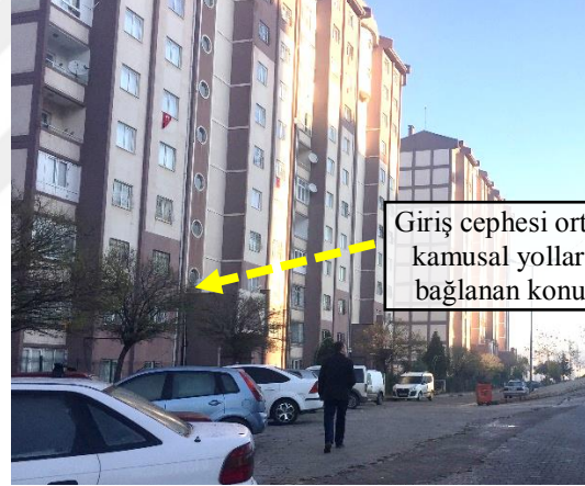
Çıksorut Toplu Konut Alanında Giriş Cephesi Ortak Yollara Bağlanan Konutlar
