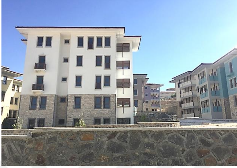
Beylerbeyi Toplu Konut Alanı Farklı Kotlardaki Konutlar
