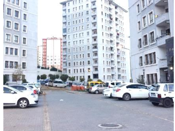
Umut Toplu Konut Alanı İçerisindeki Konut Tipleri Önündeki Açık Otopark Alanı
