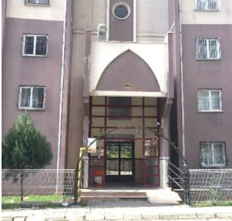
Çıksorut Toplu Konut Alanında Giriş Cephesi Ortak Yollara Bağlanan Konutlar
