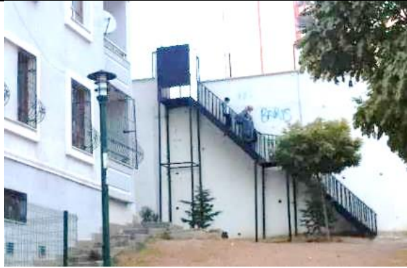
Yoldan alana içerisine geçişi sağlayan merdiven
