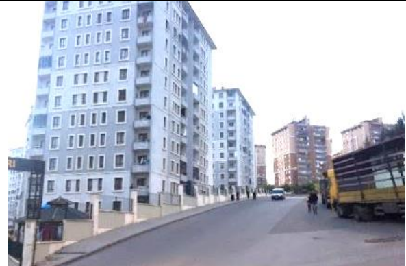
Yol ile alan arasındaki kot farkı
