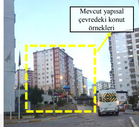
Umut Toplu Konut Alanı Çevresindeki Mevcut Yapı Örnekleri
