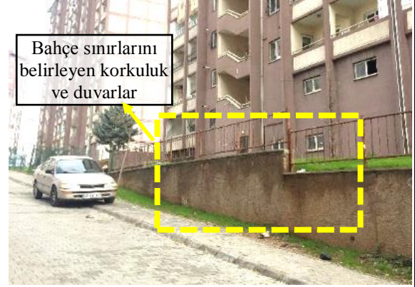
Toplu Konut Alanının Bahçe Sınırlarını Belirleyen Bahçe Duvarları
