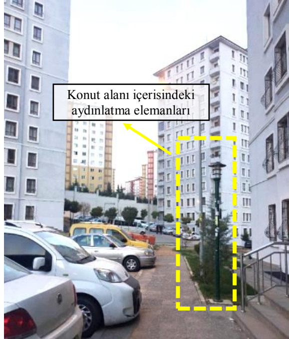
Umut Toplu Konut Alanı İçerisinde Aydınlatma Elemanları
