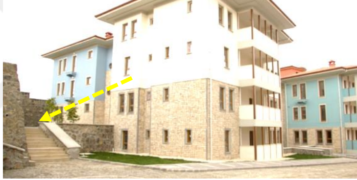
Beylerbeyi Toplu Konut Alanı Engelli Erişiminin Göz Ardı Edildiği Avlu Girişleri (Beylerbeyi Toplu Konut Alanı, 2018)( Rampa Bulunmamaktadır.)
