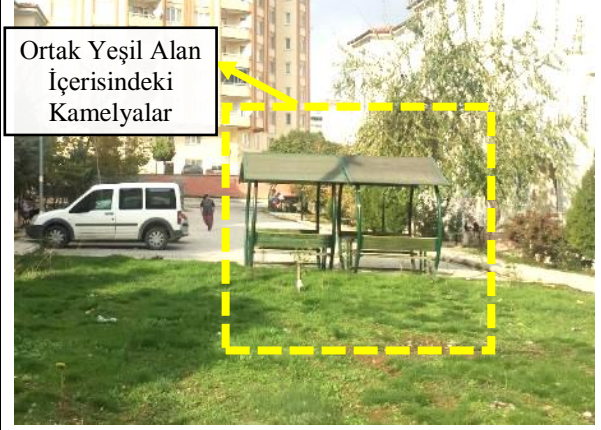
Karataş Toplu Konut Alanında Ortak Yeşil Alanlar İçerisinde Bulunan Kamelyalar
