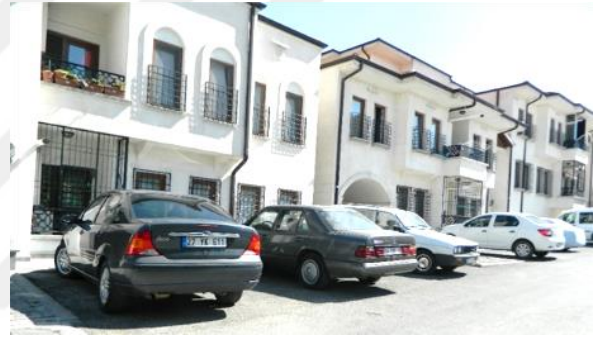
Yazıcık Toplu Konut Alanında Cepheleri Batıdaki Eğitim Alanına bakan Konutlar
