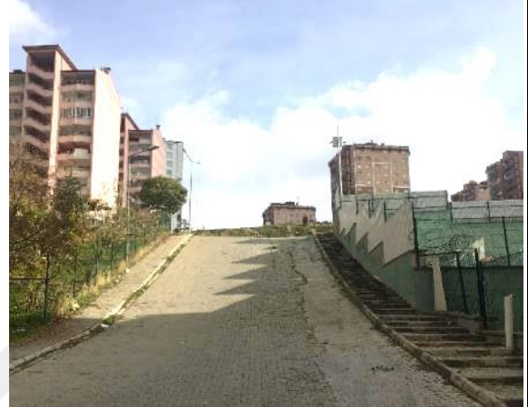
Çıksorut Toplu Konut Alanı Engelli Erişimine Uygun Olmayan Yaya ve Araç Yolları (Rampa Eğimi Uygun Değil)
