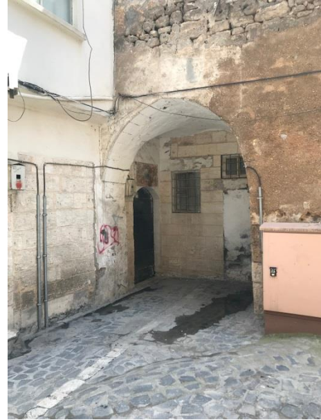
Şekil 4.7. Yapı Girişinde Kabaltı Görünümü
